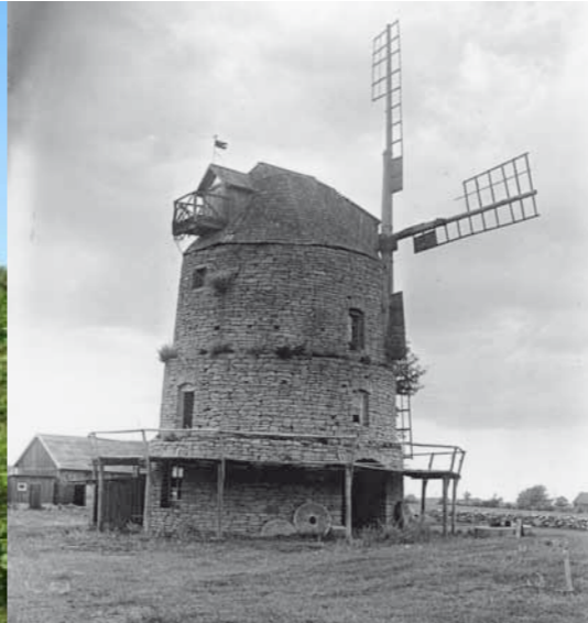
Högy stenkvorn 1933. Byggnadsminnesförklarad holländarkvarn som var i bruk fram till slutet av 1920-talet.
