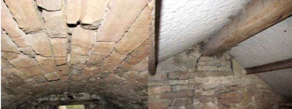
Valvslaget tak samt åstak men kalkstensflisor.
