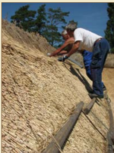
Vasstak under pågående läggning. Föra, norra Öland.
