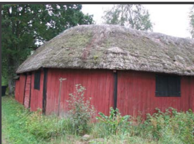
Ett för norra Öland karaktäristiskt krokhus med rundat, "dösat", hushörna. Moning med nät. Vedborm, Högby socken.
