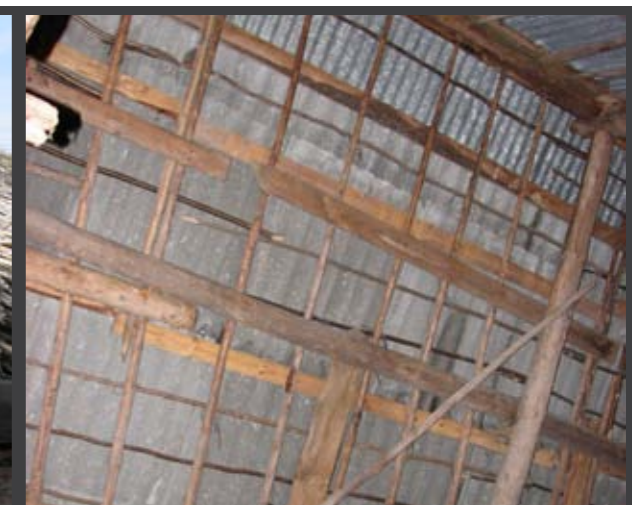
Under ett plåttak kan man hitta resterna av ett bevarat raveltak. Övetorp, Algotrum.
