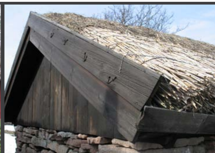
Exempel på sjöbod med hål i vindskivan för fäste av binderaften. Sjöbod i Horn, Högby socken, norra Öland.
