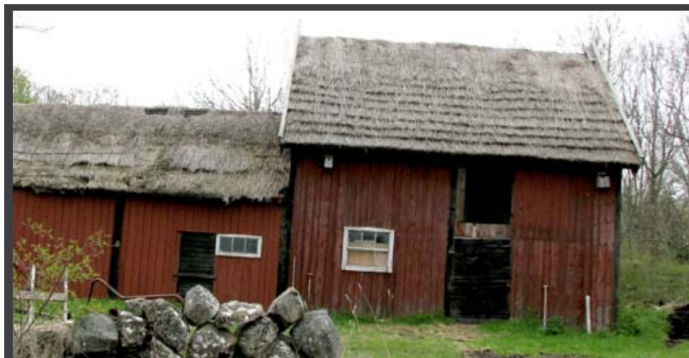
Vasstak lagt i etapper med raka kanter, en utrotningshotad metod. Horns kungsgård, norra Öland.
