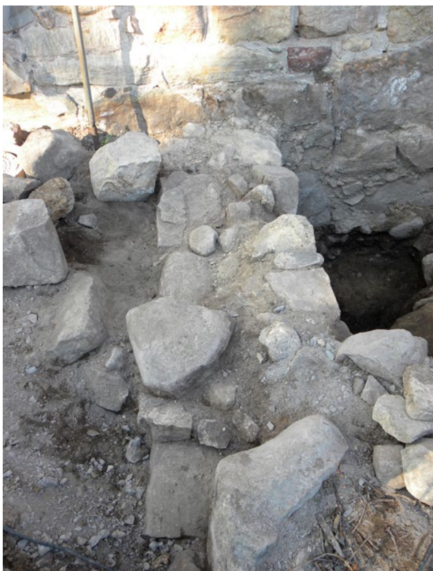
Figur 13. Den västra muren från S.
