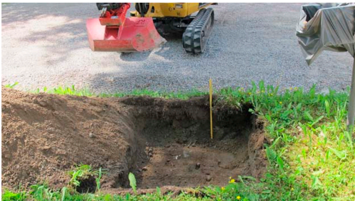
Figur 3. Schakt OS1009 vid skyltläge VI. Schaktet mätte ca 1,5 x 1,5 meter och var 0,60 meter djup. Foto mot väster.
