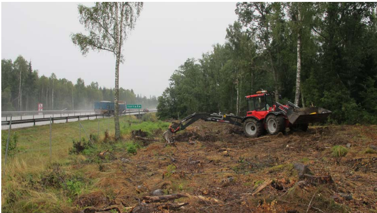
Figur 40. Schaktning vid Toftanäs på Objekt 34. Foto mot norr.
