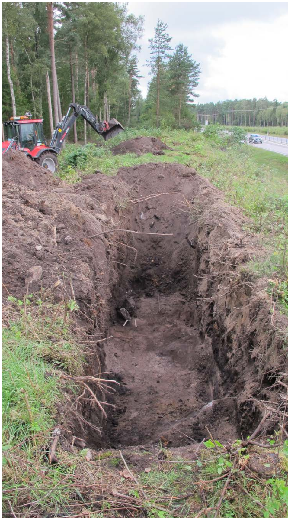
Figur 9. Den bitvis upp till ca 1,7 meter tjocka vällen med upplagda massor vid Objekt 7. Foto mot söder.
