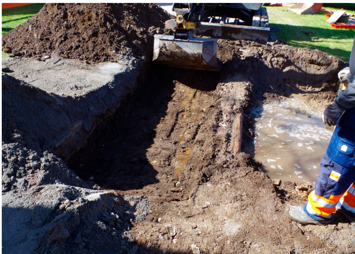
Figur 3. Friläggning av läckande ledning. Ytan sydöst om ledningarna grävdes ner till ca 0,9 meters djup medan ytan nordöst om (som på bilden är vattenfylld) grävdes ner till 0,40 – 0,50 meter. Foto från nordöst.
