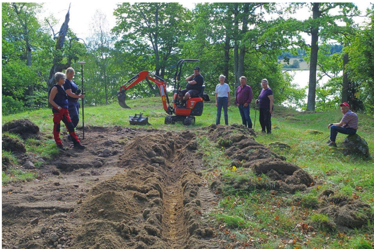
Figur 4. Schaktet uppe på Ekholmen grävdes med den minsta grävmaskinen. Deltagare från hembygdsföreningen tittar på.
