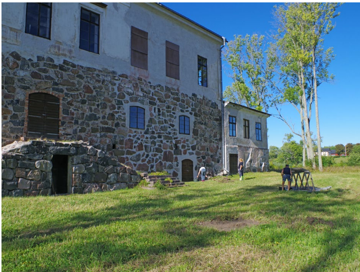
Figur 1. Baksidan av Vinäs slott.
