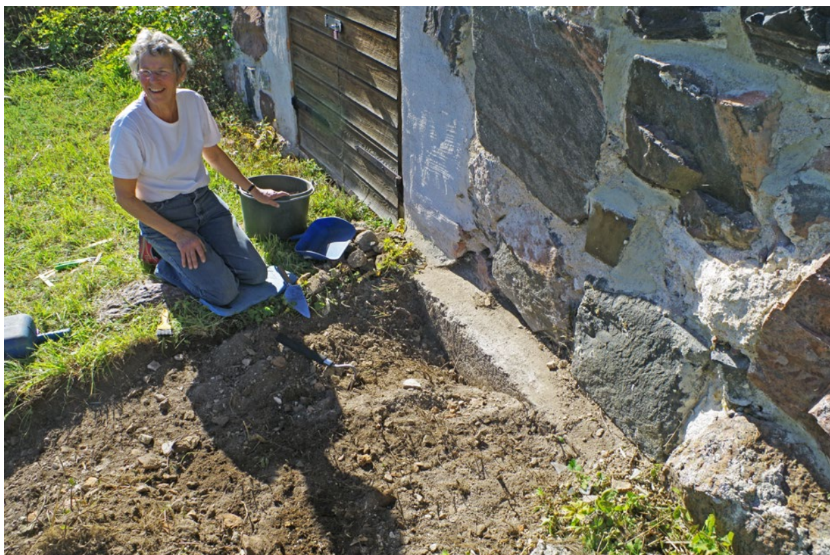
Figur 11. Ingela rensar fram betongförstärkningen på husgrunden.
