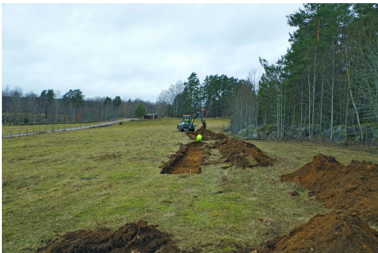
Figur 4a. Söschaktning inom åkerytan i den södra änden av undersökningsområdet. Foto från öster.
