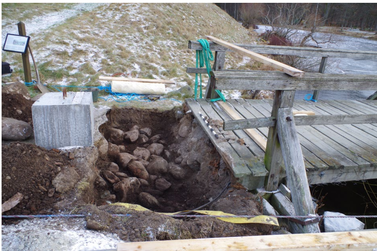
Figur 39. I de schakt som togs upp på Stallholmens nordvästra del fanns en kraftig stenpackning och denna del av ön är förmodligen en utfyllnad. Schakt 2 sett från väster.
