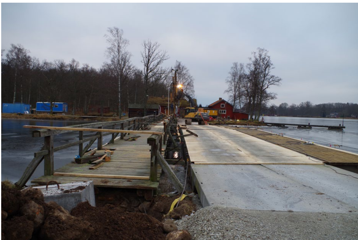
Figur 5. Bild från broarbetet med den gamla bron till vänster i bild och den provisoriska pontonbron till höger. Foto från norr.
