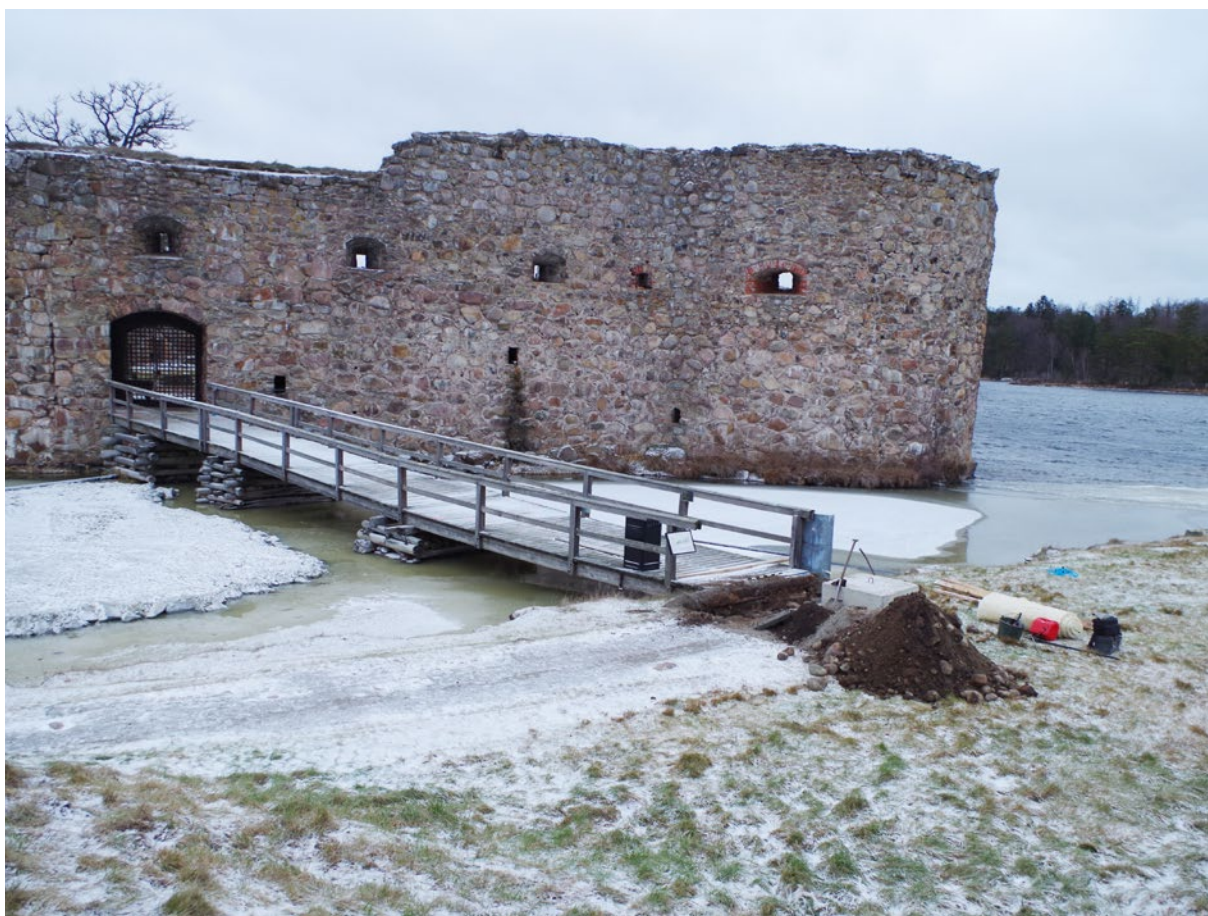
Figur 30. Schakt 1 togs upp vid fästet till bron mellan Stallholmen och Slottsholmen. Foto taget från sydväst.
