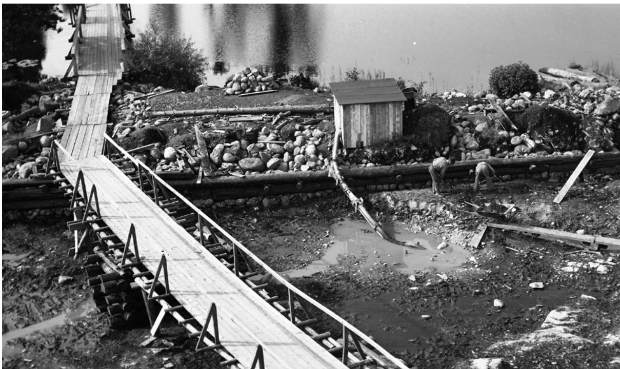
Figur 16. Foto taget efter att vallgraven tömts. Av fotot att döma lämnades sediment och trärester kvar på botten. Bobergs arkiv, Smålands museums topografiska arkiv.
