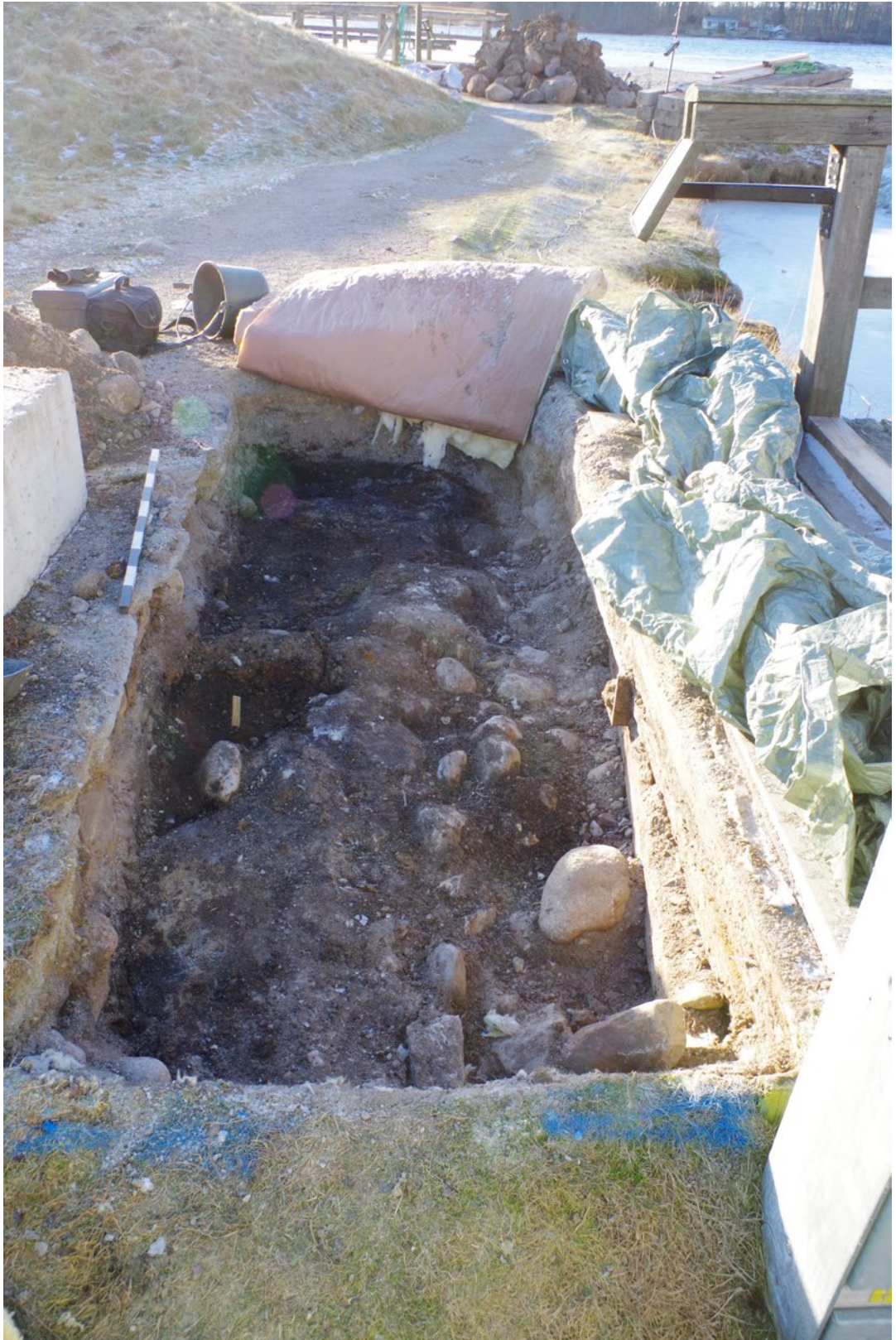
Figur 46. I schakt 1 fanns bevarade rester efter en äldre strandskoning mellan Stallholmen och vallgraven. På foto syns lerlagret A11 och stenpackningen A13, som hörde till denna strandskoning, från öster.
