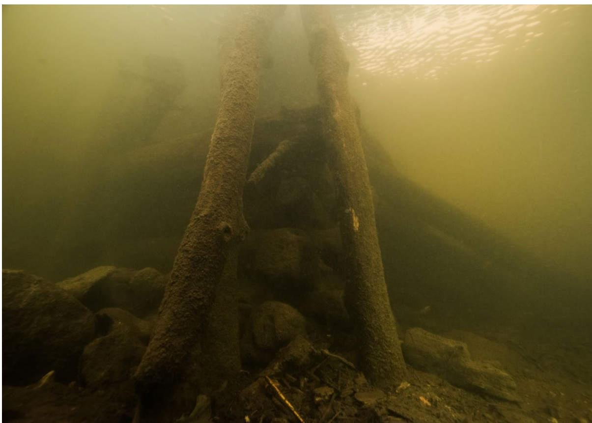
Figur 45. Den äldsta timmerkonstruktion, konstruktion A, hör samman med en äldre bro med annorlunda sträckning än de senare broarna. Foto taget under dykningar 8 november 2016.
