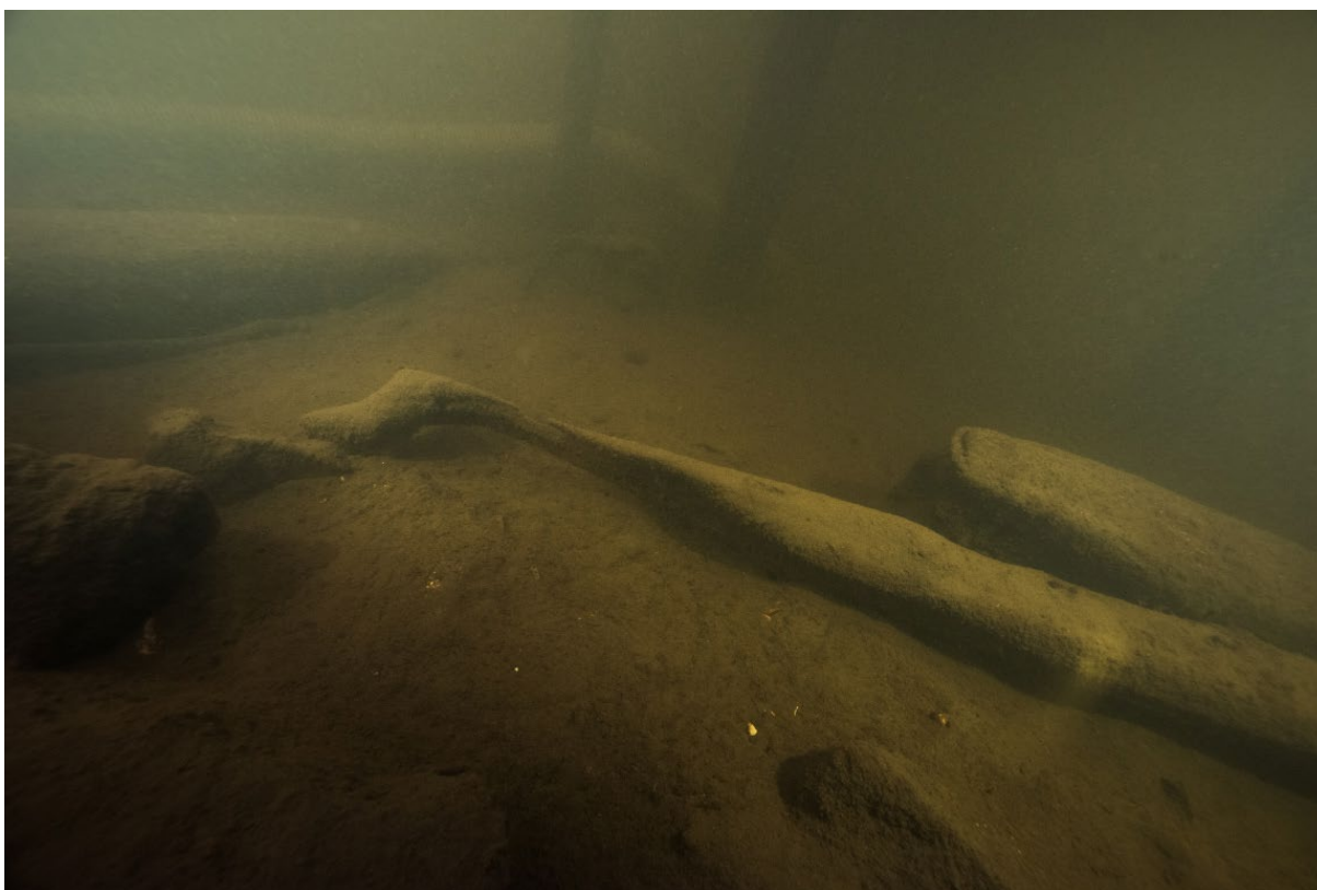
Figur 24. Delar av den äldre bron, konstruktionen A, i avsnittet mellan stenkista 3 och 4. Foto taget under dykning 8 november 2016.
