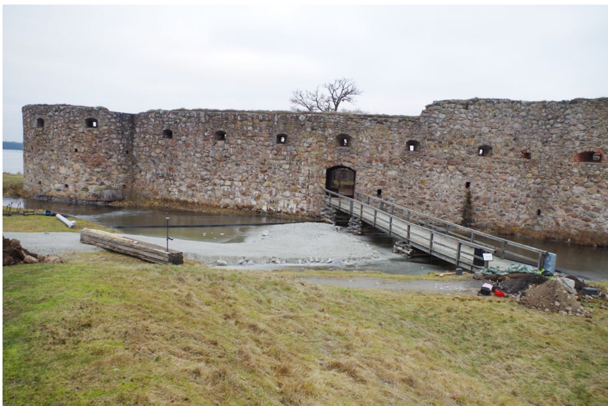
Figur 28. Eftersom det inte visade sig finns några fynd eller lämningar kvar inom vallgraven kunde en arbetsväg läggas ut på botten i samband med brobyggnationen. Foto taget från söder innan rivningen av den gamla bron.
