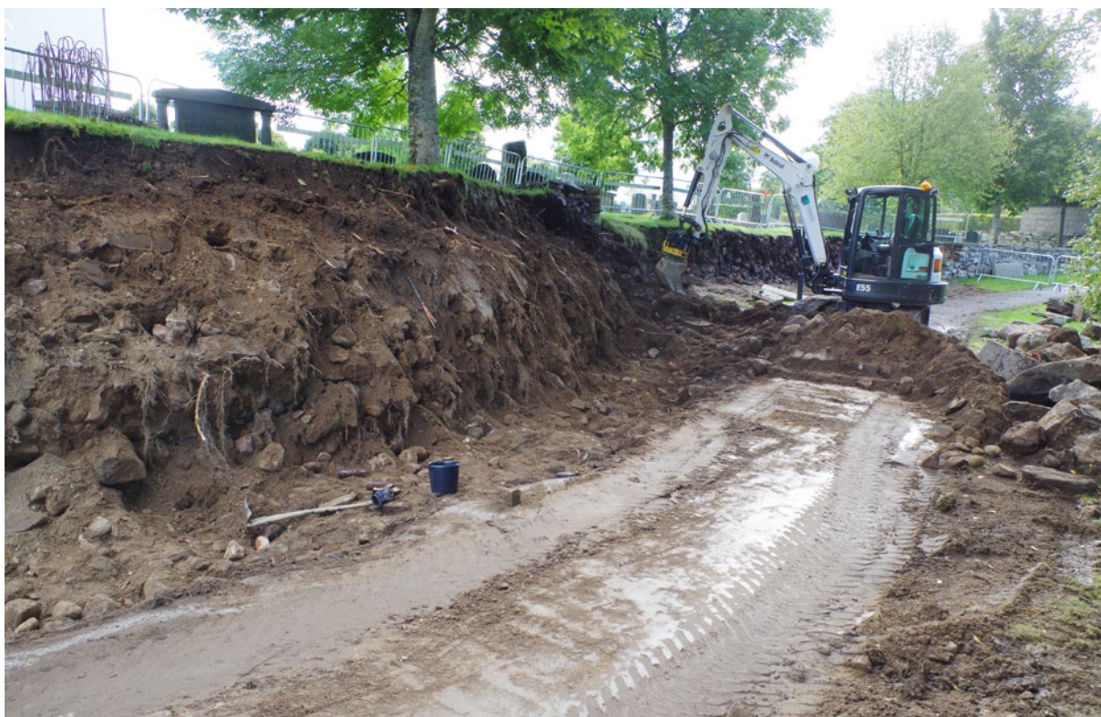
Figur 11. Under den rasade muren fanns enbart omrörda lager. Foto taget efter att man schaktat ned till murens bottennivå och släntat av ytan mot kyrkogården. Foto taget från nordväst.
