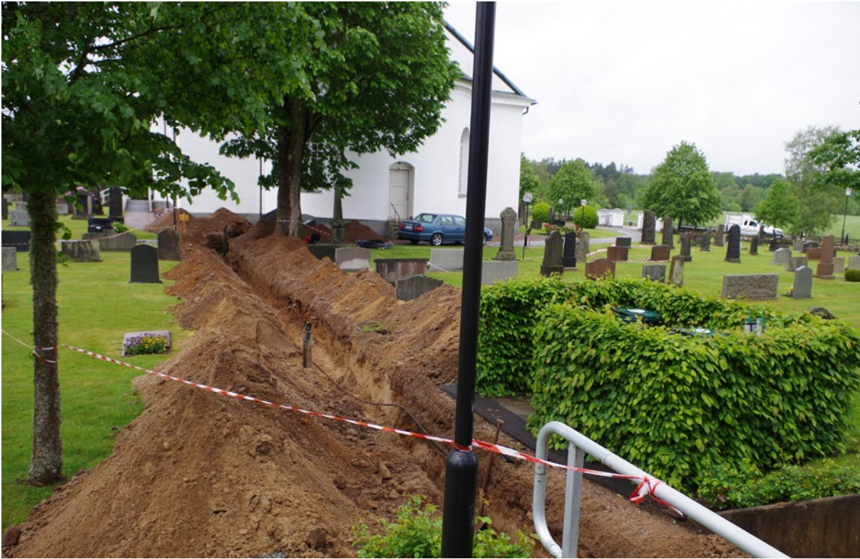
Figur 9. Schaktet öster om kyrkan. Gränsen mellan omrörd och orörd kyrkogårdsmark gick strax hitom det större trädet. Foto taget från öster.
