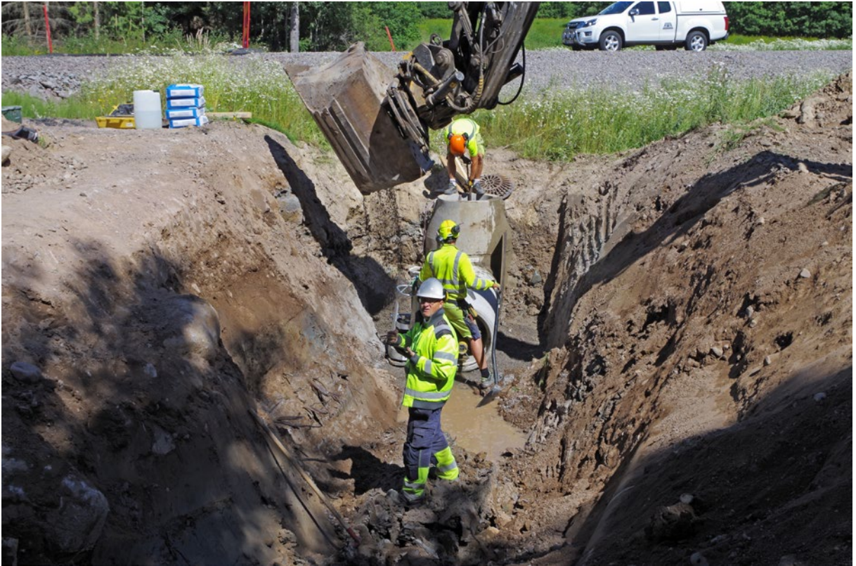
Figur 4. Ledningsschaktet under pågående undersökning. Foto från söder. Foto: Kalmar läns museum.
