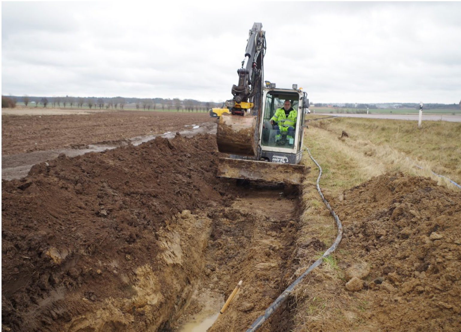
Figur 6. Vid ledningsarbetet matjordsavbanades först en två meter bred yta där påträffade anläggningar undersöktes. Därefter grävdes det smalare ledningsschaktet.
