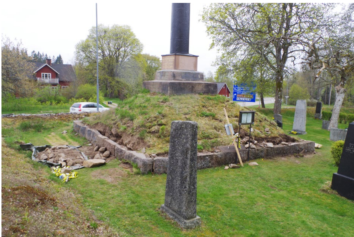
Figur 4. Vid renoveringsarbetet togs smala handgrävda schakt upp på insidan av den stensockel som omger gravmonumentet. Foto taget från nordöst.
