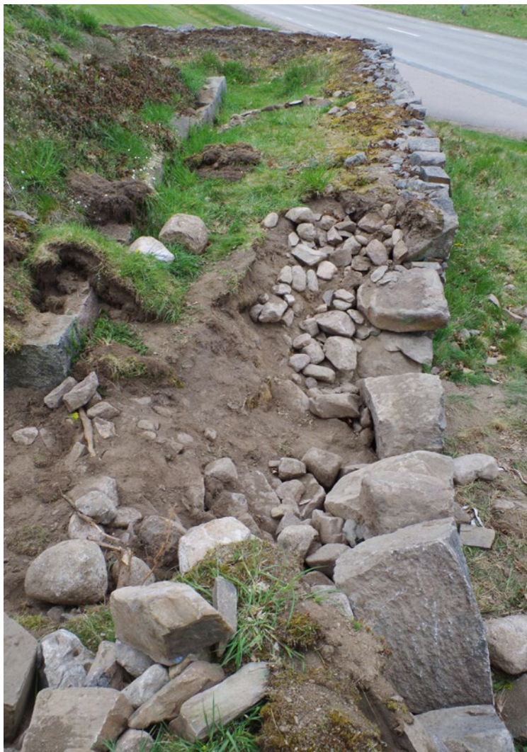
Figur 6. Ett parti av kyrkogårdsmuren söder om gravmonumentet plockades ned i samband med renoveringen. Foto taget från väster.
