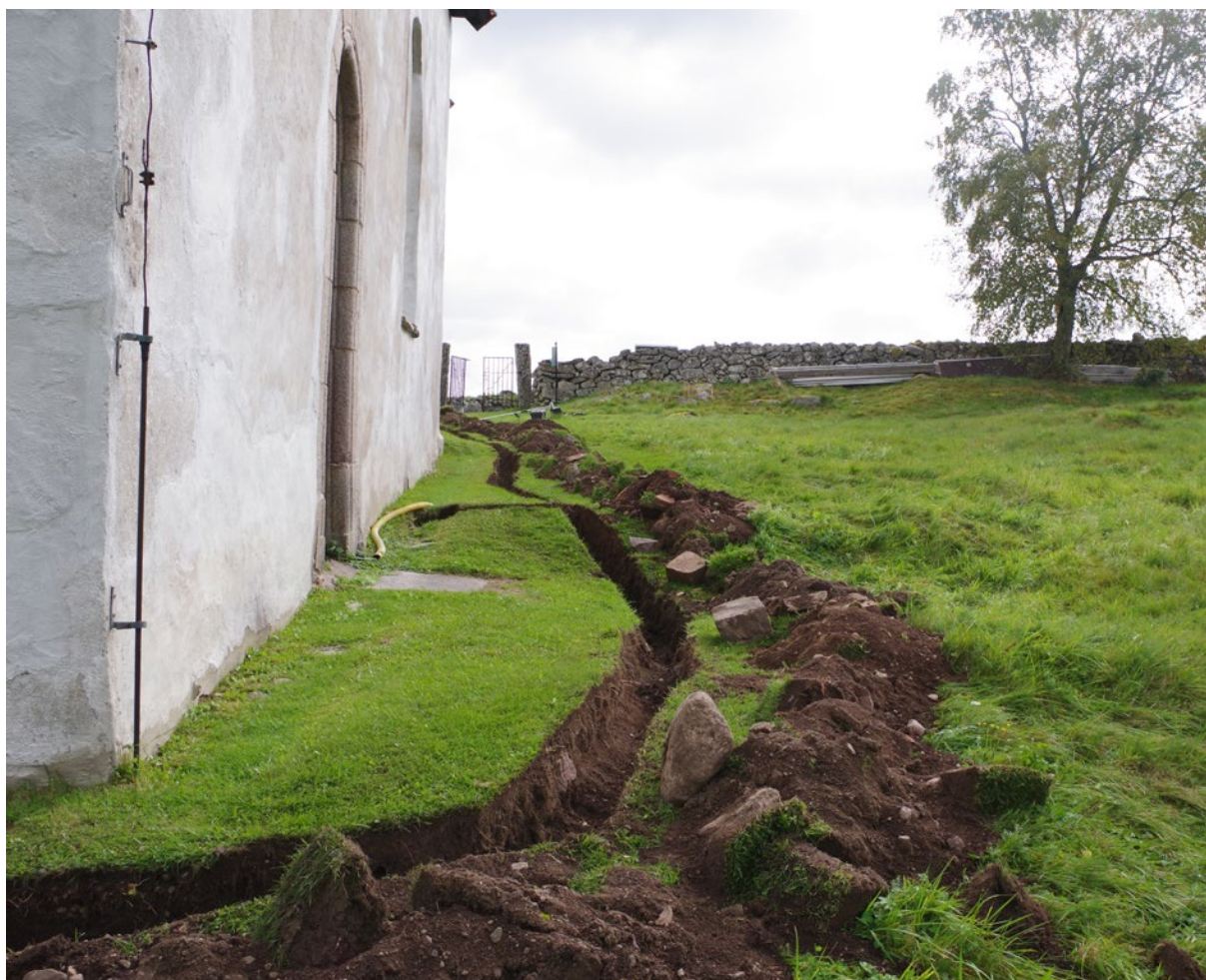
Figur 5. Schaktet utanför långhusets södra sida. Foto taget från sydväst.
