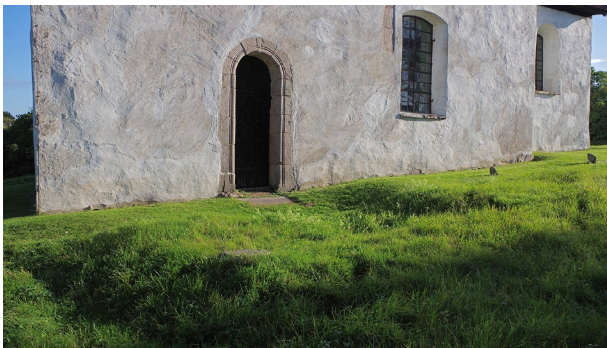
Figur 9. Framför sydporten kunde man redan innan schaktgrävningen ana grunden till det rivna vapenhuset. Foto taget från söder.
