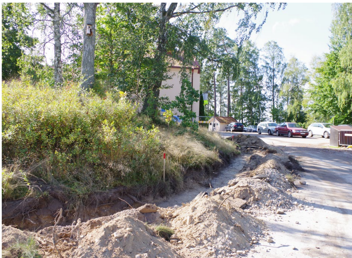
Figur 4. Schaktytan sedd från norr med gravröset till höger i bild.
