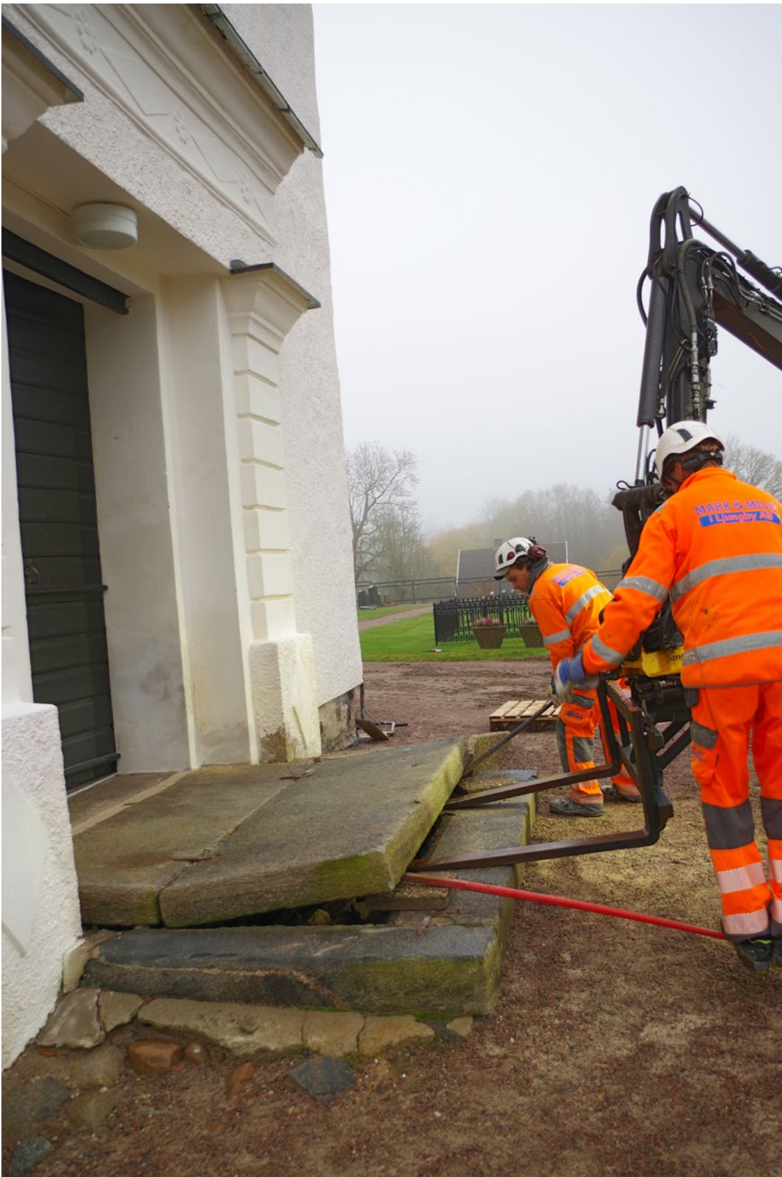
Figur 2. Kyrkotrappan (K1) under nedmontering. Foto från N.
