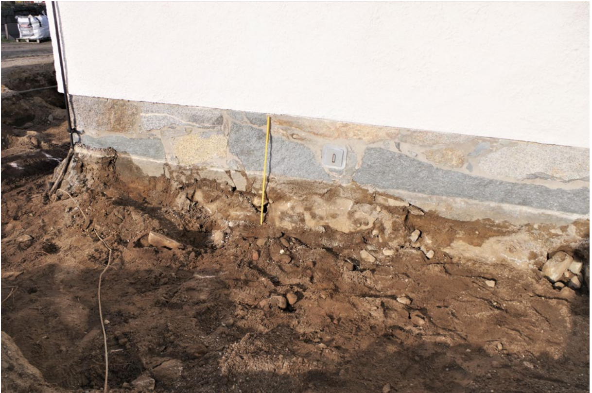
Figur 11. Längs tornets södra sida togs ett avlångs schakt upp för en ny tillgänglighetsramp. Lagret med större stenar, vilket troligen är anlagt som bärlager för kyrkmuren, fanns här under lagren med grus och matjord och kan skönjas i ytan av schaktet. Här grävdes bara ned till ytan av stenlagret. Foto från SO.
