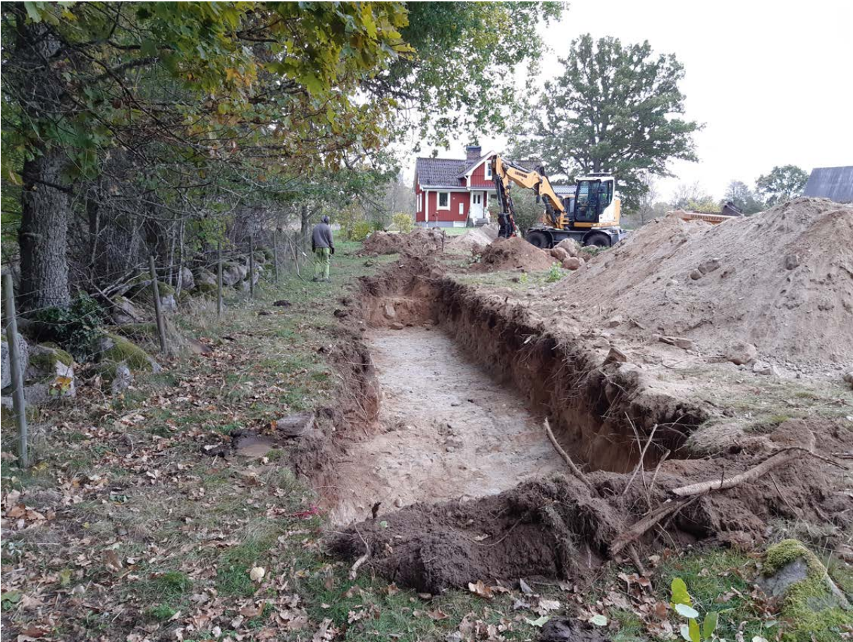
Figur 5. Upptaget schakt med ytan för infiltrationen närmast i bild. Foto från väster.
