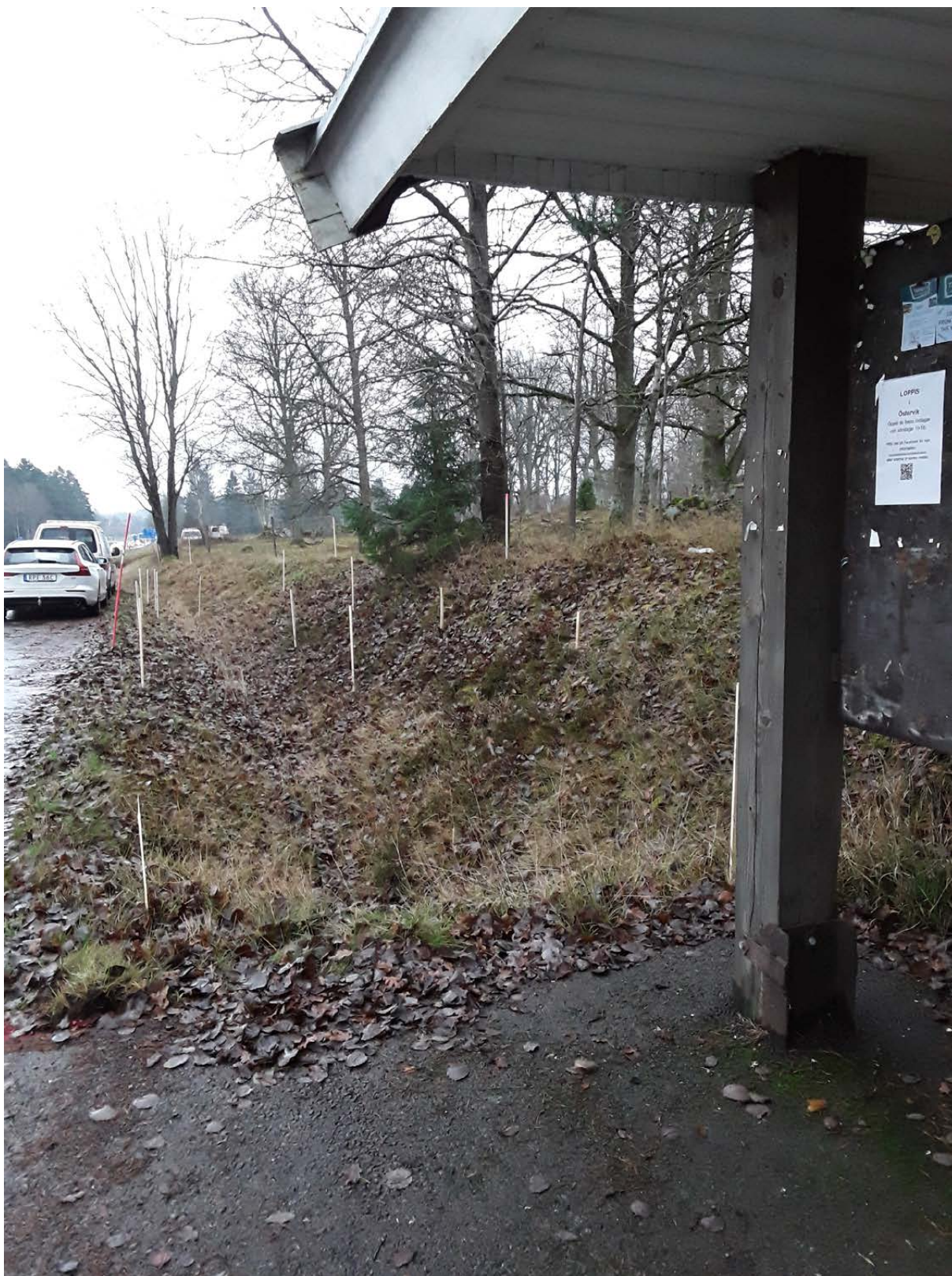
Figur 7. Hela arbetsområdet var redan urschaktat på den västra sidan om vägen. Foto från SSO.
