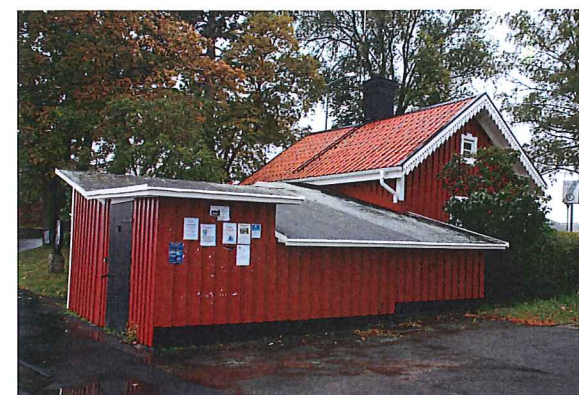
Fig 47. Uthuslängan har en sentida tillbyggnad mot norr.
