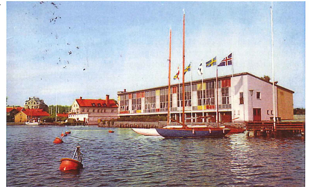
Fig 31. Restaurangbyggnadens östra glasfasad var ursprungligen färgsatt. Foto: Privat vykortssamling.
