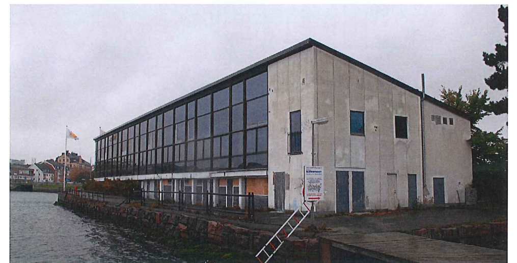
Fig 33. Byggnaden i september 2010. Förfallet är påtagligt.
