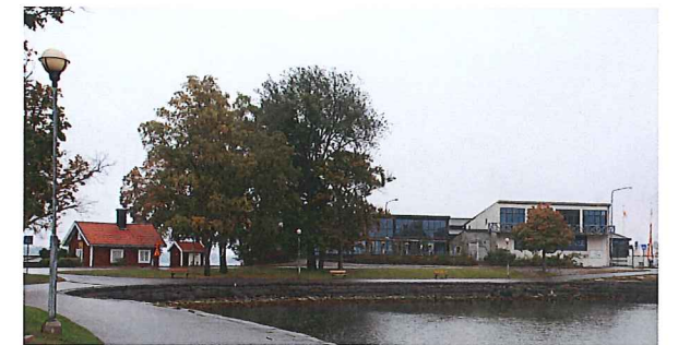
Fig 29. Den sk brovaktarstugan, transformatorbyggnaden och restaurangbyggnaden ses på rad.
