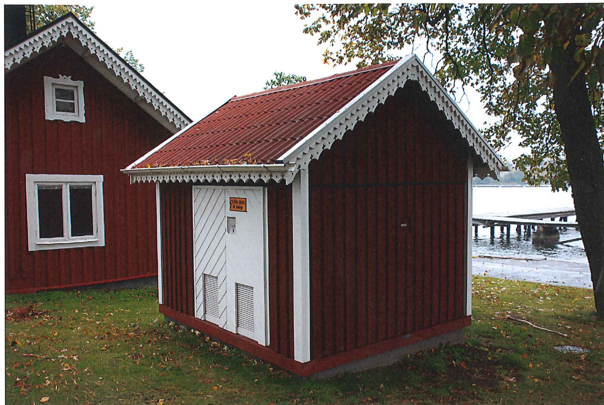
Fig 48. Transformatorstationsbyggnaden har ett utförande som ansluter till den intilliggande brovaktarstugan.
