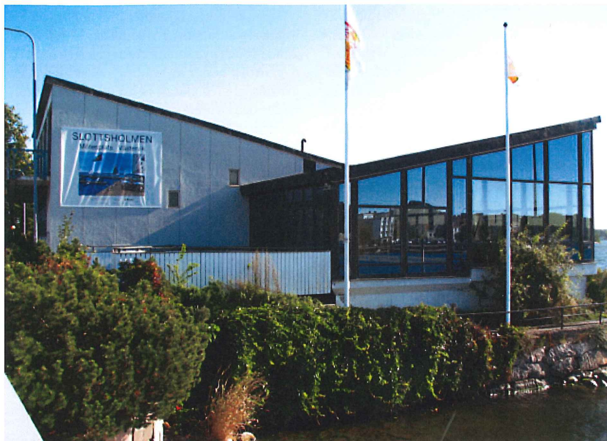
Fig 36. Byggnaden har en speciell gruppering av byggnadsvolymer, vilken blir särskilt tydligt sett från söder.
