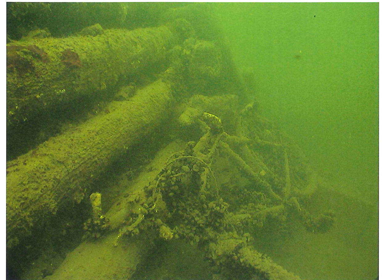
Fig 27. Timrad stenista som utgör fundament till dagens bryggkonstruktion. Ursprungligen timrades kistorna som fundament till det vid förra sekelskiftet anlagda kallbadhuset på platsen. (L. Einarsson, 2010).
