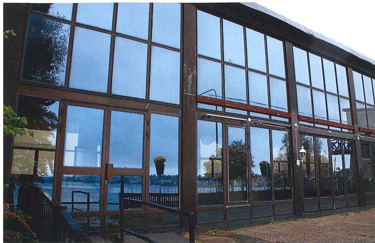
Fig 37. Detalj av den glasade fasaden, vilken byttes ut 1970. De mörktonade glaserna och de bruna aluminiumprofilerna gav byggnaden ett helt annat fasaduttryck.
