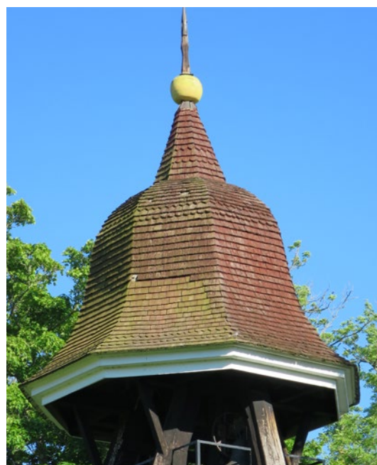
Klockstapelns huv från nordväst före åtgärd.
