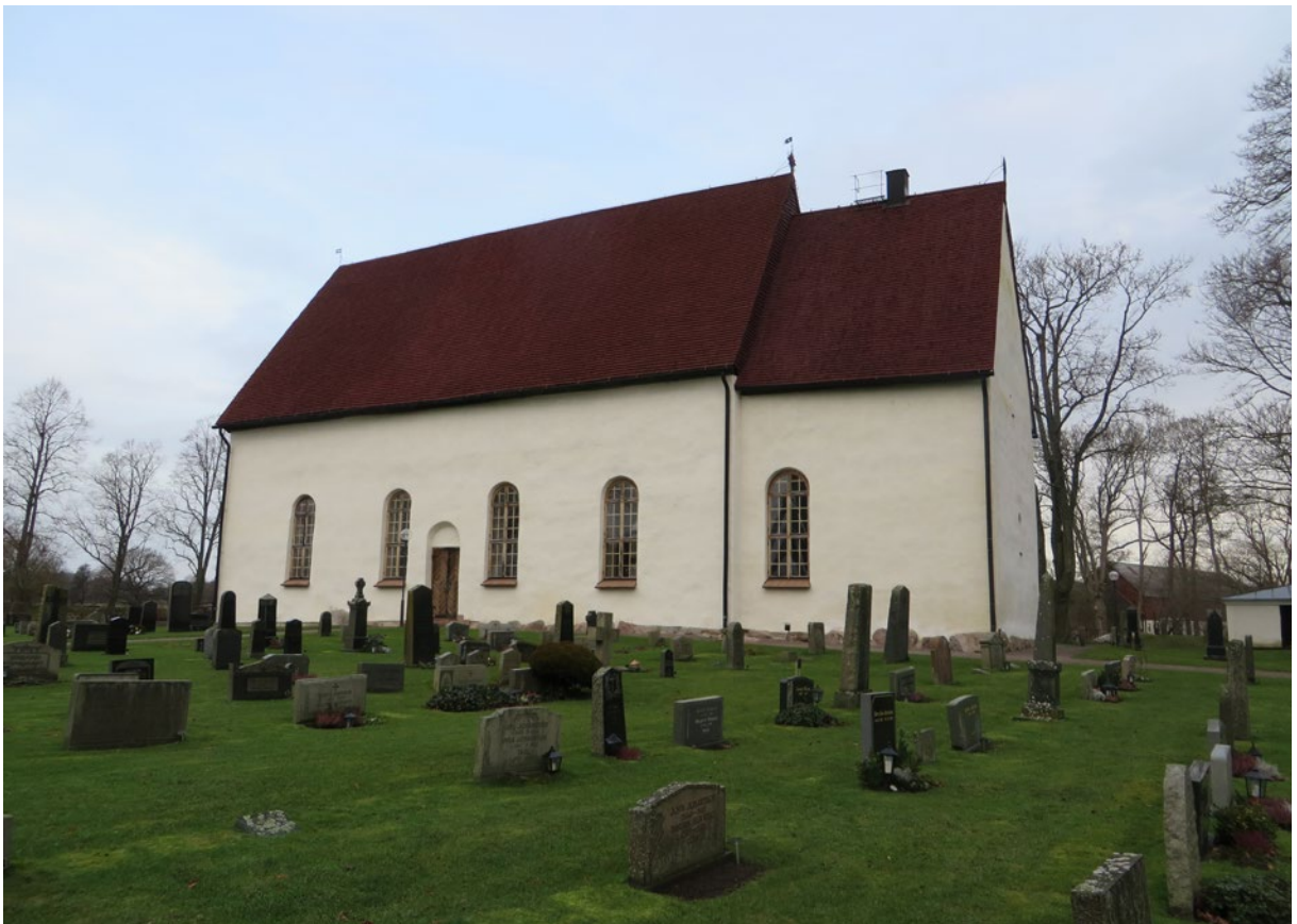
Arby kyrka från sydväst efter åtgärd.
