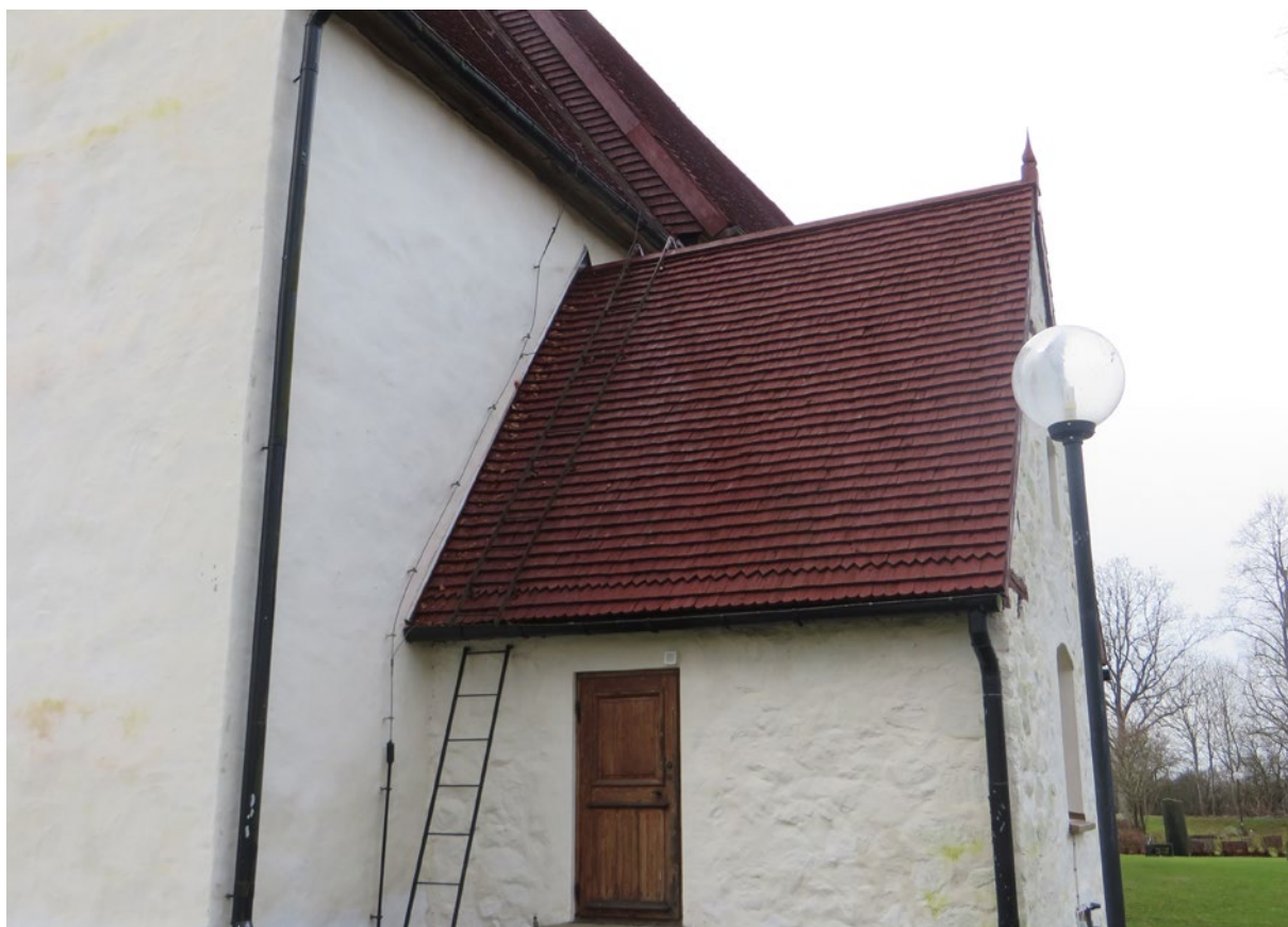
Sakristians tak från nordost efter åtgärd.
