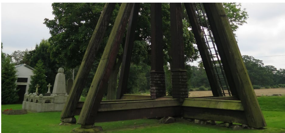
Klockstapeln nedre del från nordväst före åtgärd.
