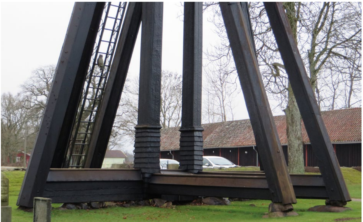
Klockstapelns nedre del från nordöst efter åtgärd.
