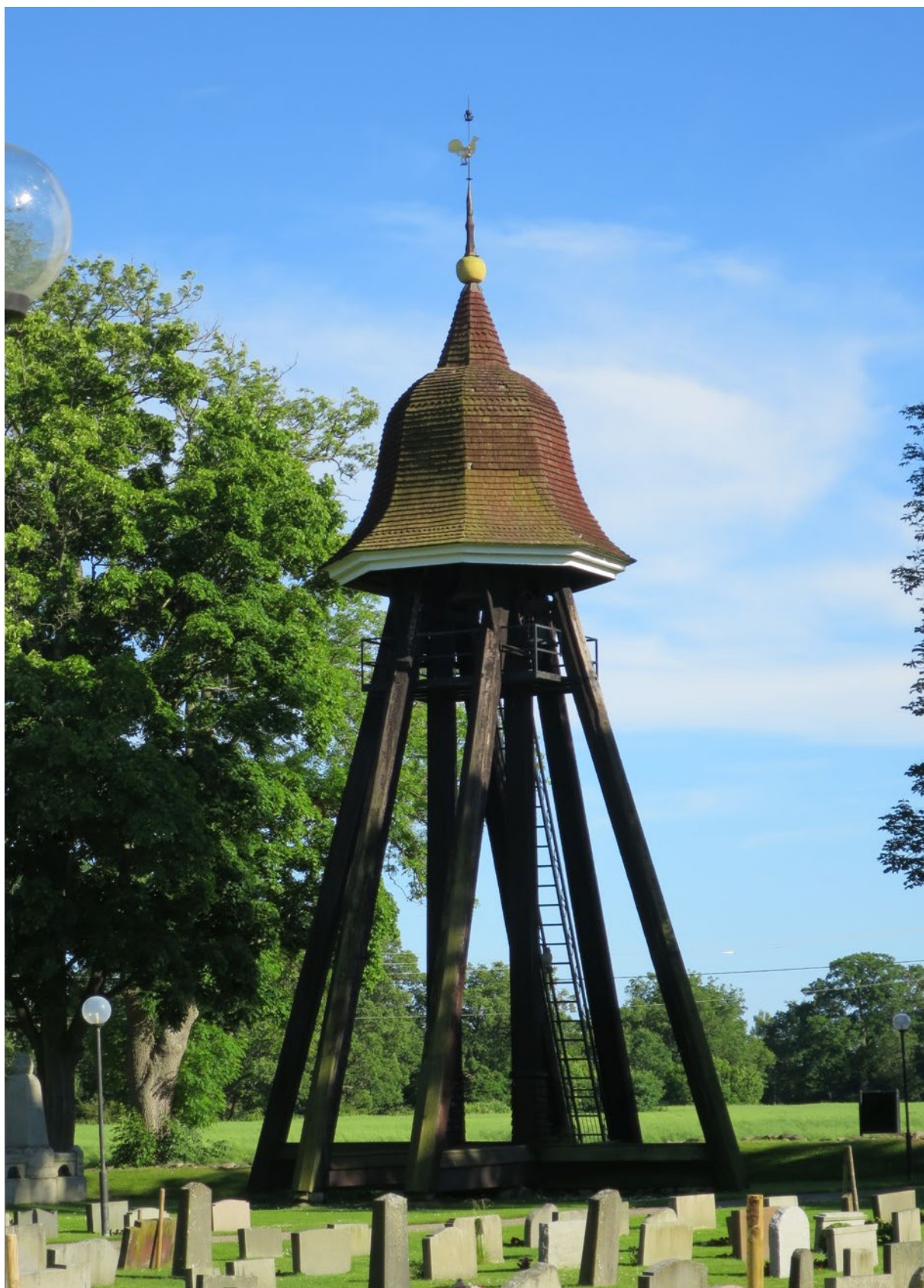
Klockstapeln från nordväst före åtgärd.
