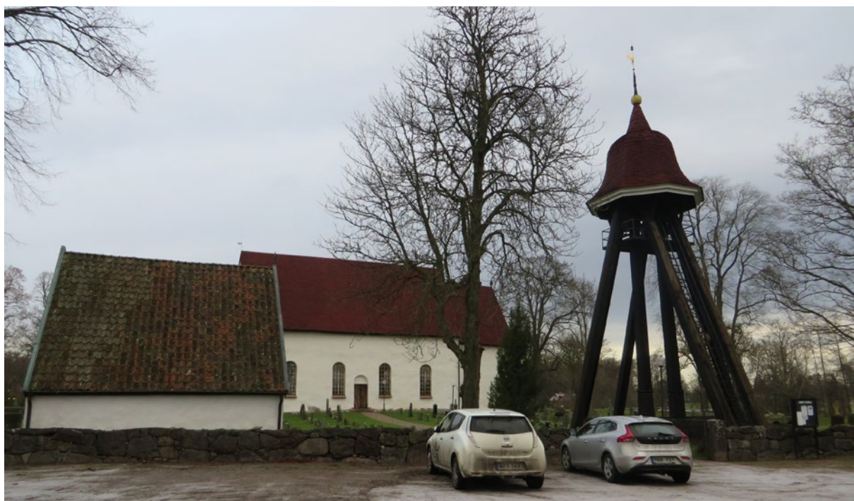
Arby kyrka och klockstapel från söder efter åtgärd.
