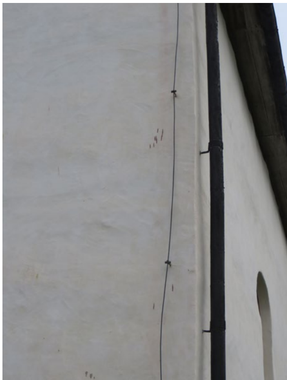
Exempel på några av de tjärstänk som fortfarande finns på kyrkans fasader och som ska åtgärdas.
