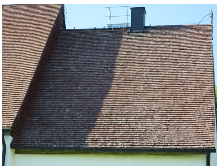
Kortaket från söder före åtgärd.
