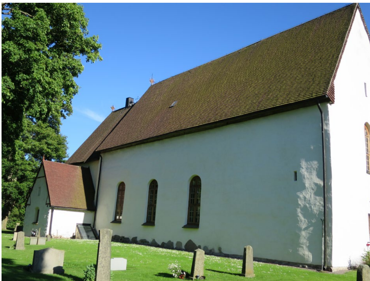
Arby kyrka från nordväst före åtgärd.
