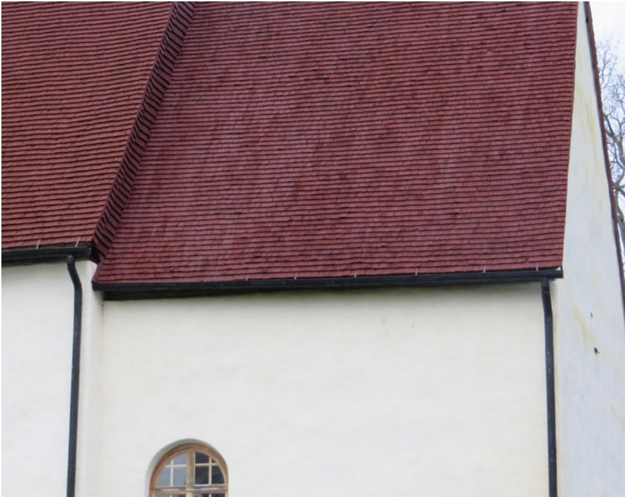
Kortaket från söder efter åtgärd.
