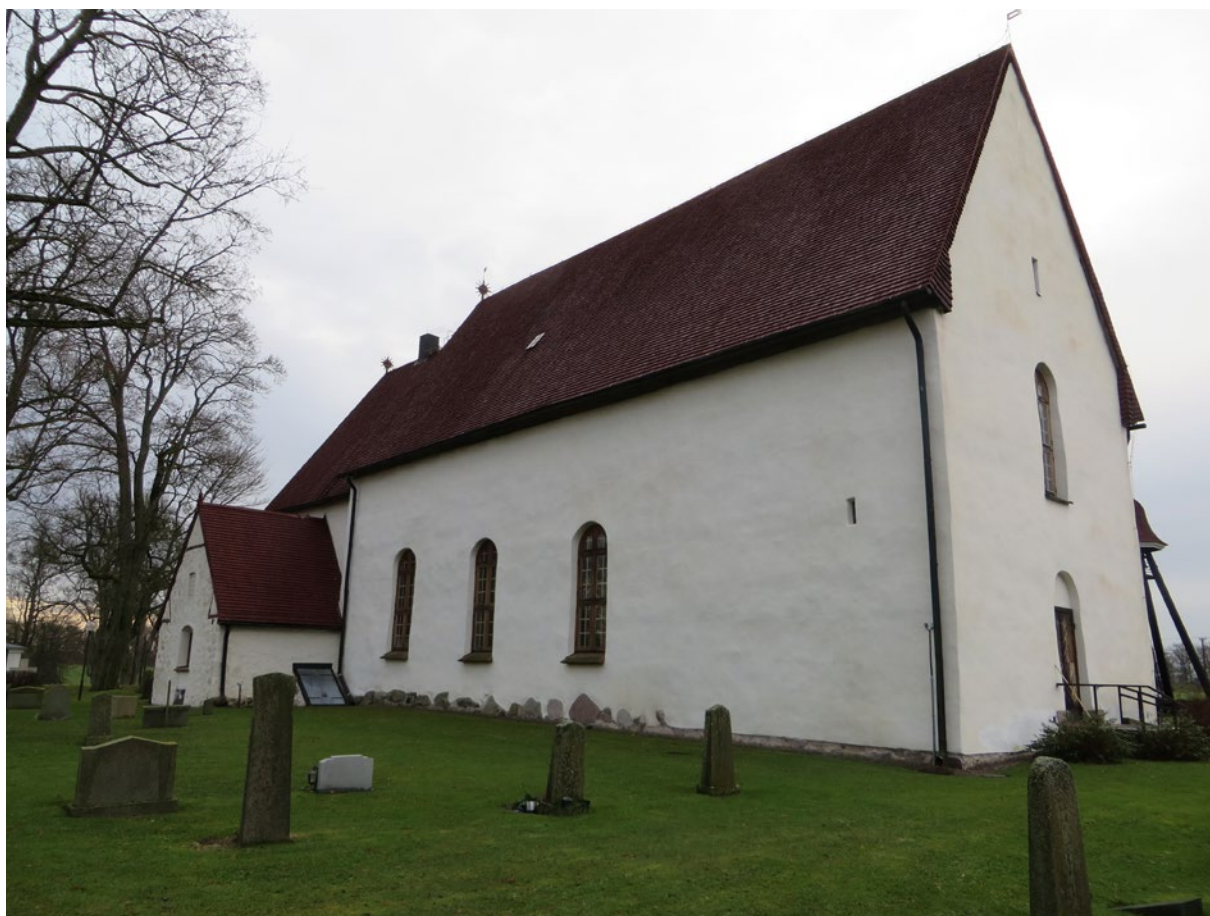
Arby kyrka från nordväst efter åtgärd.
