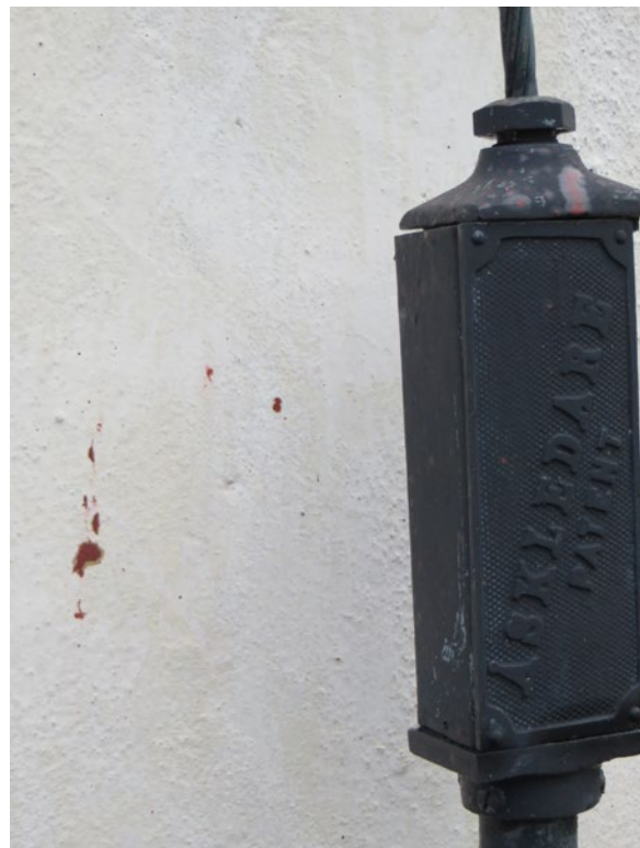
Exempel på några av de tjärstänk som fortfarande finns på kyrkans fasader och som ska åtgärdas.
