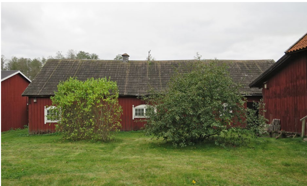
Norra takfallet före renovering.
