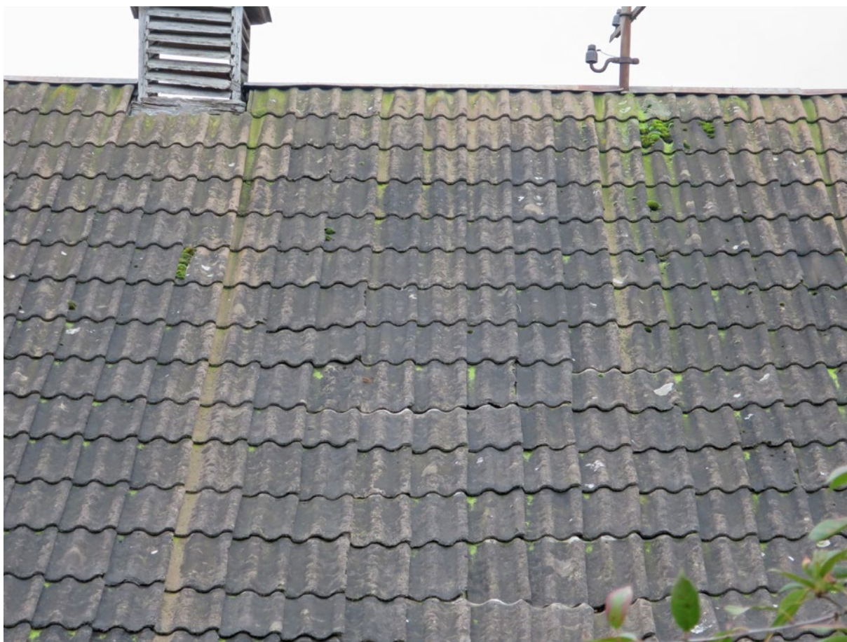
Norra takfallet före renovering. Det grå, tvåkupiga betongteglet.
