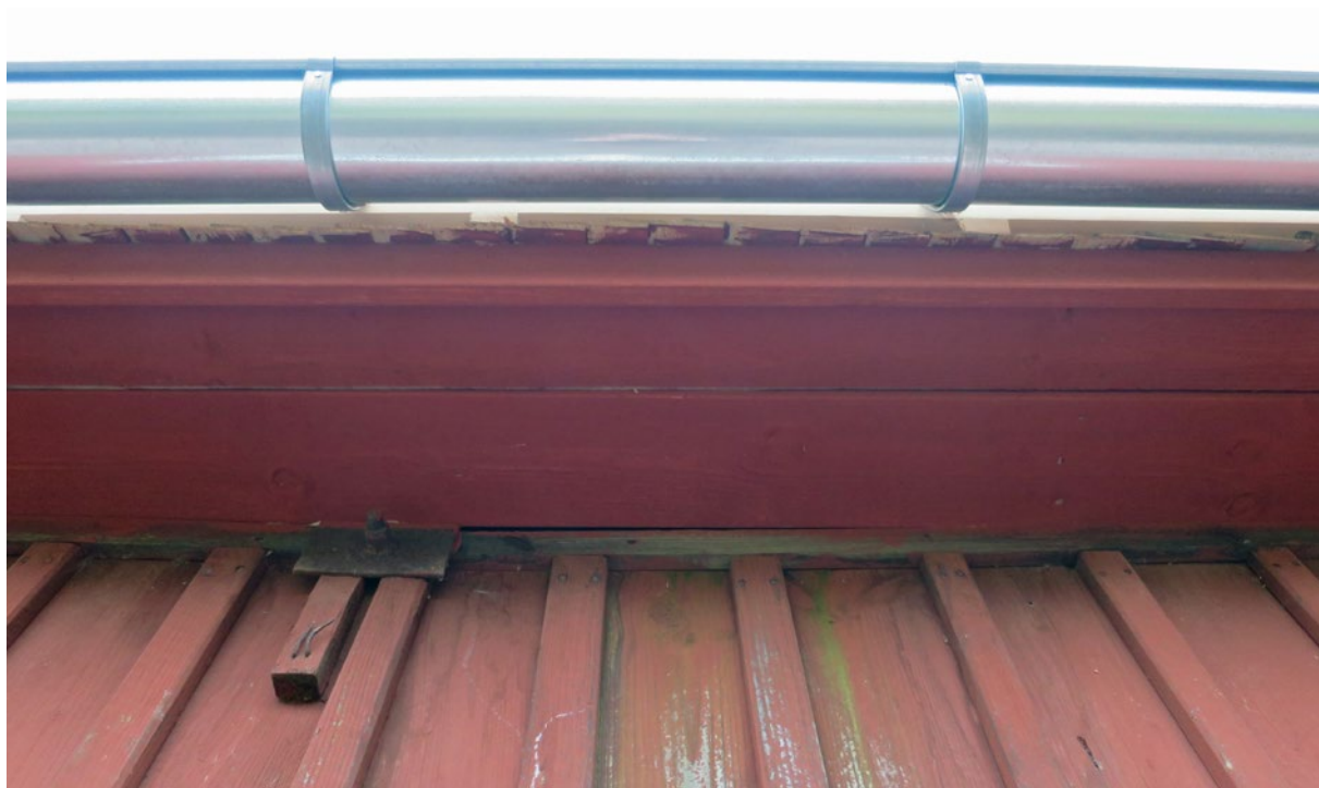
Norra takfallet efter renovering. Lagning av rötskada på takfot, med virke som fanns i ladugården.
