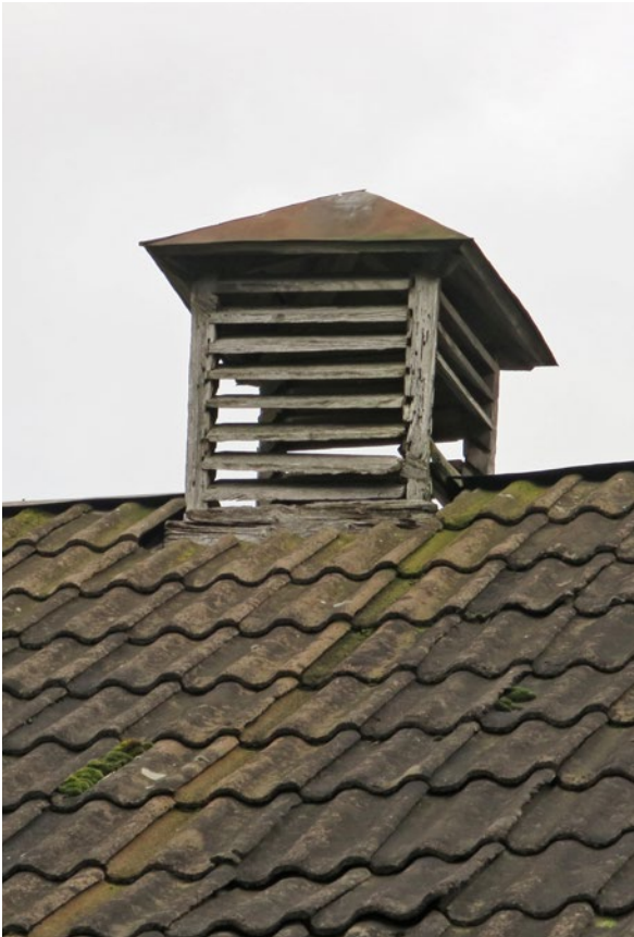
Befintlig ventilationshuv längst åt öster. Här kan man se att det fattas en hel del spjälor på sidorna av huven.
