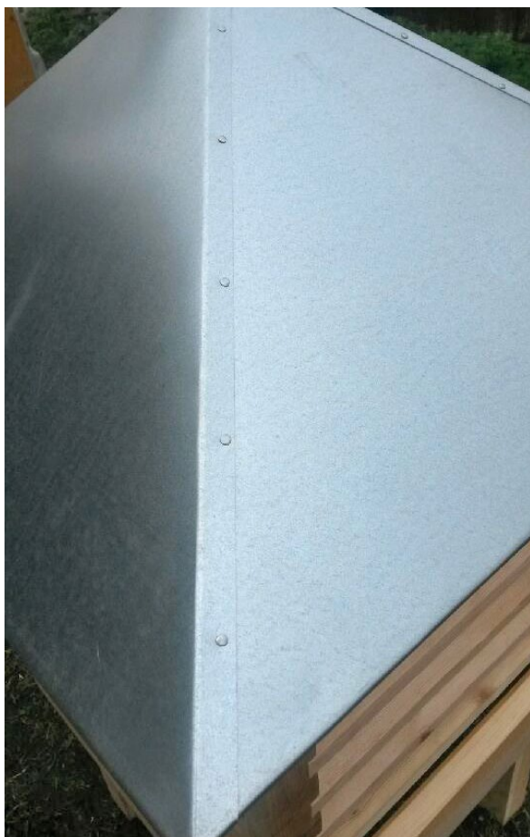
En av de nyttillverkade ventilationshuvorna innan den monterats. Huvens tak som är täckt med galvaniserad plåt som fästs med nubb, likt den gamla huvan. Foto: Dea Carlsson.
