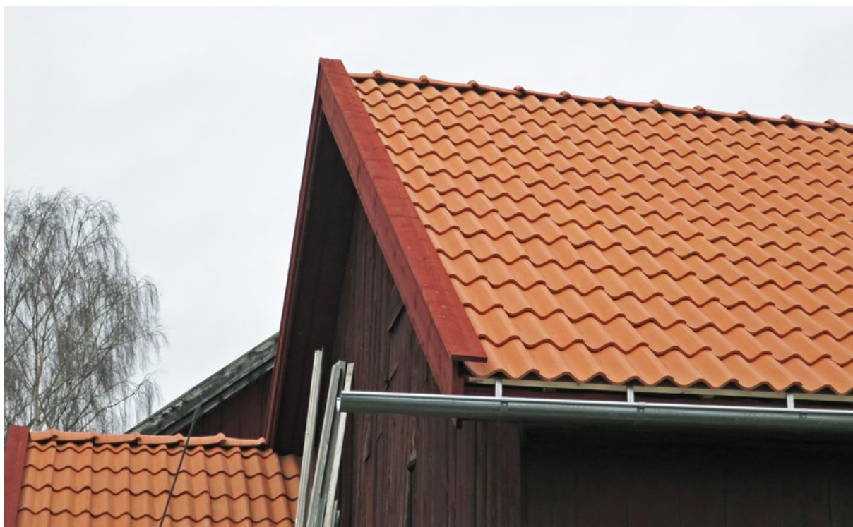
Södra takfallet efter renovering. Stormlisten och vindskivorna har bytts ut och målats med Falu rödfärg. Notera även hur hänggränsan löper ut från takfoten.
