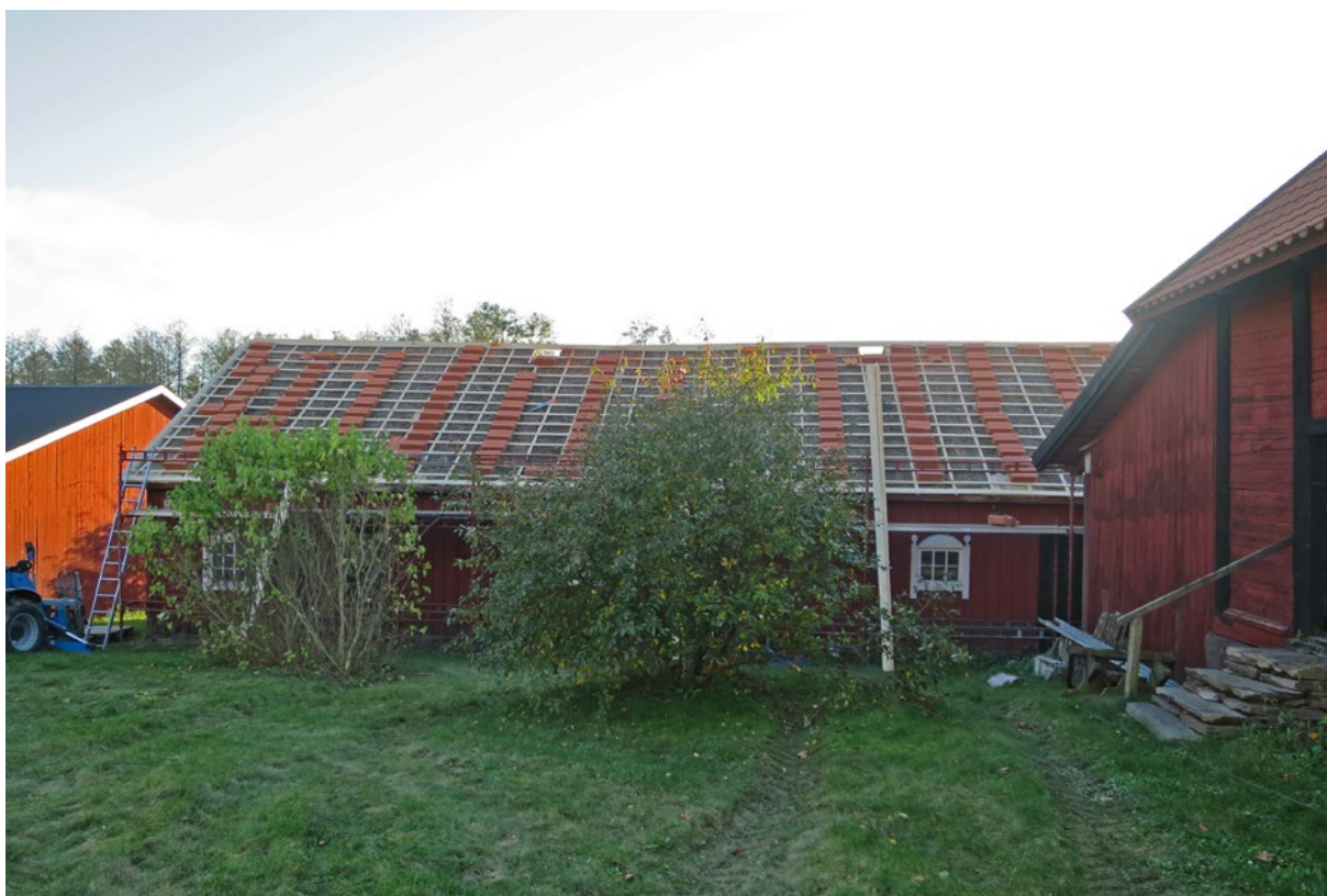
Norra takfallet under pågående renovering.
