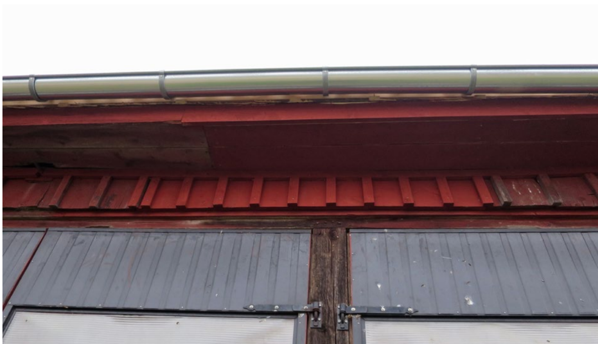
Södra fasaden efter åtgärd. Ny panel där det tidigare saknats, p g a lagningen och förstärkningen av taket.
