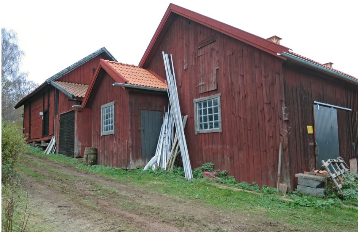
Tillbyggnadens södra takfall och delar av västra fasaden efter renovering. Stormlister och vindskivor är bytta och målade med Falu rödfärg.
