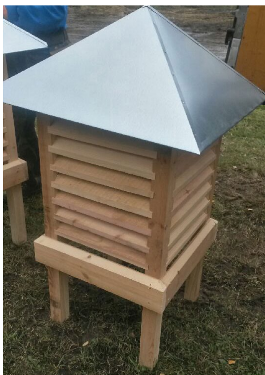
En av de nyttillverkade ventilationshuvorna innan den monterats. Foto: Dea Carlsson.
