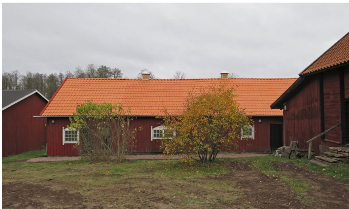
Norra takfallet efter renovering.
