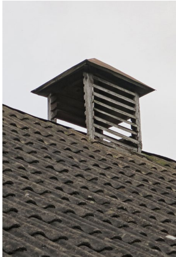
Befintlig ventilationshuv längst åt öster. Här kan man se att det fattas en hel del spjälor på sidorna av huven.
