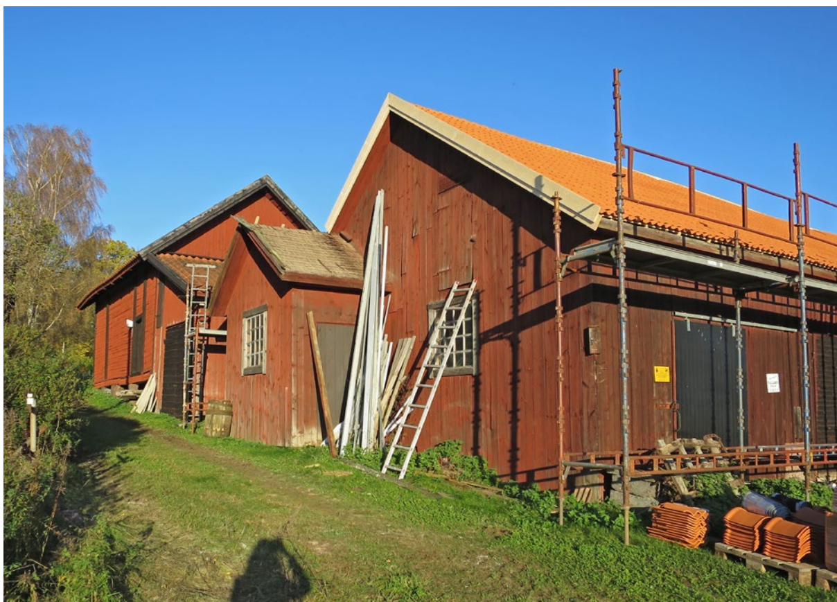
Södra takfallet under pågående renovering. Här har nya vindskivor monterats.
