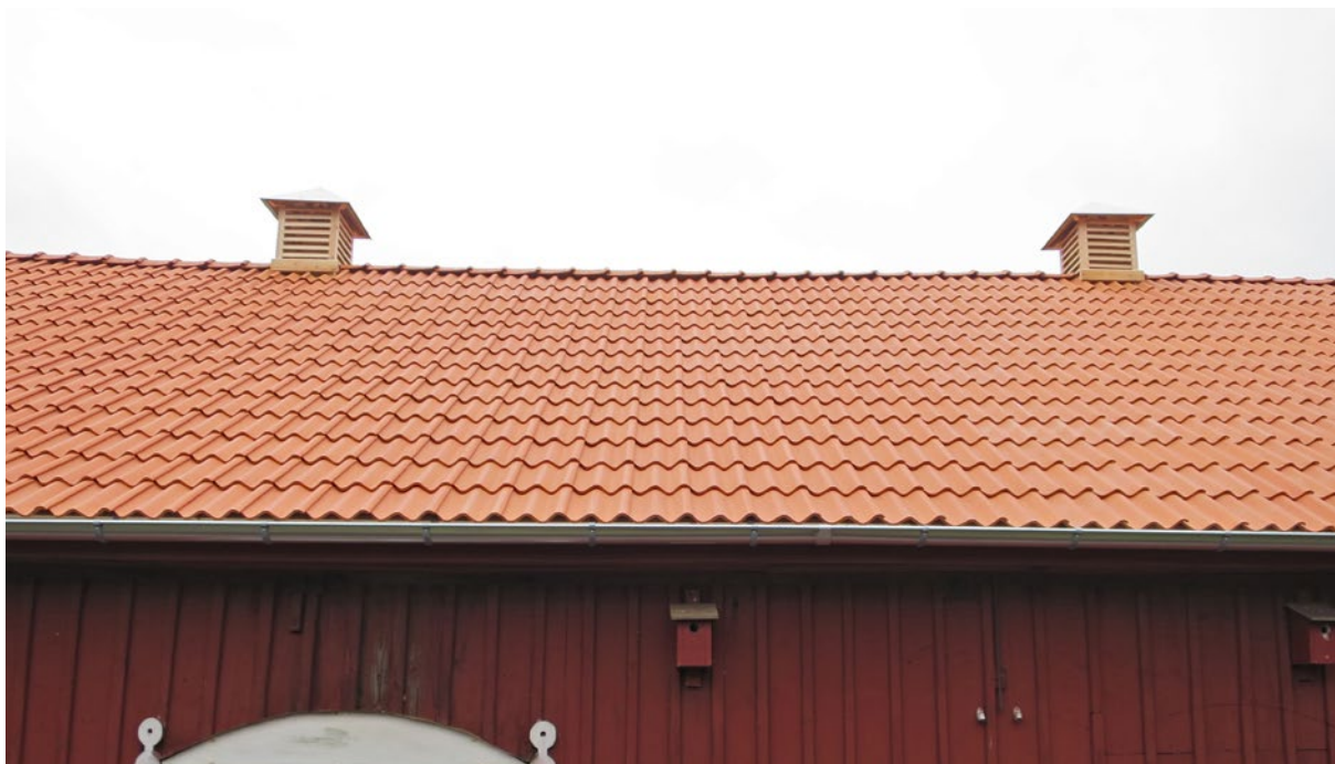
De nyttillverkade ventilationshuvorna från norr, efter att de monterats på taket.
