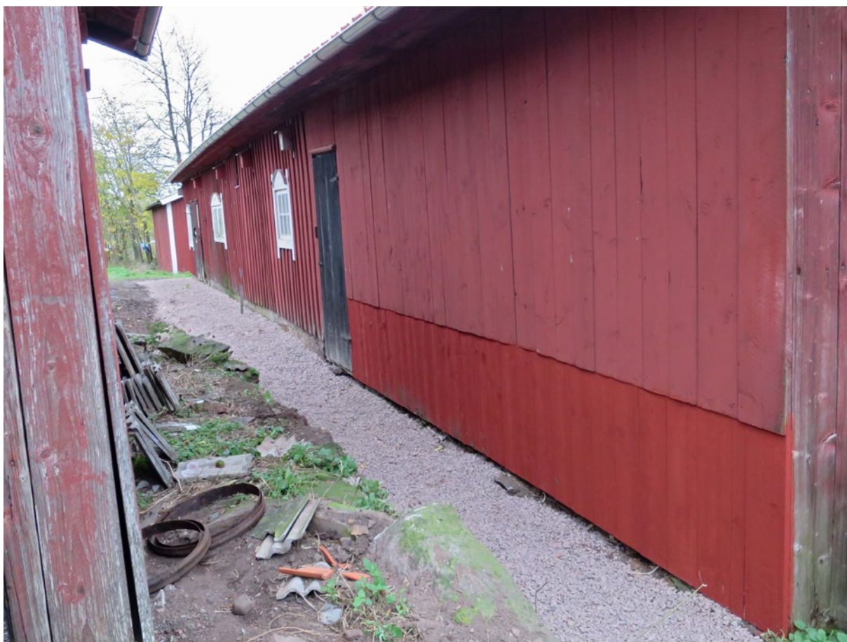
Norra fasaden efter åtgärd. Här har den nya lagningen längst åt väster utförts likt tidigare.
