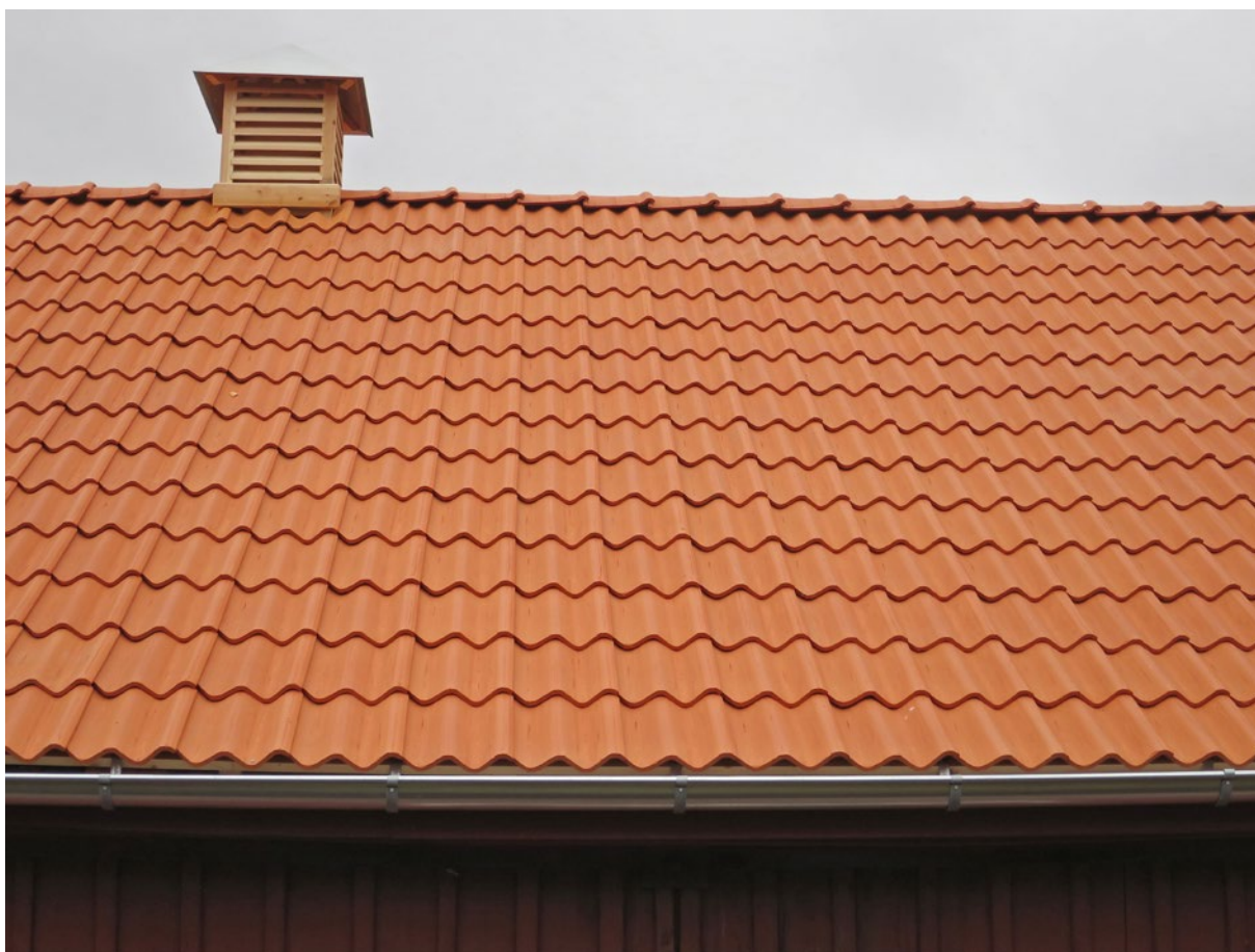
Norra takfallet efter reovering. Det nya, tvåkupiga lerteglet från Vittinge.
