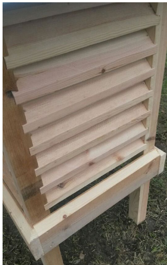
En av de nyttillverkade ventilationshuvorna innan den monterats. Spjälorna är infällda i reglarna precis som tidigare. Foto: Dea Carlsson.
