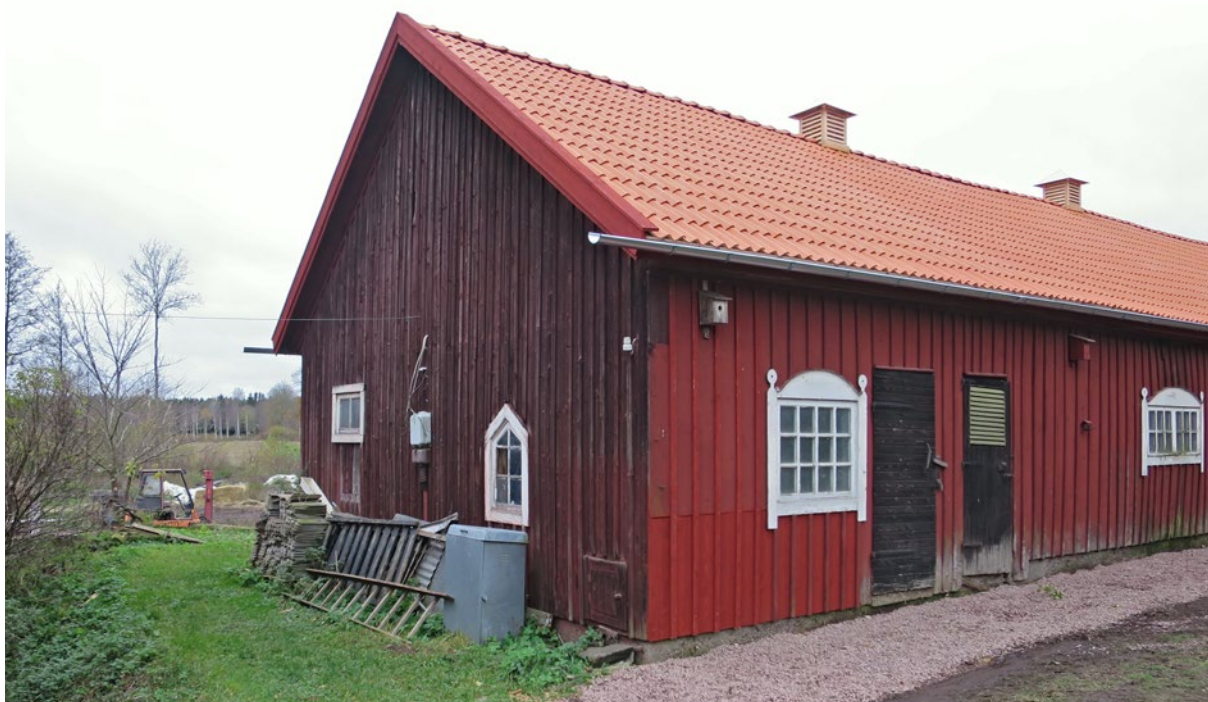
Norra takfallet efter reovering. Stormlisten och vindskivorna har bytts ut och målats med Falu rödfärg.
