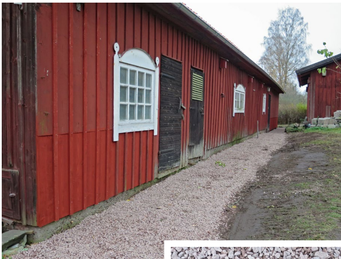
Den nygrävda dräneringen längs norra fasaden samt en detaljbild på makadamen som använts som dränerande skikt.
