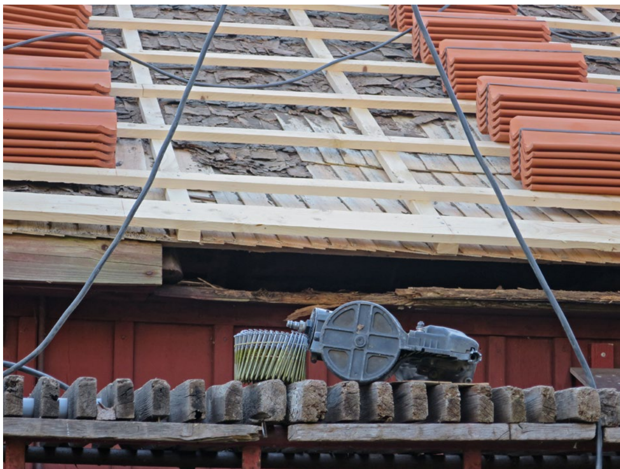
Norra takfallet under pågående renovering. En utav sticketakets lagningar.
