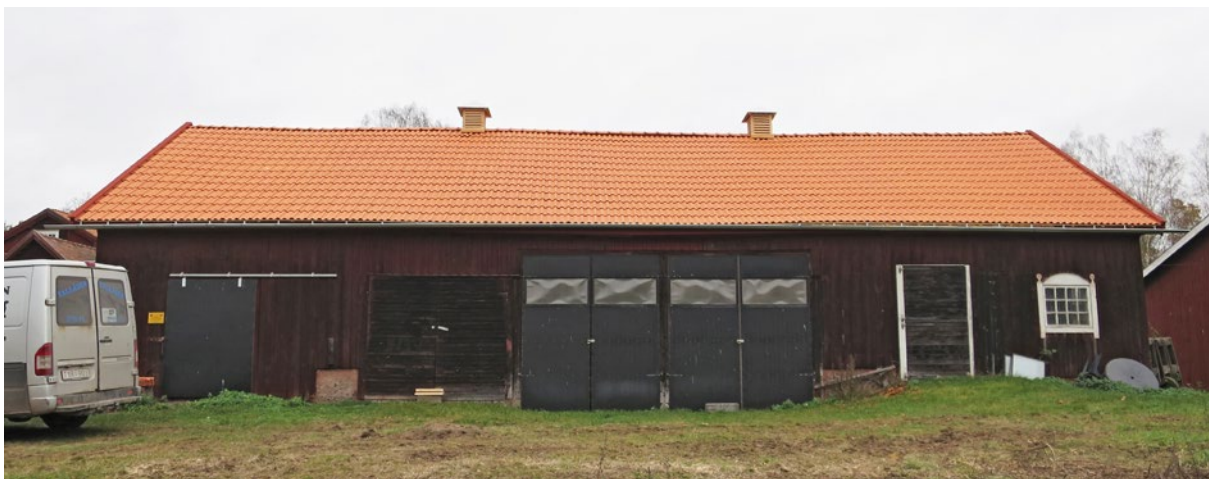
Södra takfallet efter renovering. Nya hängrännor i galvaniserad plåt har monterats.
