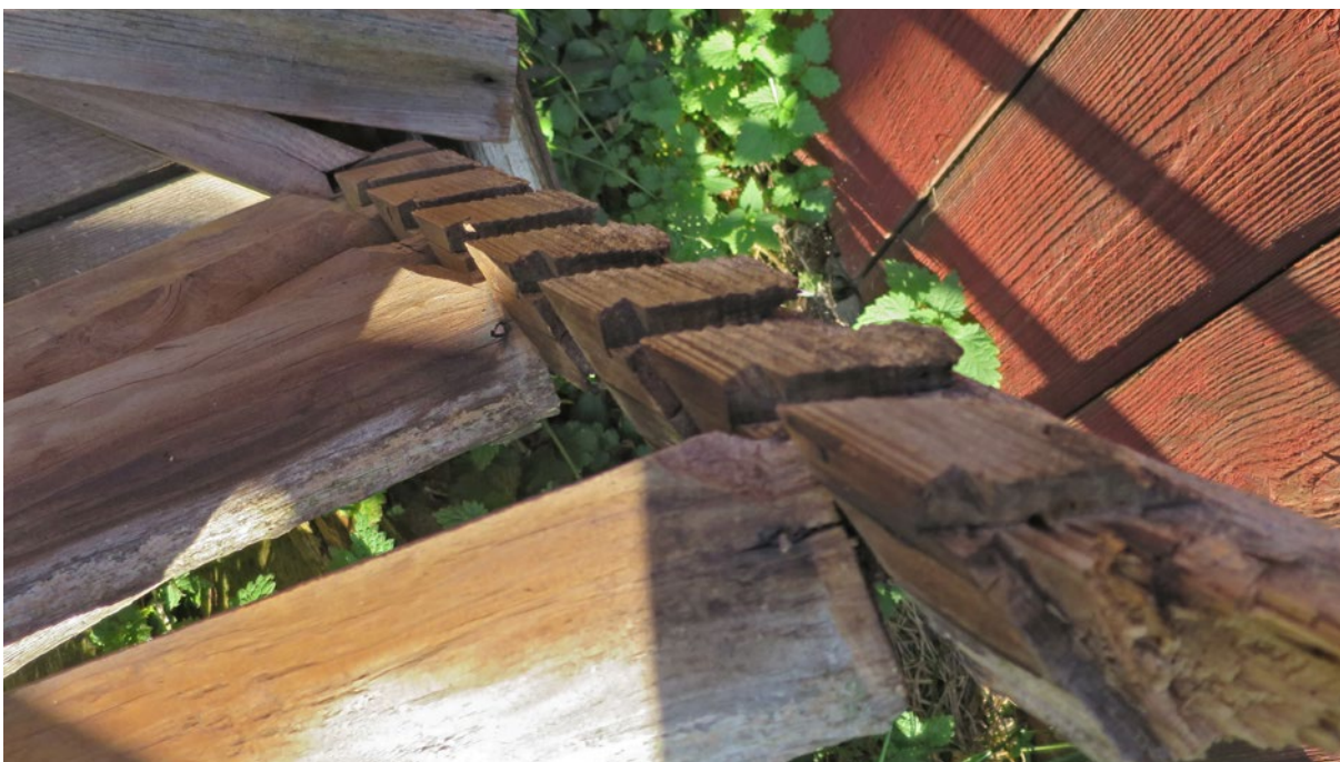
Befintlig ventilationshuv före renovering. Detaljbild på en av hörnreglarna på den befintliga ventilationshuv. Notera de ursågade spåren för spjälorna.
