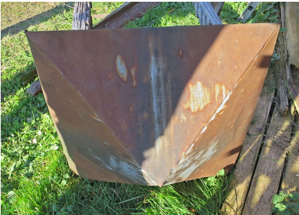
Befintlig ventilationshuv före renovering. Huvens tak, täckt av galvaniserad plåt som fästs med nubb.
