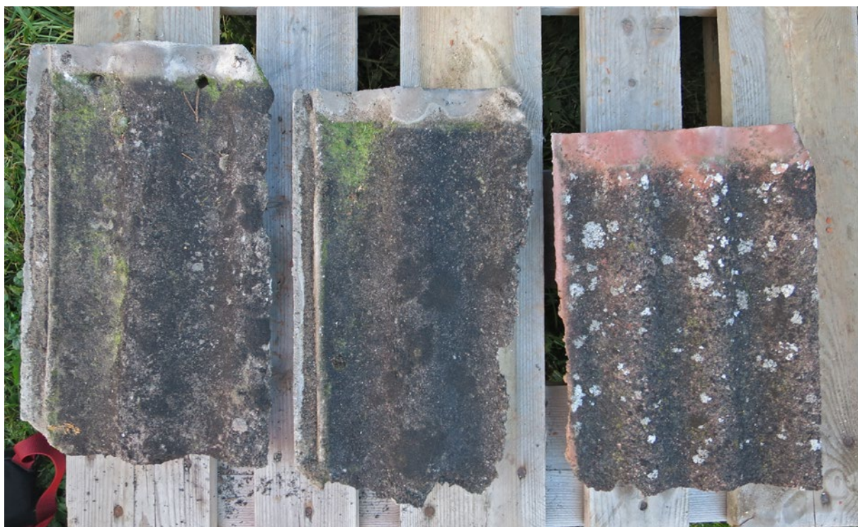
Ladugårdstakets befintliga takpannor. De två åt vänster är det tvåkupiga, gråa betongteglet som låg på det norra takfallet. Den åt höger är det trekupiga, röda betongteglet som låg på det södra takfallet.
