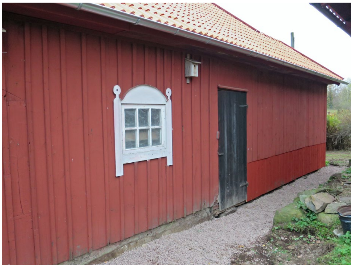
Norra takfallets hängrännor efter renovering.
