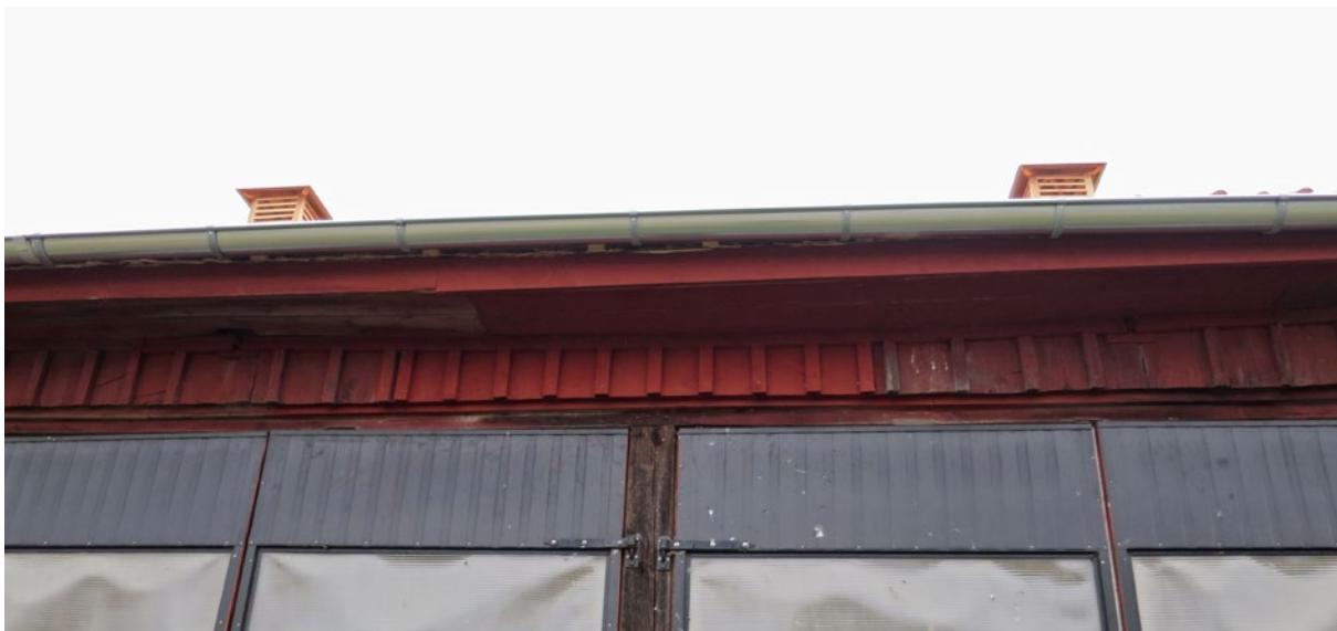
Södra takfallet efter renovering. Här har den tidigare taklagningen och takstolsförstärkningen klätts in i takfotsinklädnad likt resten av byggnaden.
