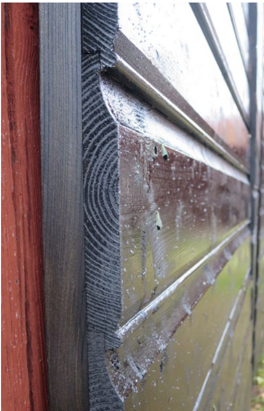
Detaljbild på portarnas nya panelprofil, som efterliknar den intilliggande enkeldörrens panel.
