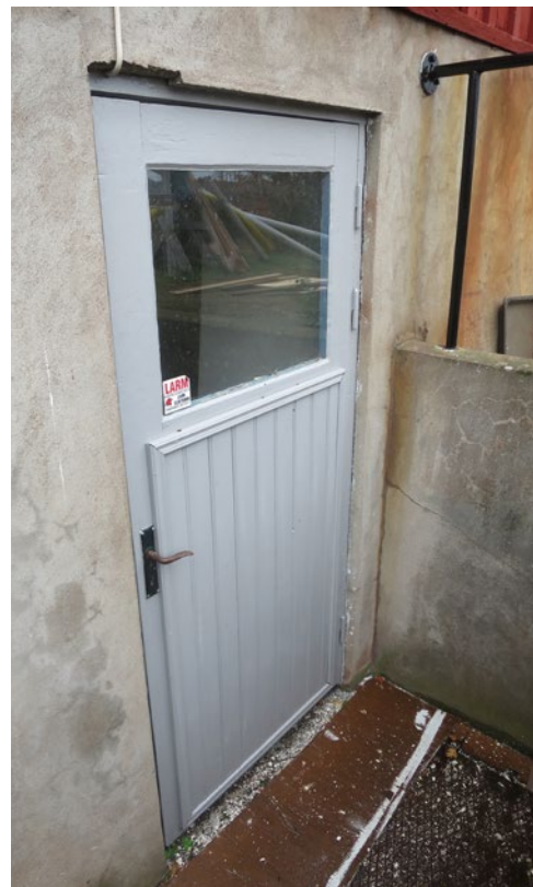
Källardörren efter åtgärd.
