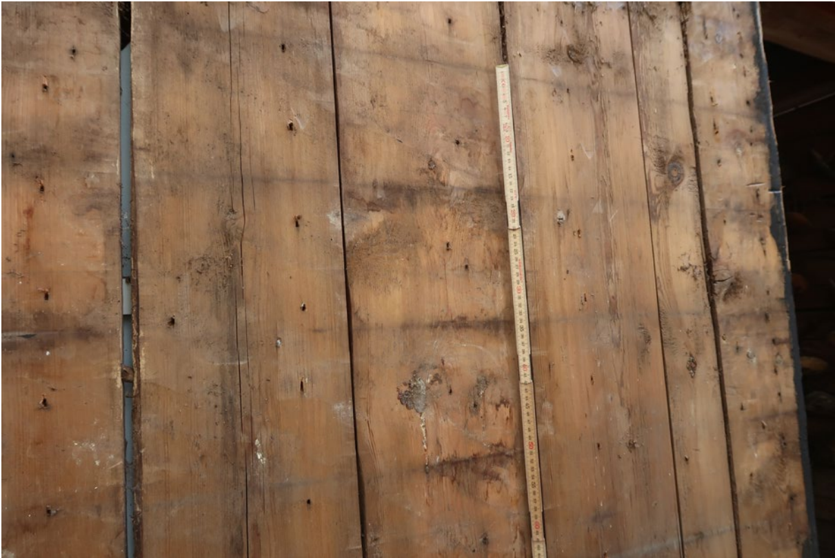
Den bakomliggande konstruktionen på portarna visade tydliga spår efter den tidigare, kanske t.o.m. ursprungliga, panelen. Den var ca 17 cm bred. Foto: Jan Westergren.
