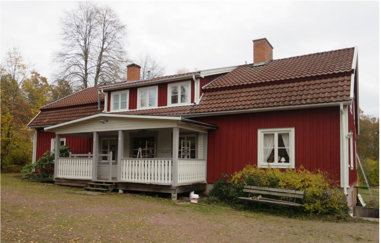
Tingshusets nordvästra fasad efter åtgärd.
