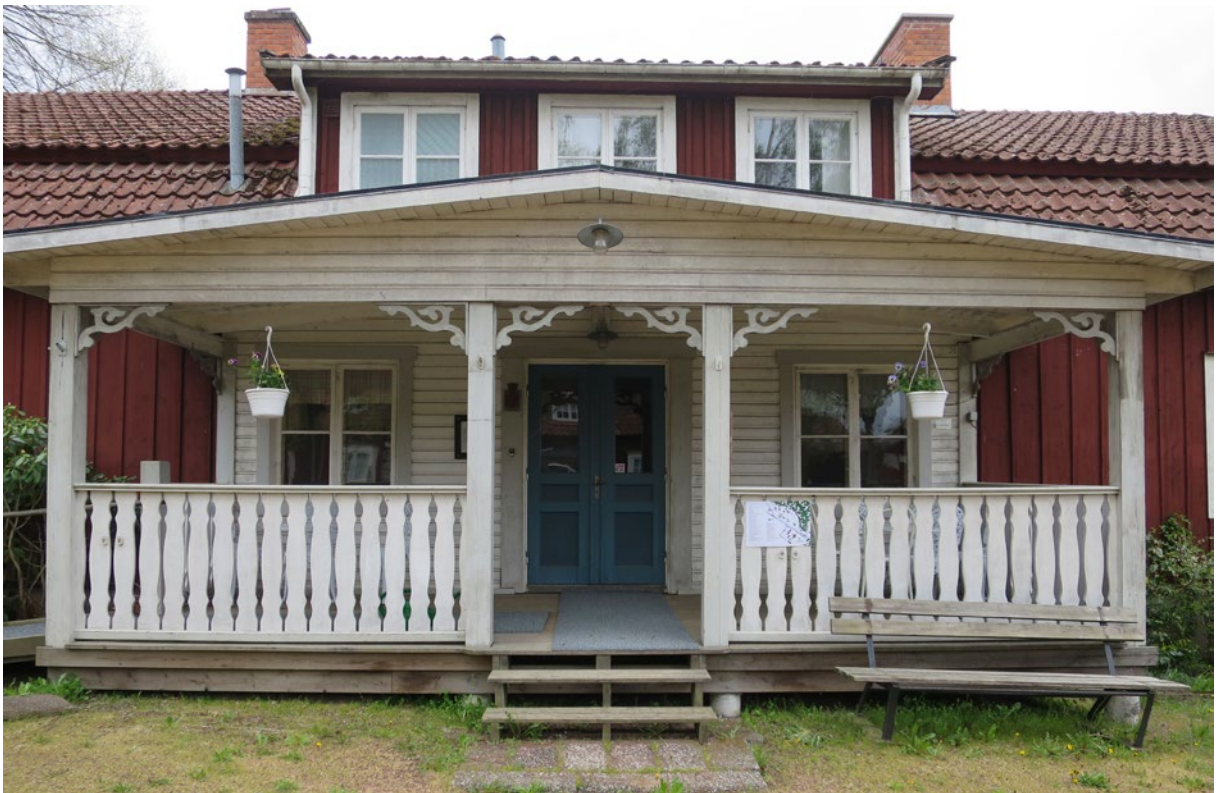
Tingshusets veranda före åtgärd.
