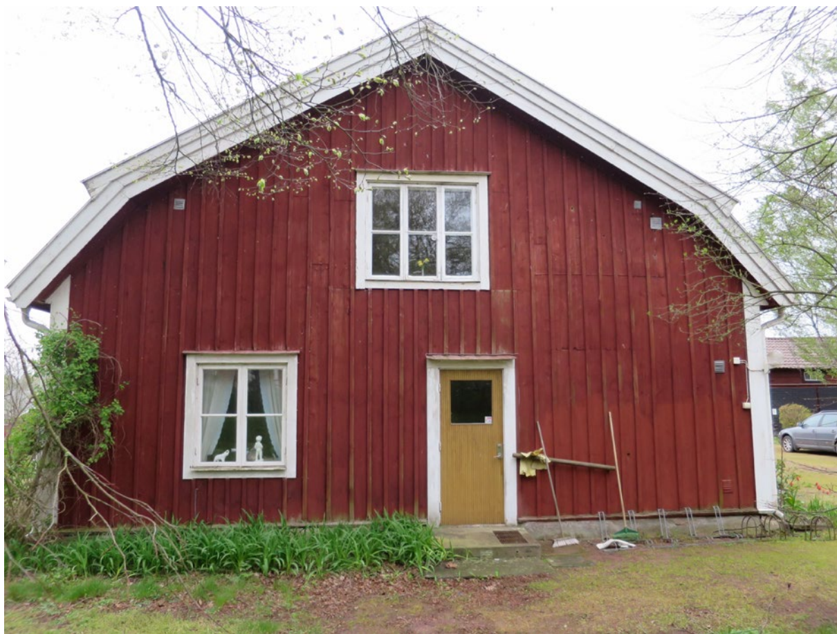
Tingshusets nordöstra fasad före åtgärd.
