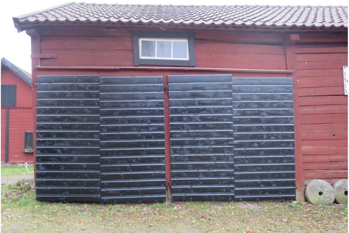
Portarna på vagnsboden efter åtgärd.
