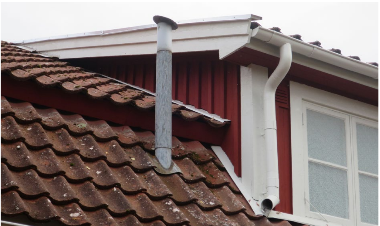
Den dåliga vindskivan på takkupan mot nordväst, som saknade vindskiveplåt, har bytts ut och fått en ny vindskiveplåt.
