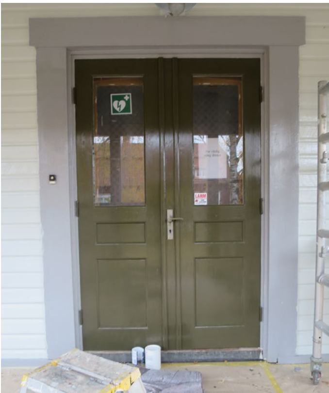
Pardörren efter åtgärd.
