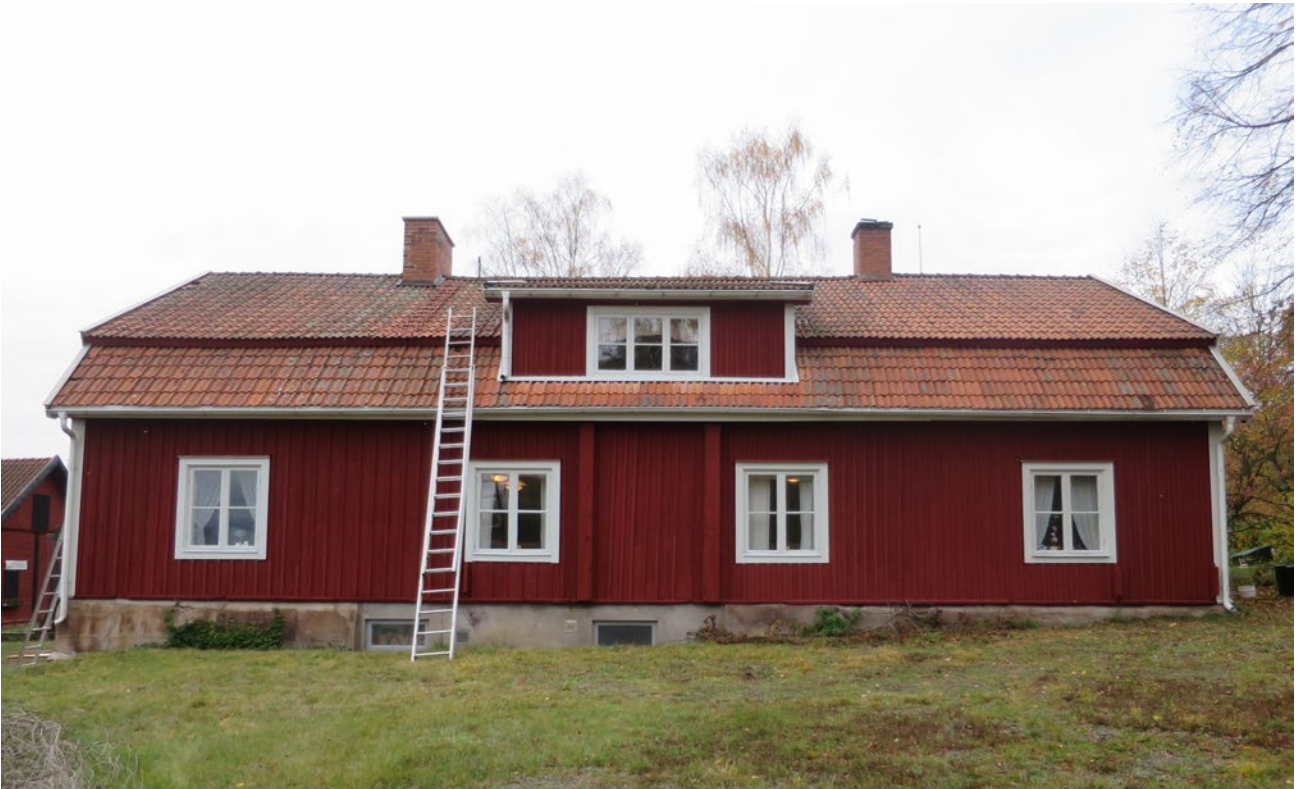
Tingshusets nordöstra fasad efter åtgärd.
