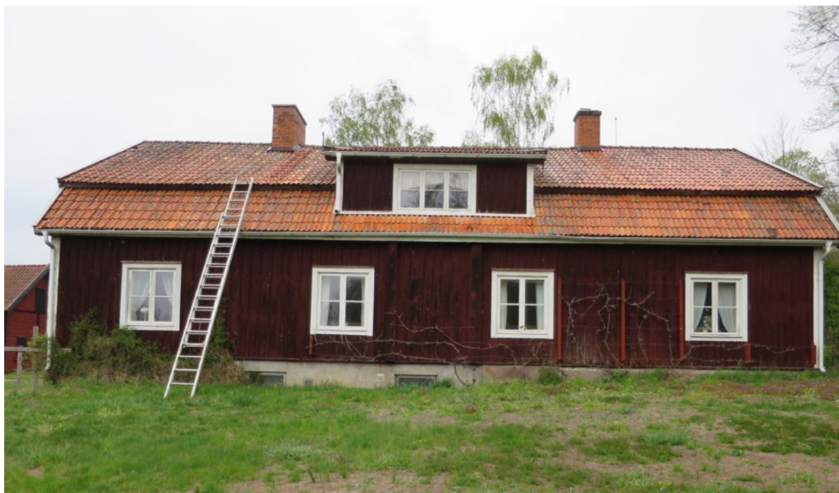
Tingshusets sydöstra fasad före åtgärd.
