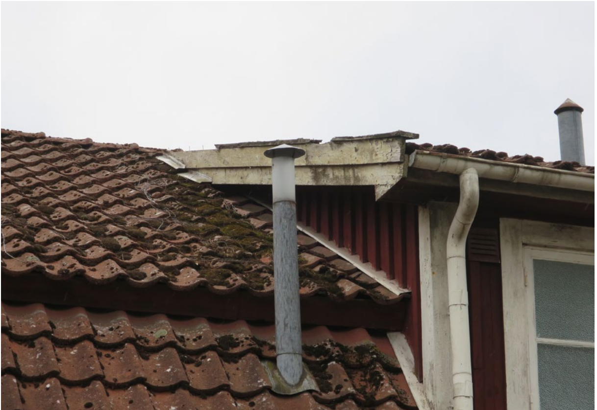
Den dåliga vindskivan, som saknade vindskiveplåt, på takkupan mot nordväst.
