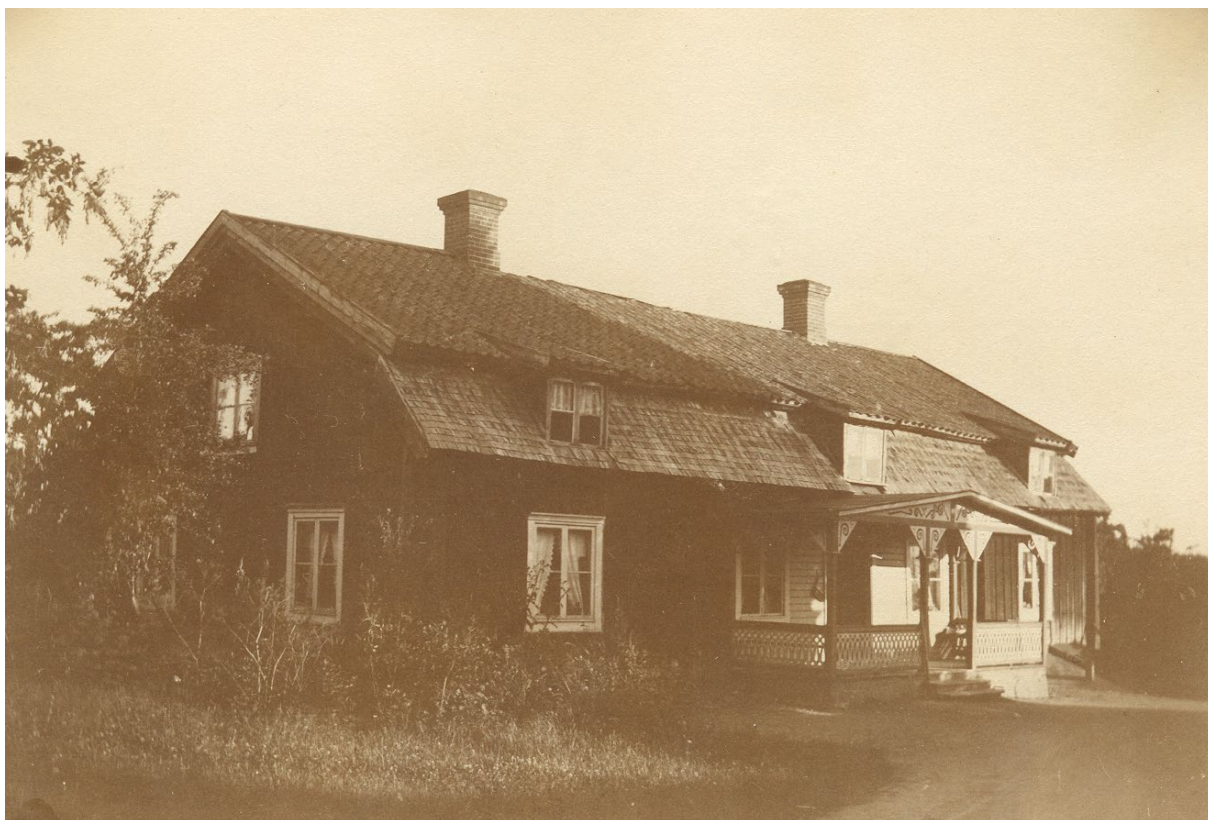
Tingshuset i Bötterum i början av 1900-talet. Här syns den veranda som uppfördes kring sekelskiftet 1900 och sannolikt revs på 1950-talet. Köksentrén är ännu inte insatt, på taket sitter mindre kupor, liknande de på gästgiveriet, och taket är belagt med enkupigt lertegel och stickespån. Foto: Kalmar läns museums arkiv (KLM_Långemåla61).
