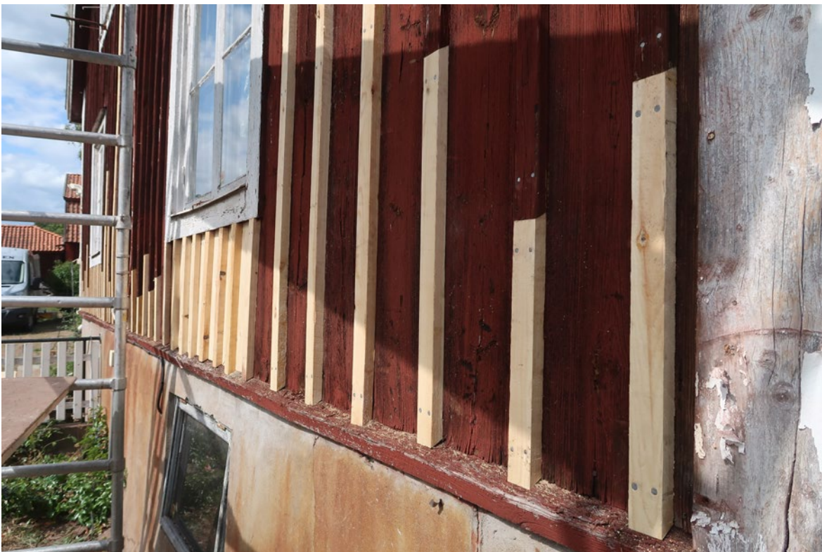
Del av sydvästra fasaden. De skarvade locklisterna fästes med två spikar för att se till så att de inte vrider sig. Foto: Jan Westergren.
