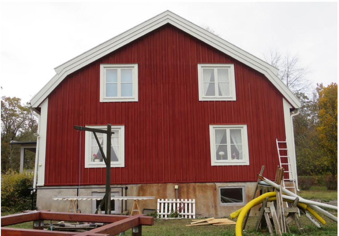
Tingshusets sydvästra fasad efter åtgärd.
