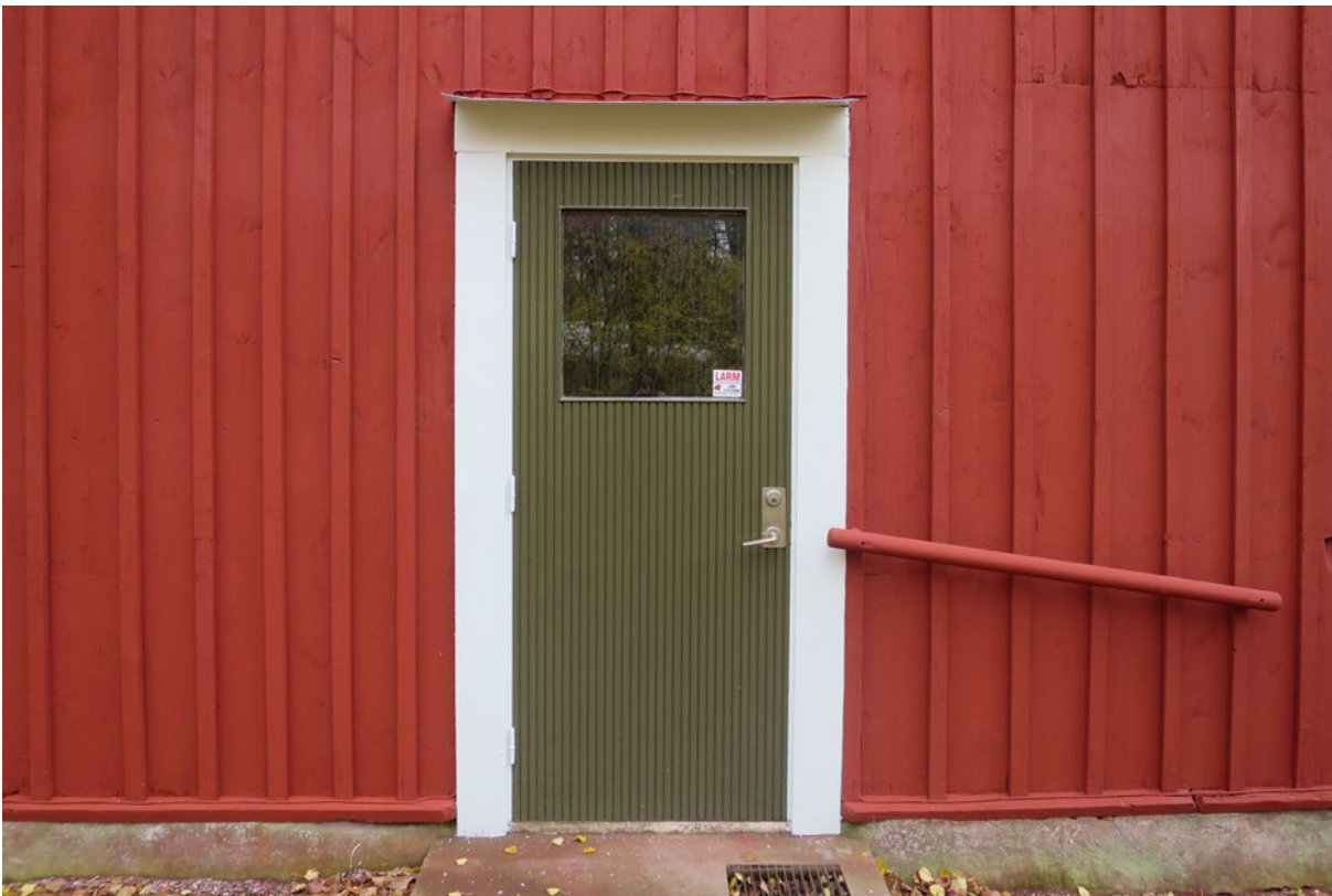
Köksdörren efter åtgärd. Ledstången på väggen har målats in i fasadkulören.
