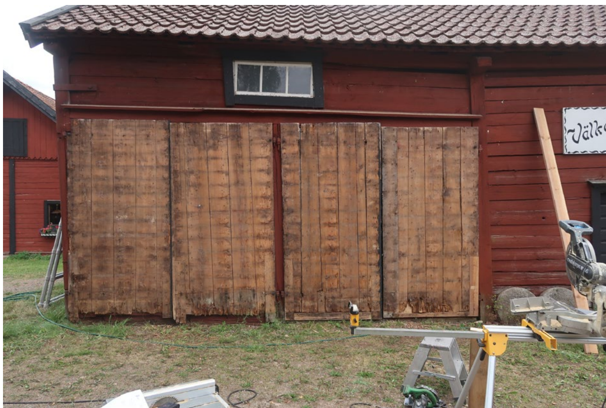
Portarna på vagnsboden under pågående åtgärd. Här har den liggande panelen tagits bort från dörrbladen. Foto: Jan Westergren.
