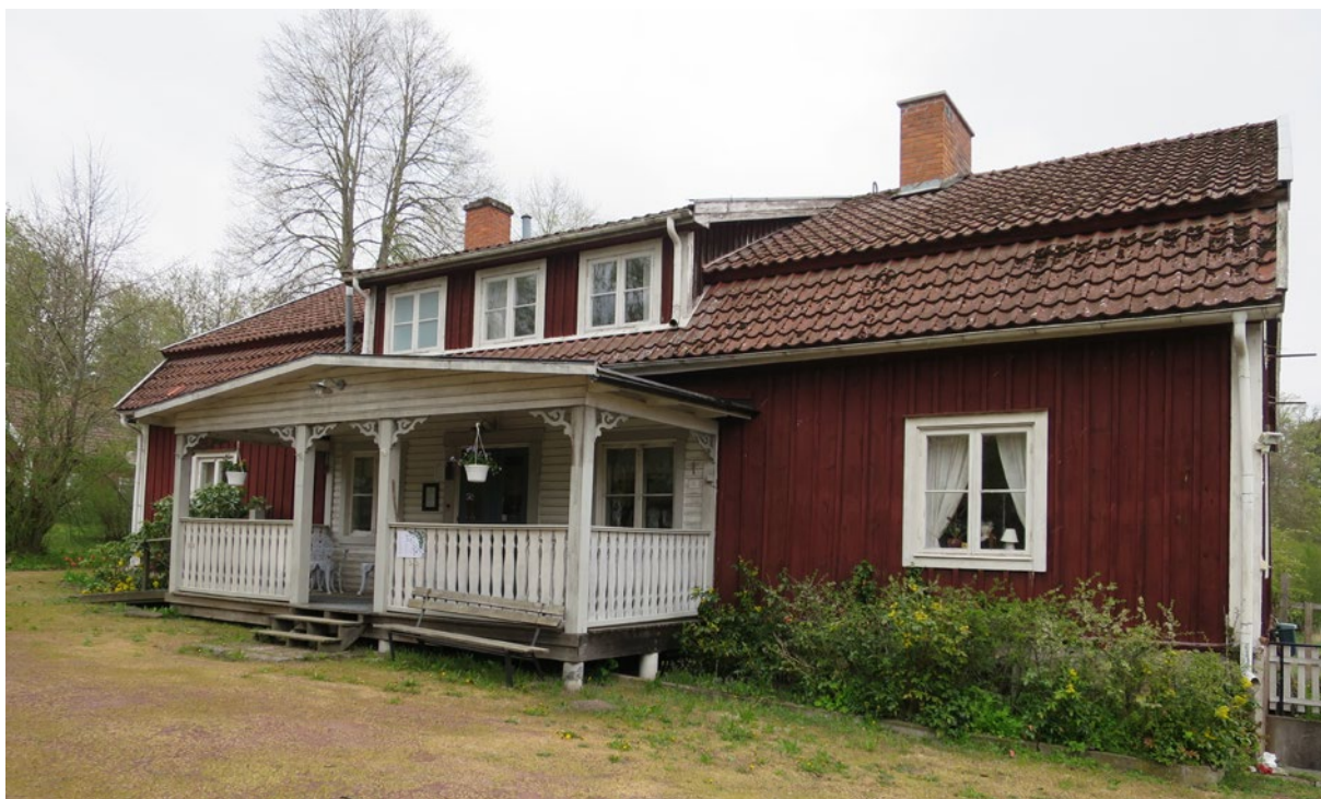
Tingshusets nordvästra fasad före åtgärd.
