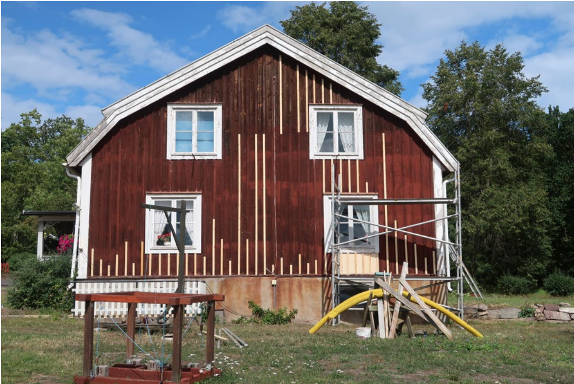
Tingshusets sydvästra fasad under pågående åtgärd. Även här har delar av panelen bytts ut. Foto: Jan Westergren.
