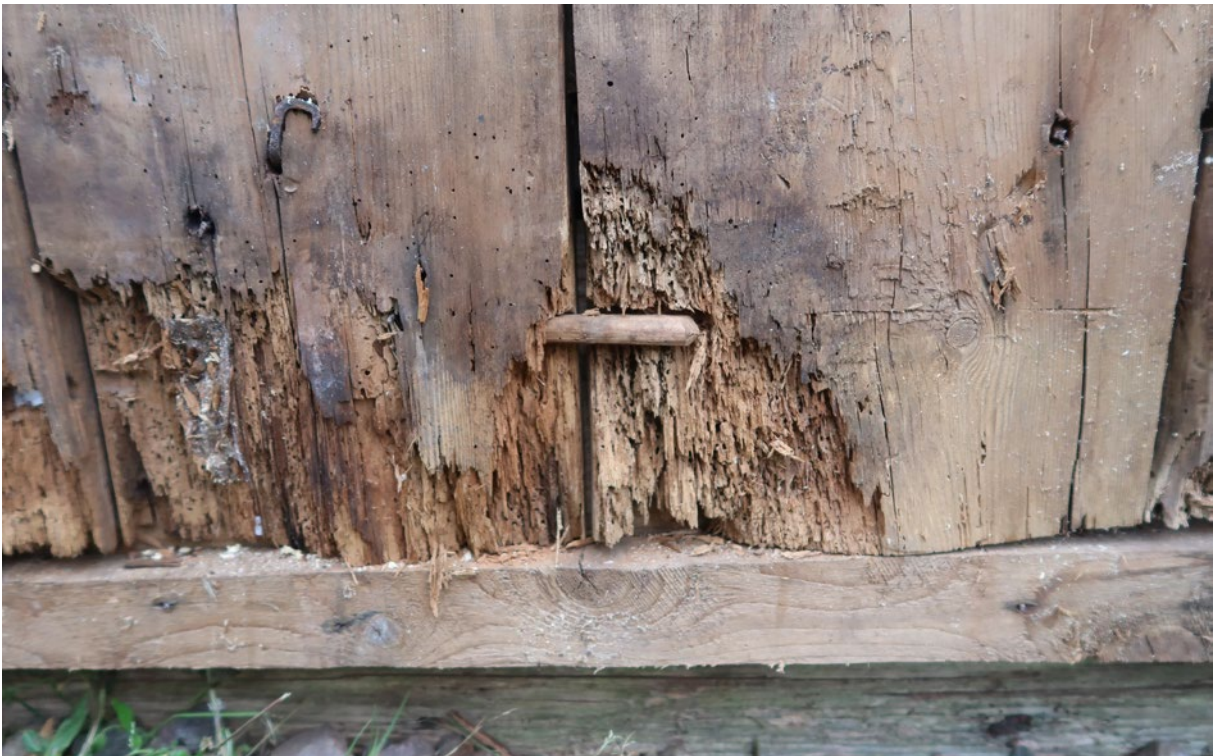
Detaljbild på en av dymlingarna som håller ihop plankorna i portarnas bakomliggande konstruktion.
