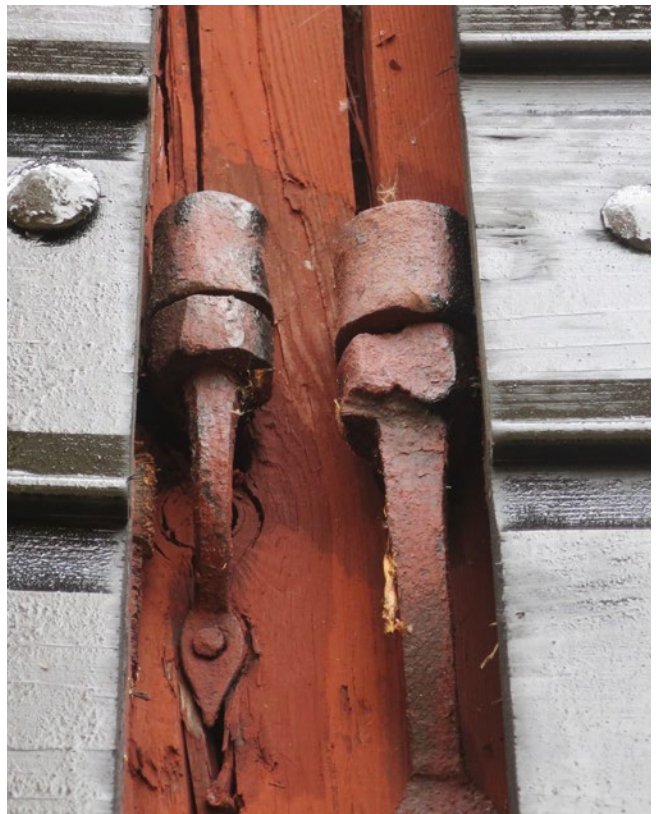
Detaljbild på gångjärnen till portarna efter åtgärd.
