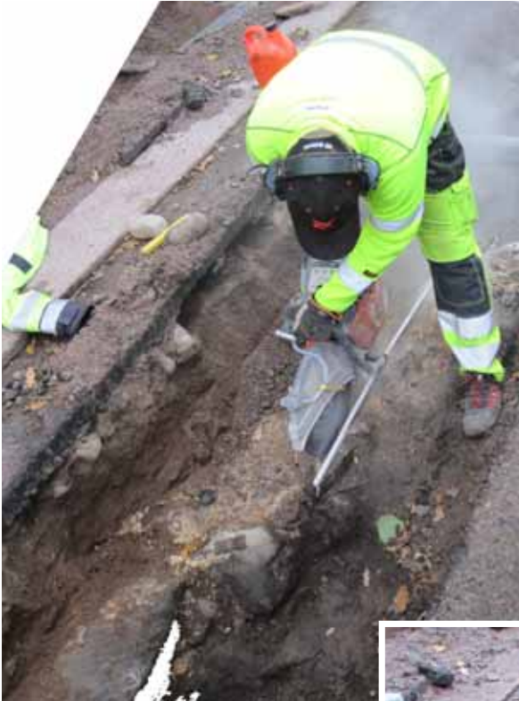
Bild 6. Stenar i muren sågades bort för att fjärrvärmeledning- en skulle kunna läggas ner.
