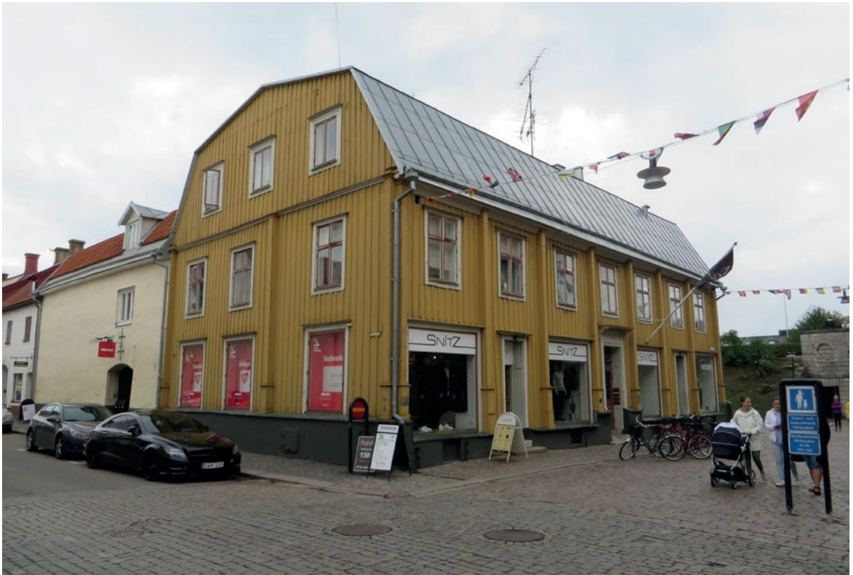
Fasad mot Kaggensgatan/Ölandsgatan, inför åtgärd.
