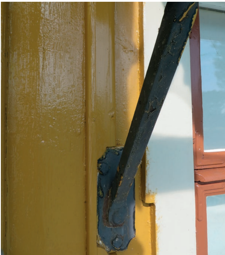
Detalj av ovan. Kontursågad locklist vid balkongens infästning.
