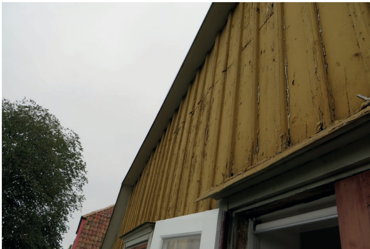
Fasad mot Södra Vallgatan, inför åtgärd.
