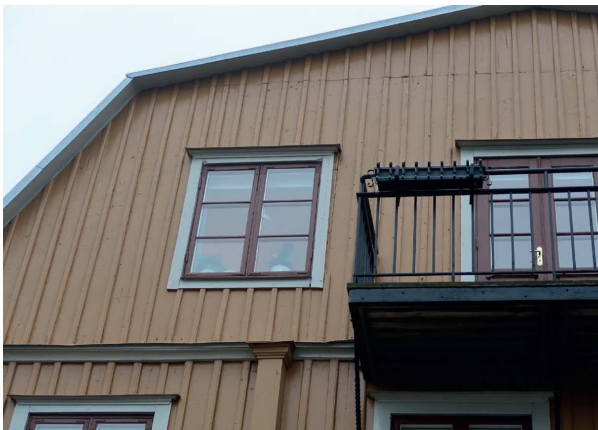
Fasad mot Södra Vallgatan, efter åtgärd.
