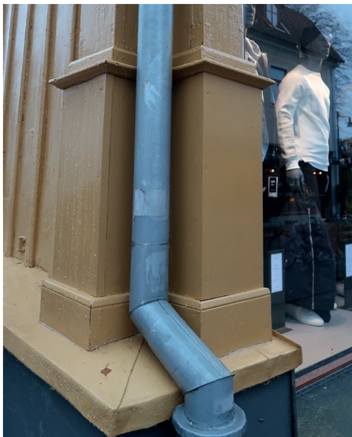
Nya knutlådor Ölandsgatan/Kaggensgatan. Efter åtgärd.
