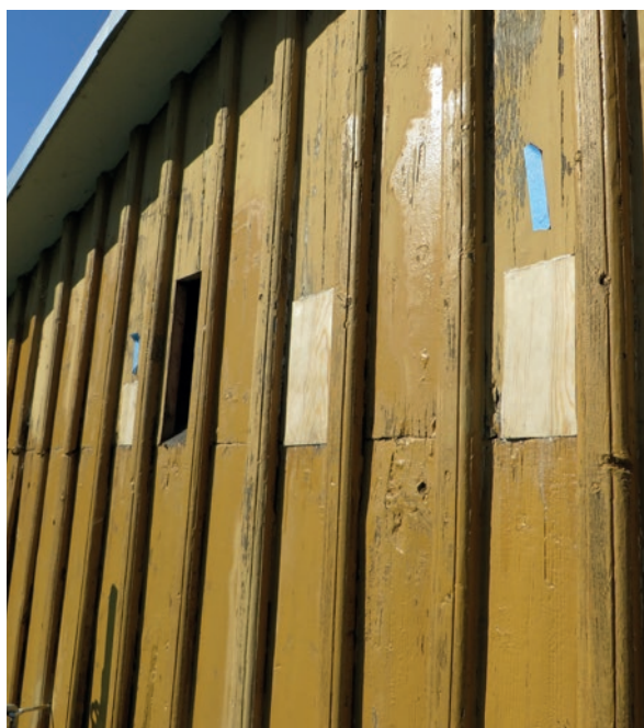
Arbete pågår med ilusning där rötskadad panel tagits bort. Södra Vallgatan, övre parti.
