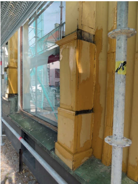
Knutlåda Kaggensgatan, under pågående renovering. Delar av listverket byttes ut.
