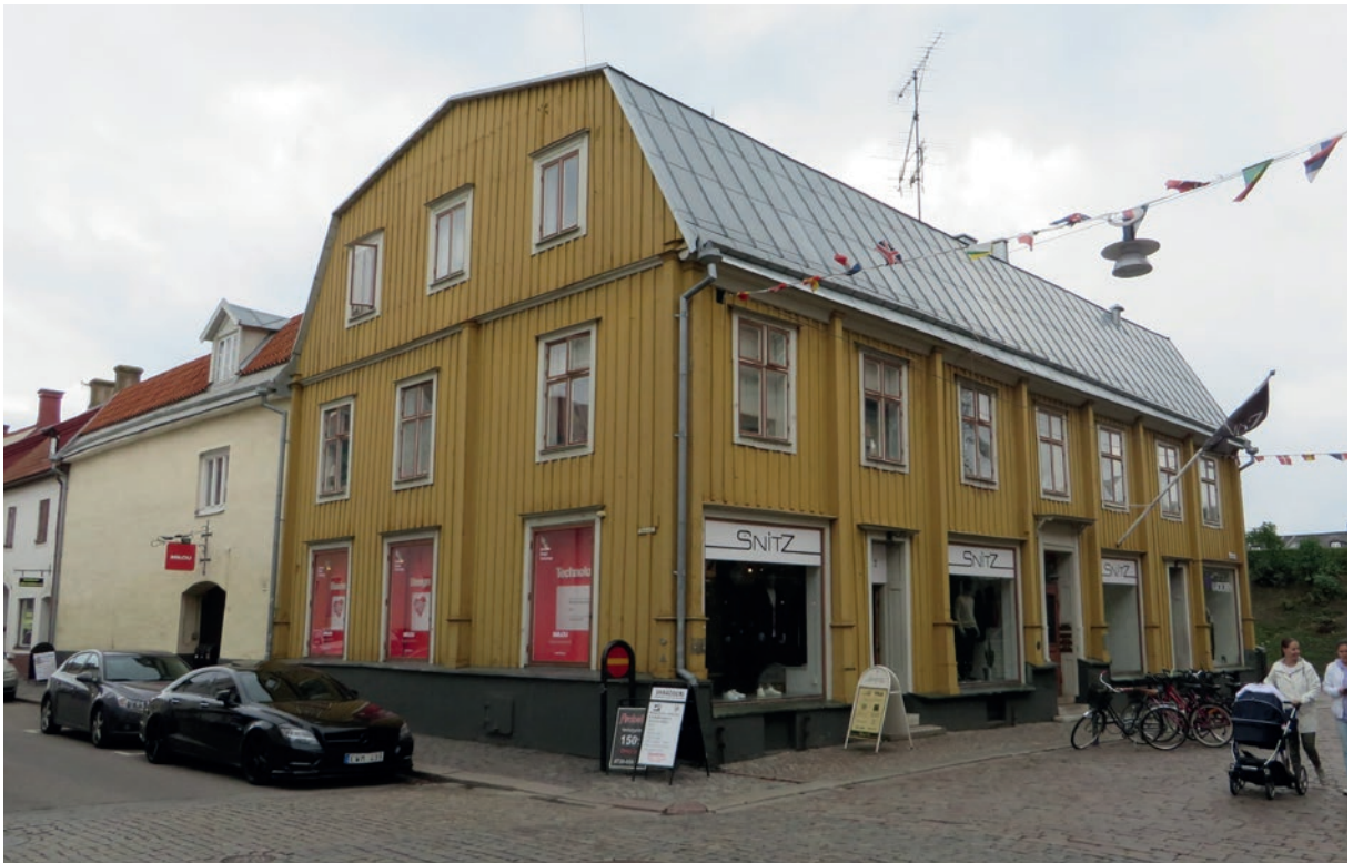
Ölandsgatan/Kaggensgatan efter åtgärd.
