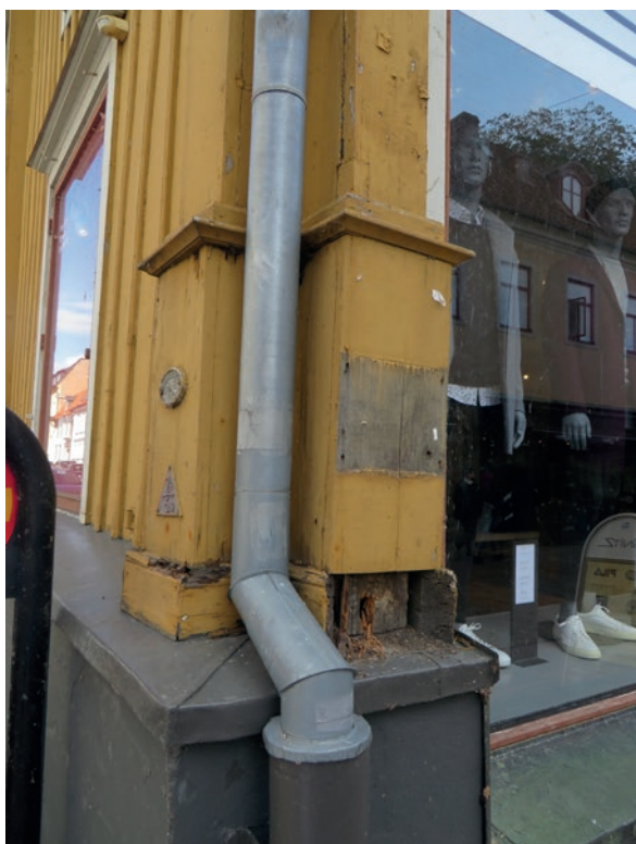
Knutlådorna i hörnet Kaggensgatan/Ölandsgatan. Påbörjad undersökning av status.
