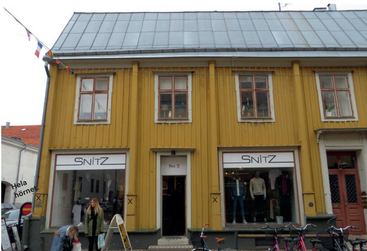
Fasad mot Kaggensgatan inför åtgärder. X-markeringar visar var delar av knutlådor byttes ut.
