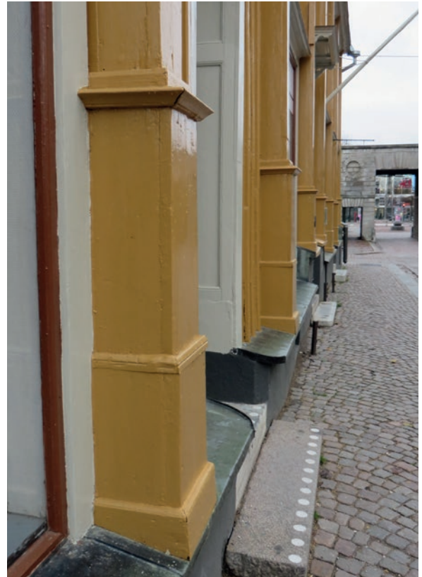
Detaljer Kaggensgatan efter slutfört arbete.
