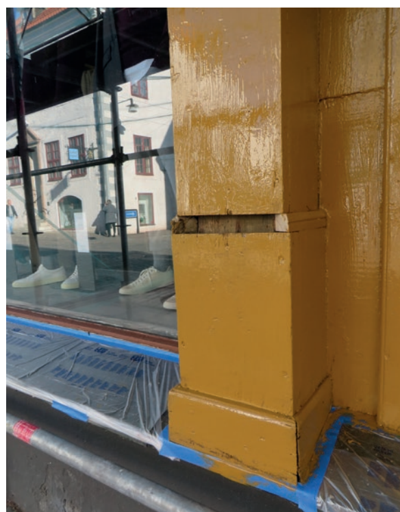
Knutlåda mot Kaggensgatan, under pågående renovering. Delar av listverket byttes ut.
