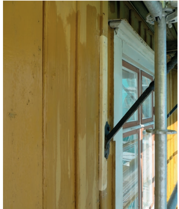
Fasad mot Södra Vallgatan, väster om balkongen. Utbytt locklist inför målning.
