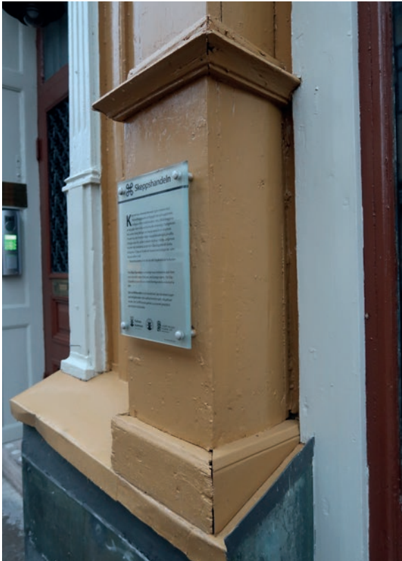
Detaljer Kaggensgatan efter slutfört arbete.
