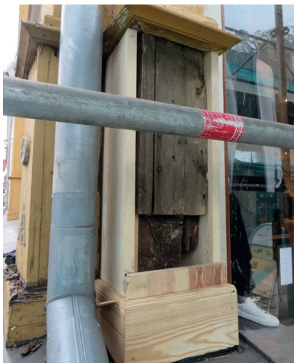
Inklädnad med nytt virke påbörjad.
