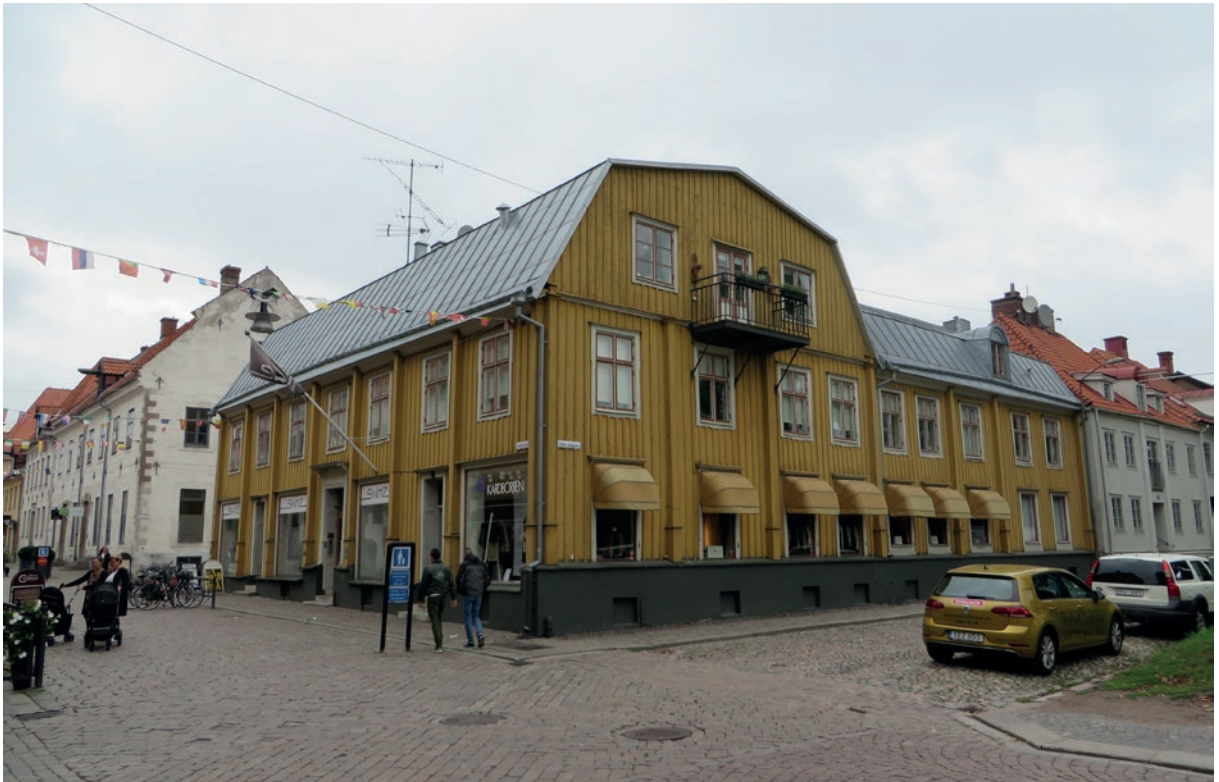
Fasad mot Kaggensgatan/Södra Vallgatan, inför åtgärd.
