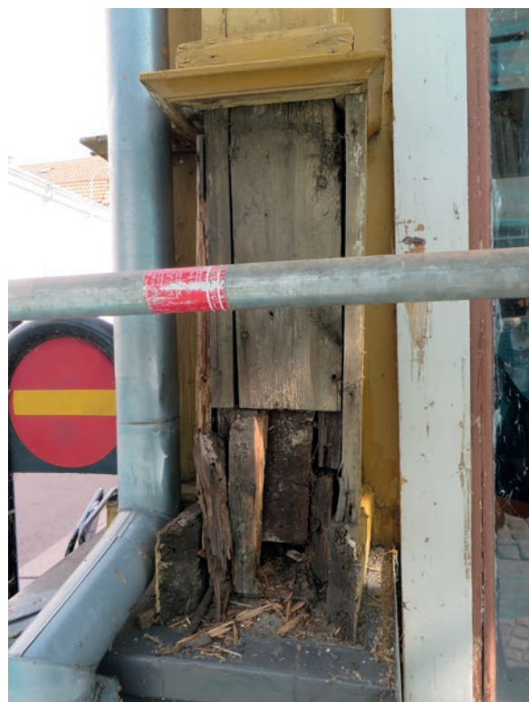
Knutlådorna i hörnet Kaggensgatan/Ölandsgatan. Rivning av inklädnad påbörjad.
