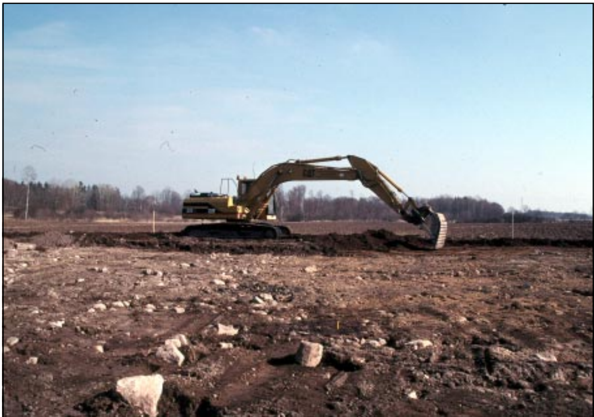
Figur. Undersökningsområdet under avbaning. Foto: Robin Olsson
