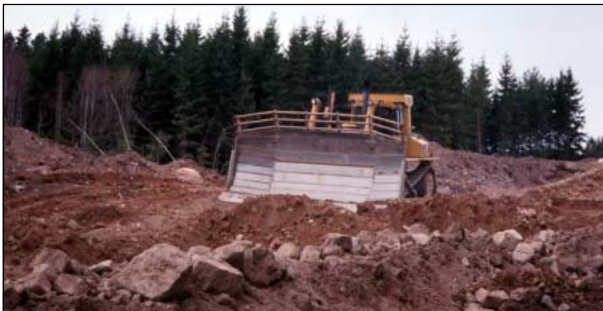
Fig 20. Så här såg det ut efter undersökningens slut när vägen hade börjat byggas. Foto: Malin Gustafsson
