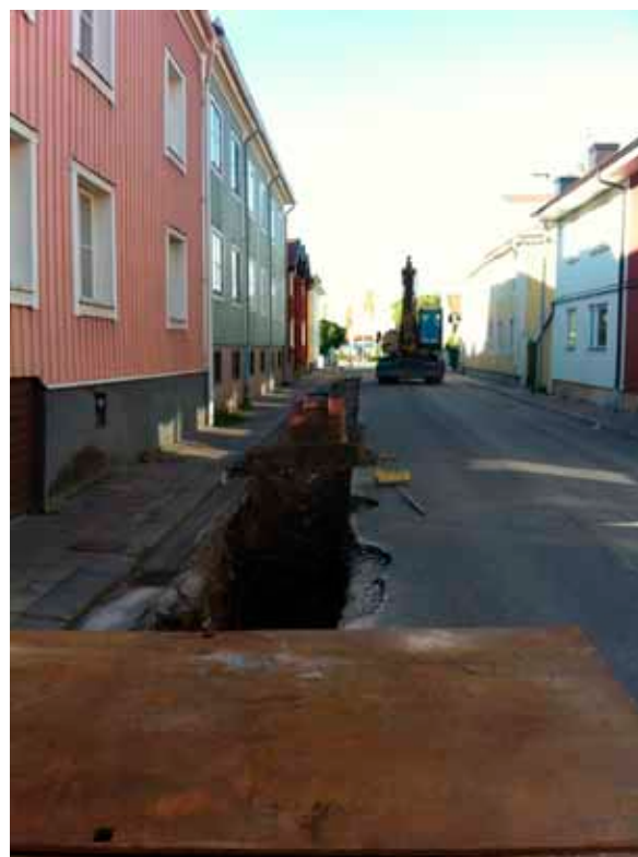
Fig. 3-4. Schaktning för ny fjärrvärmeledning i Hamngatan. Översikt från SÖ. Foto: V Palm, KLM/VM 2012.
