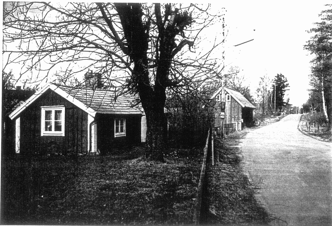
Vägmiljö vid Sandåsgatan
