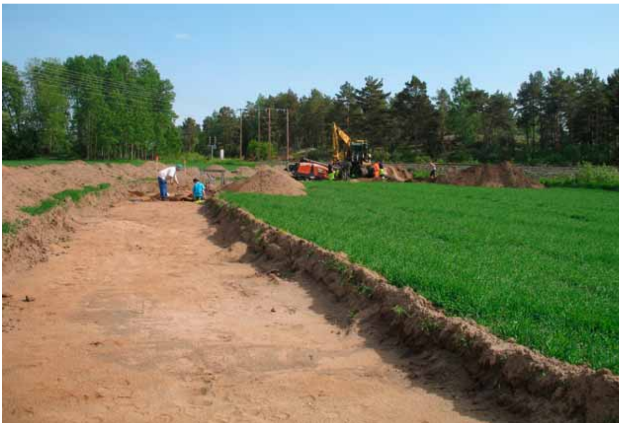
Fig. 4. Hella Schulze gräver anläggningar i den S delen av schakt 1. I bakgrunden arbetas det med att trycka rör under banval- len. Foto från NV. Foto: Kalmar läns museum.
