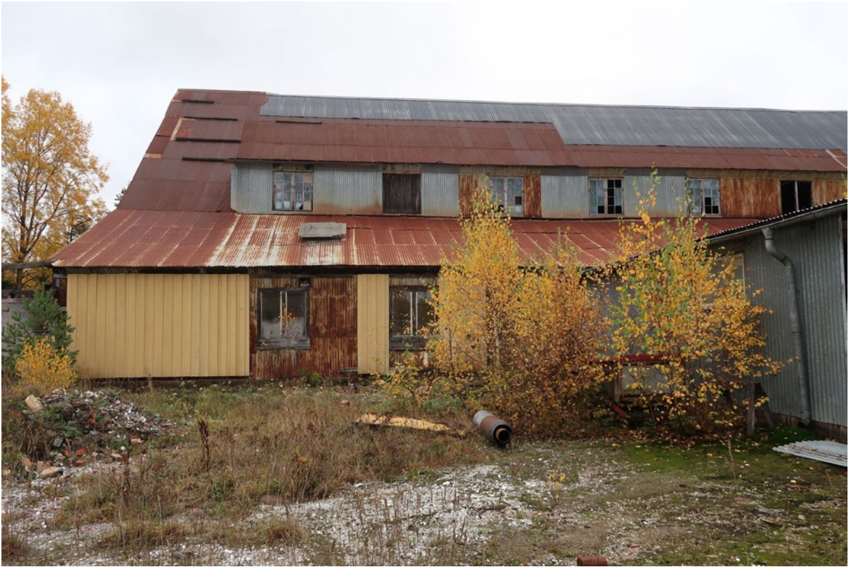
Hyttans västra långsida, med platsen för skorstenen i förgrunden.
