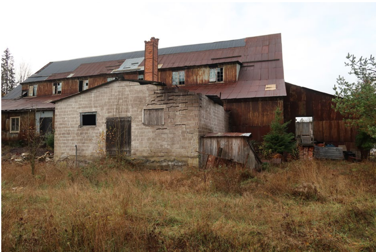
Östra långsidan och byggnaden för tempererugnen (nr 4).
