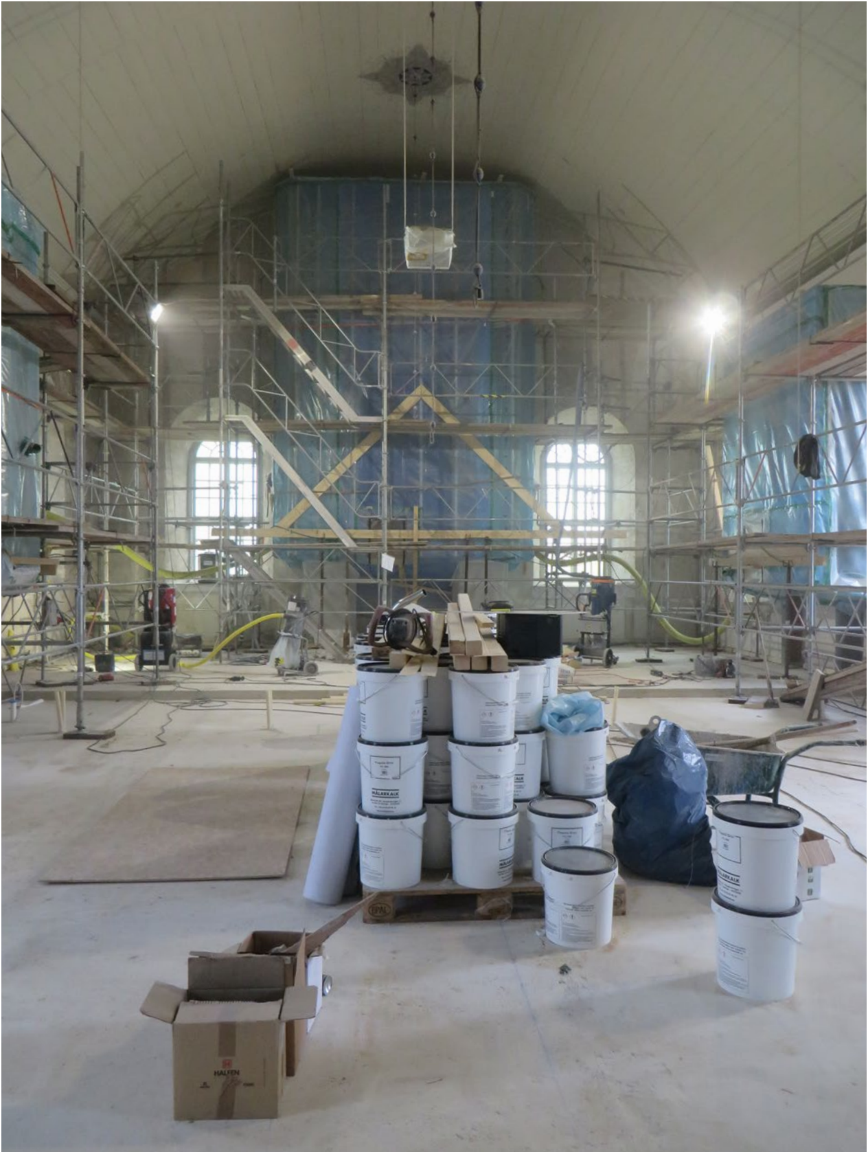
Pågående putsreparationer i kyrkorummet. Fotografi mot öster. I förgrunden står burkar med finputs från Målar-kalk.
