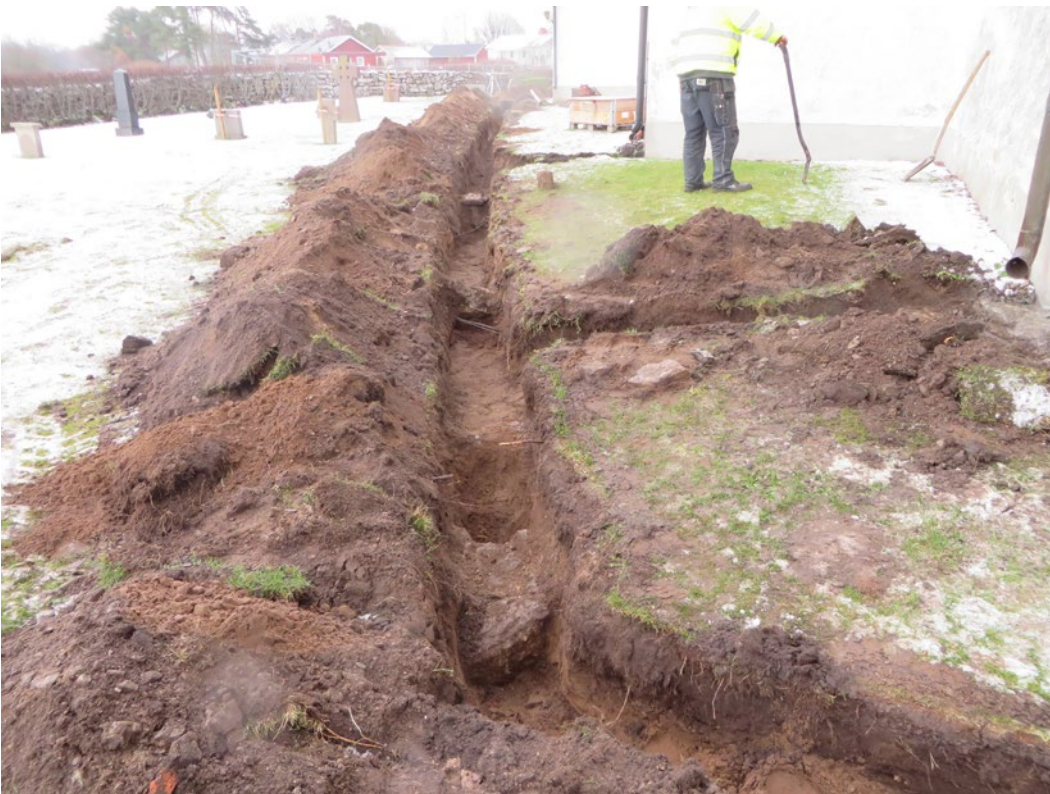
Schakt för dagvattenledning vid tornets norra sida. Fotografi mot nordost. Uppe till vänster i bild skimtar stupöret vid långhusets nordvästra hörn.
