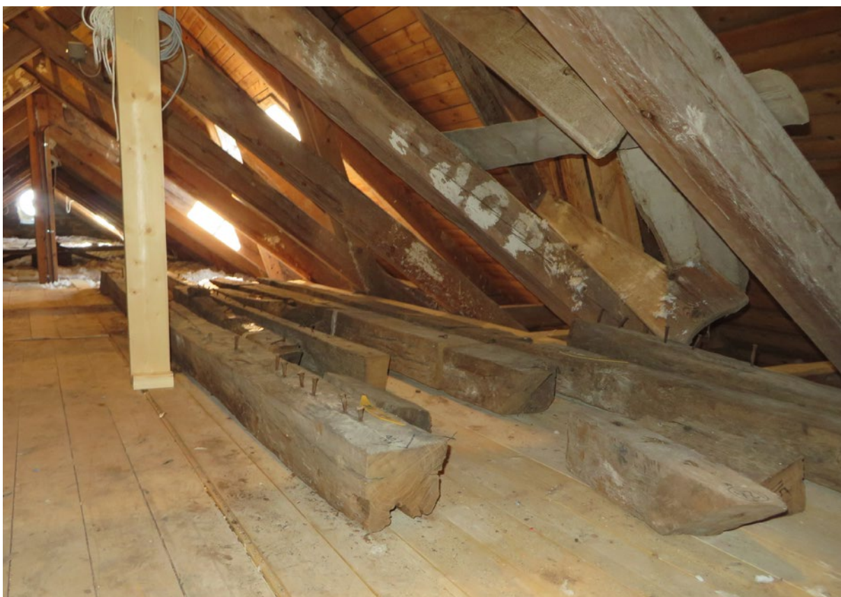
De tillvaratagna balkarna har placerats uppe på långhusets vind.
