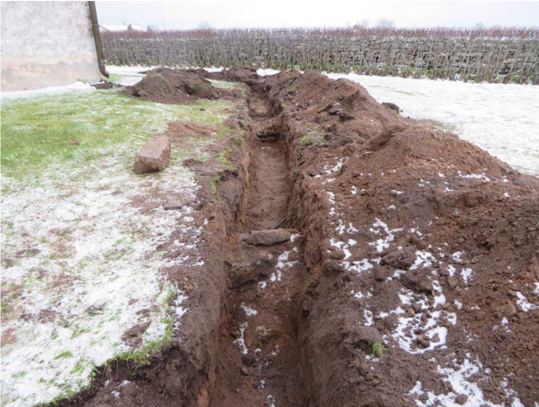
Schakt för dagvattenledning vid tornets norra sida. Fotografi mot sydväst. På bilden syns de oregelbundna murrester som upptäcktes vid schaktningen.
