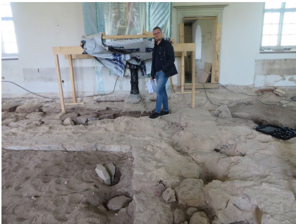
Elentreprenören Johan Åberg markerar läget av de stenar från medeltidskyrkan som sköt upp så högt att de skulle synas över kalkgjutningen. Just dessa stenar lyftes bort. I övrigt gjordes inga ingrepp i de delar av de medeltida murar som fanns kvar efter den arkeologiska undersökningen. Fotografi från 2016-05-23.
