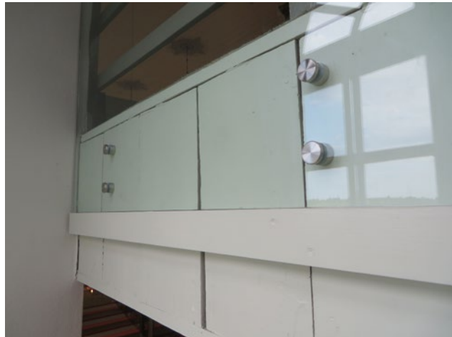
Övre delen av fönsternischerna längst bak i kyrkorummet har försetts med glas för att man skall kunna hålla en högre temperatur i utrymmena under läktaren än i övriga kyrkan.
