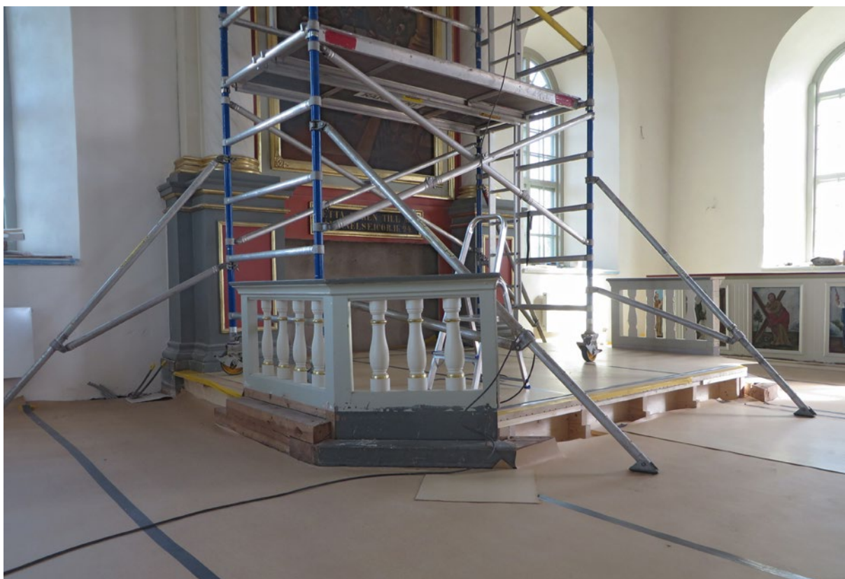
Altarringen sedd från nordväst under pågående ombyggnad. Ytor som varit dolda hade en mörkgrå kulör.
