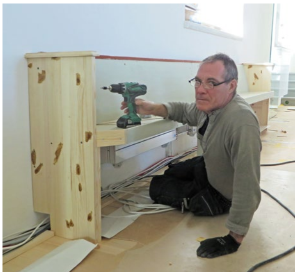
Sidobänkarna försågs med nya gavlar eftersom de gamla skadats vid demontering och flyttningar. På bilden syns snickaren Gert Svensson.
