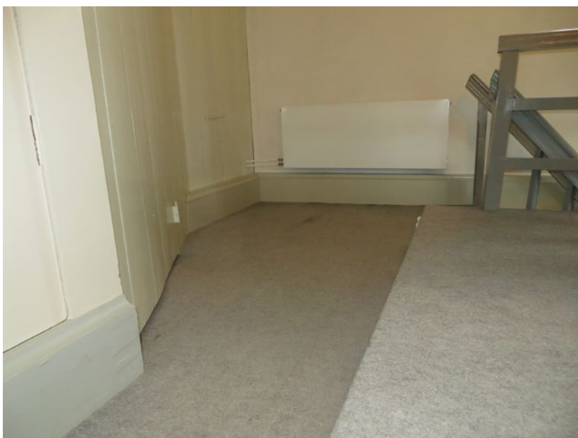
Den nya installationssockeln gavs samma höjd och profil som den ursprungliga sockeln till vänster i bild.
