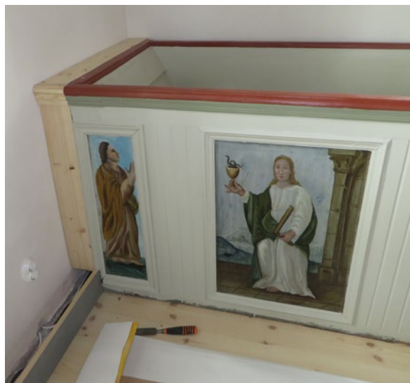
Korbänkarnas fronter förlängdes med nytt virke vid den östra sidan, så att den nya installationssockeln inte skulle inkräkta på målningarna. Det urtag som syns i det nedre vänstra hörnet av målningens ram fanns redan tidigare.
