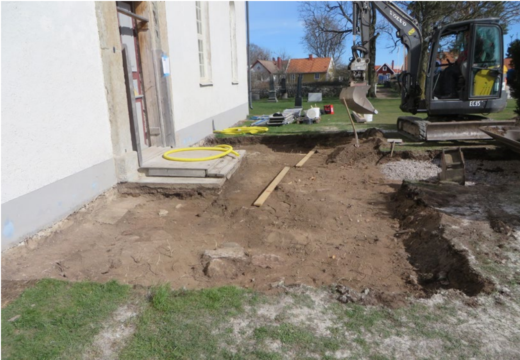
Schaktet framför kyrkans södra entré fotograferat från väster. 15-25 cm under marknivå fanns många kalkstenar. Samtliga stenar lämnades orörda under det skikt av makadam som lades ut sedan schaktningsarbetena avslutats.
