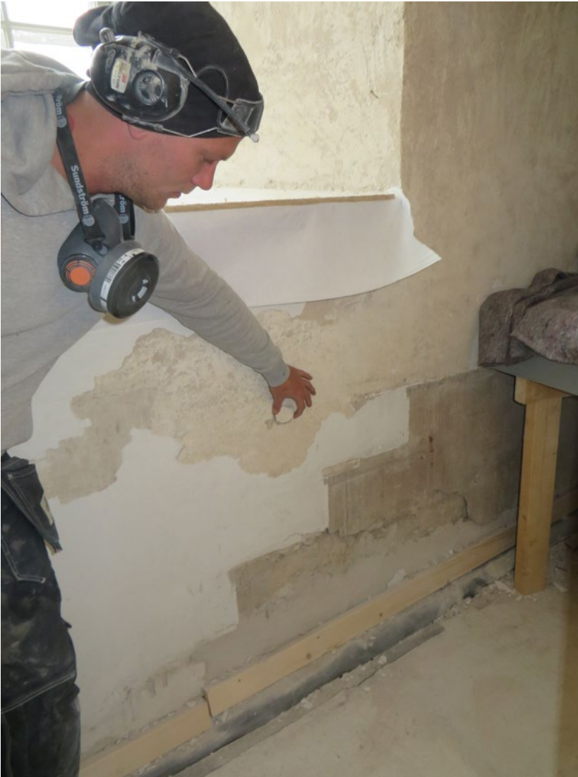
Muraren Jonas vid en yta där kulörskillnaden mellan det övre och undre putsskiktet syns tydligt. Det undre skiktet hade en gulrosa ton.
