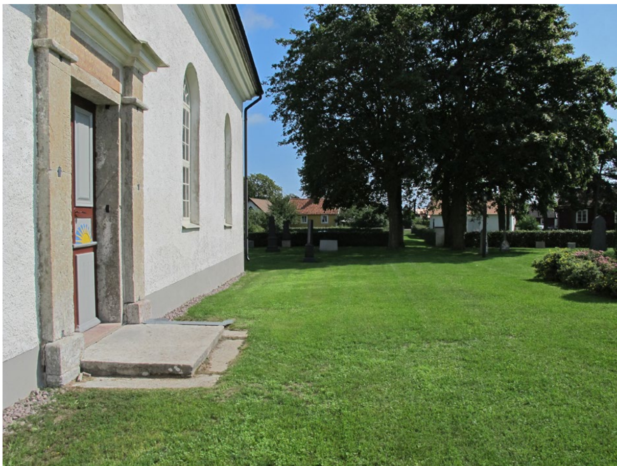
Gårdby kyrkas södra entré före åtgärd. Fotografi mot öster.
