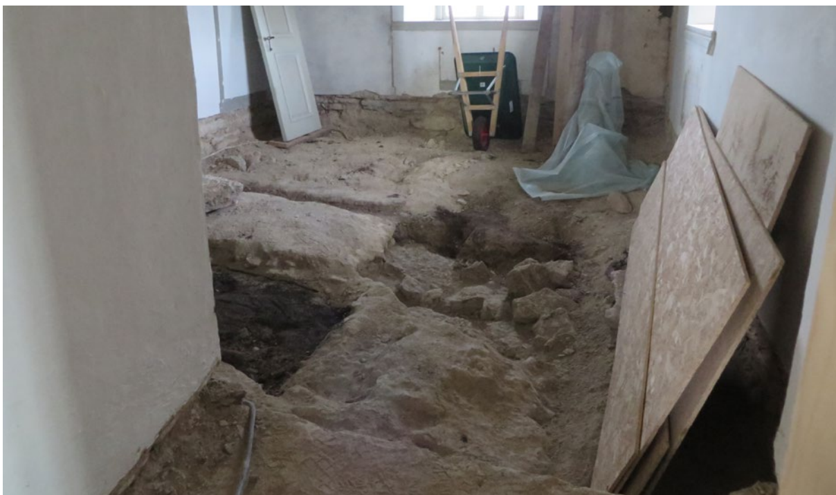
Sakristian sedd från dörröppningen till koret, innan arbetet med att bygga ett nytt bjälklag påbörjats.
