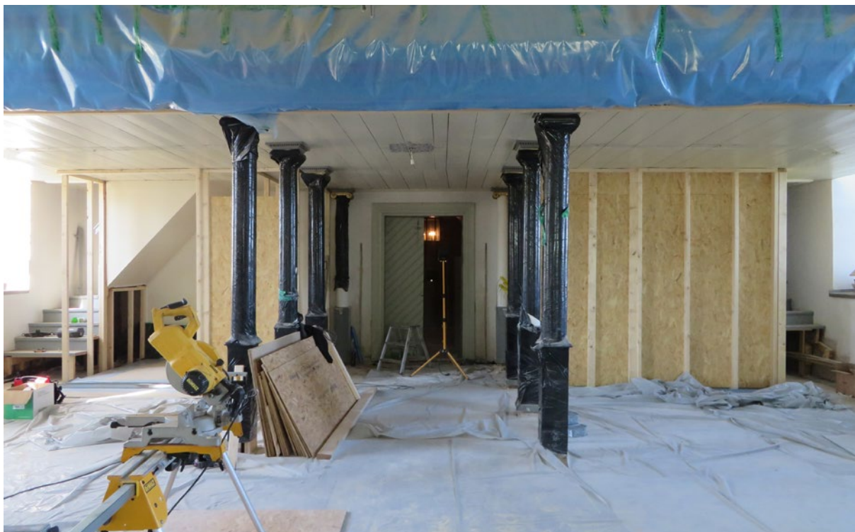
Den nya läktarunderbyggnadens mellanväggar under uppförande.
