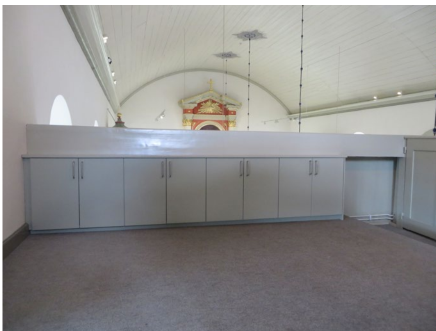
Norra delen av läktarbarriärens baksida efter montering av nya skåp.
