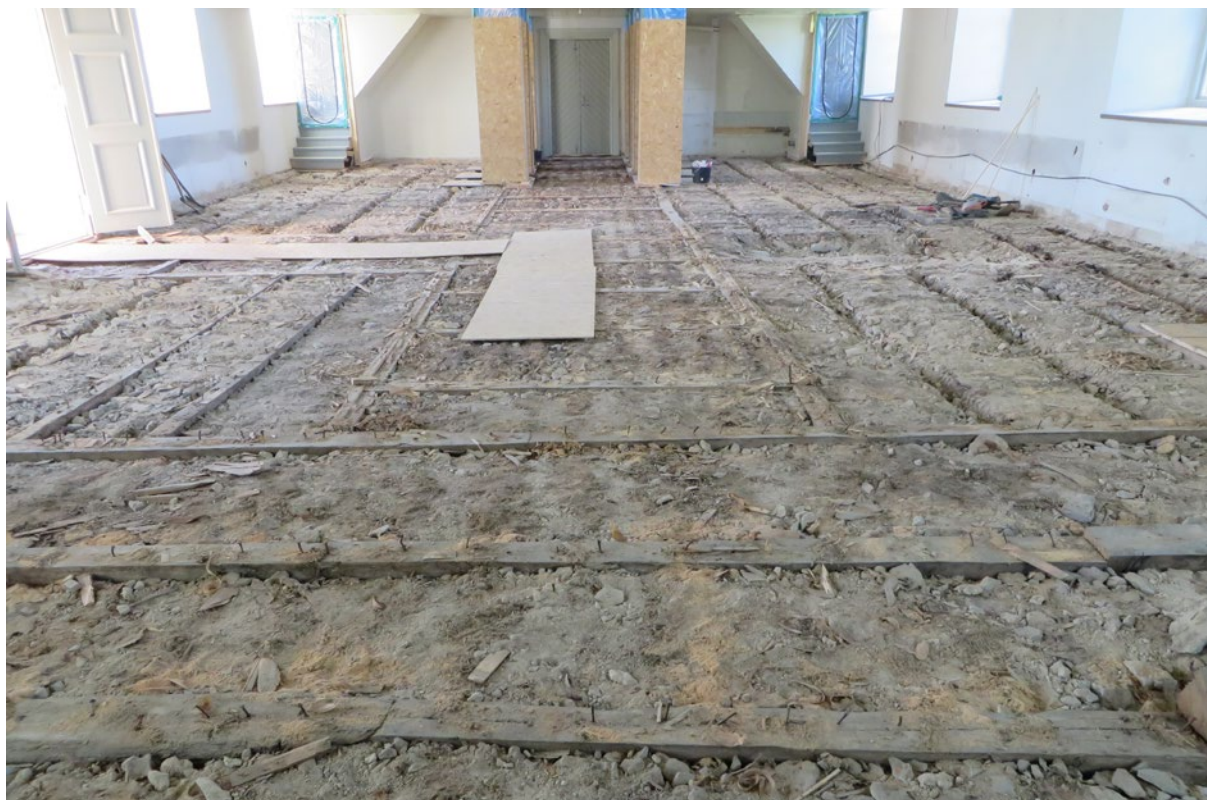
Vid rivningen av brädgolvet upptäcktes återanvända ekbalkar från medeltidskyrkans takkonstruktion.
