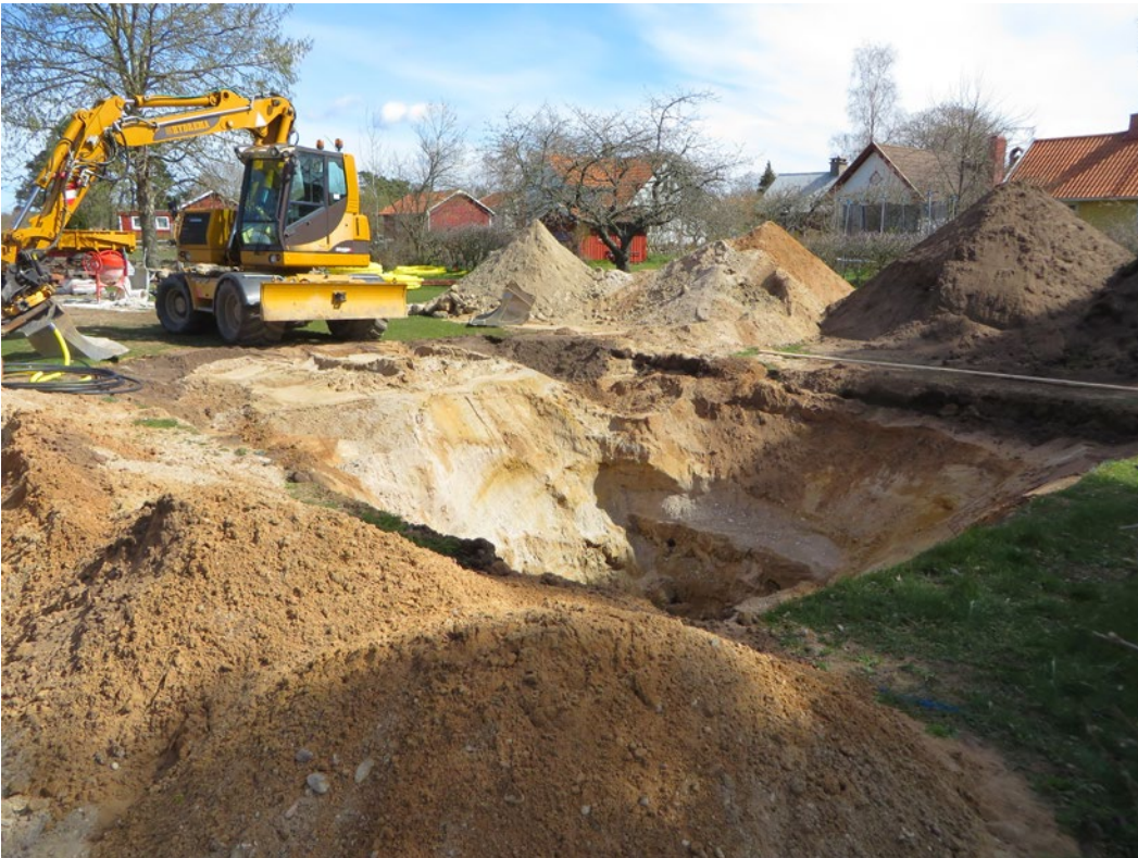
Grävning för vattencistern öster om kyrkogården.
