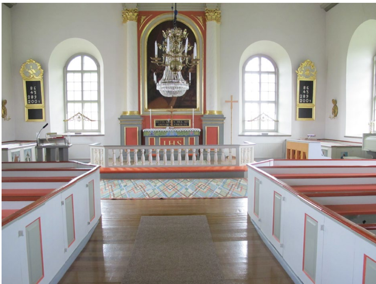
Altarringen och altaruppsatsen innan rivningsarbetena påbörjades.
