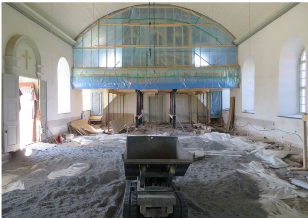
Gårdby kyrkas interiör mot väster. När de arkeologiska undersökningarna var avslutade täcktes marken med geotextil. Gropar jämnades ut med grovt grus. Fotografi från 2016-06-02. Den platta av kalkbruk som göts syns på sidan 38. Den övre bilden på sidan 68 visar långhuset under pågående läggning av brädgolv.
