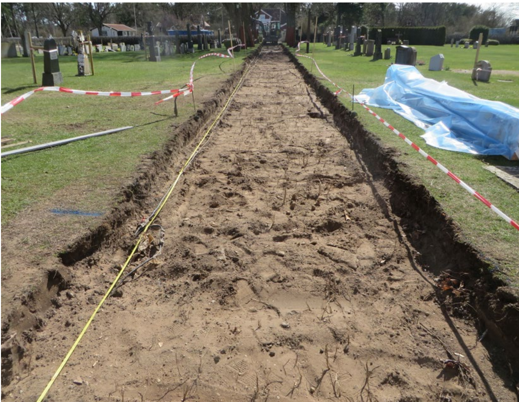
Schakt för anläggning av ny gång mot söder.
