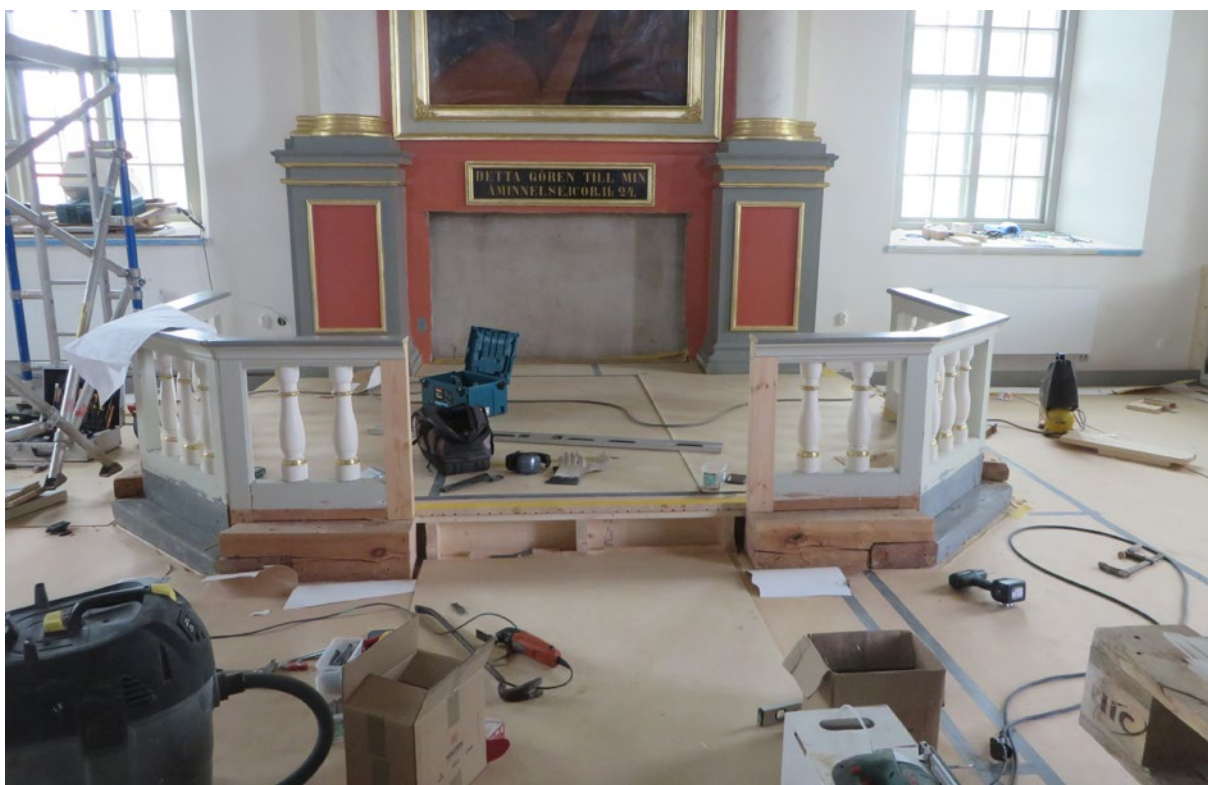
Altarringen sedd från väster under pågående ombyggnad.
