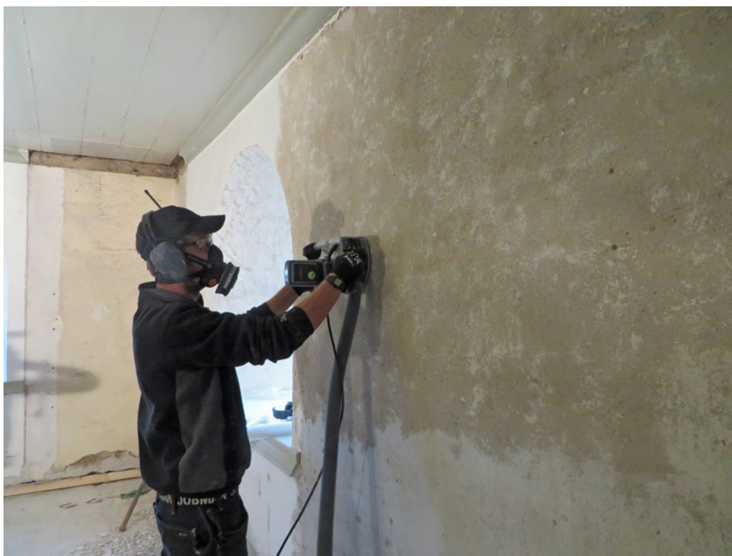
Efter skrapning frästes ca 1 mm av ytan på det underliggande putsskiktet bort, för att ny puts skulle fästa ordentligt.
