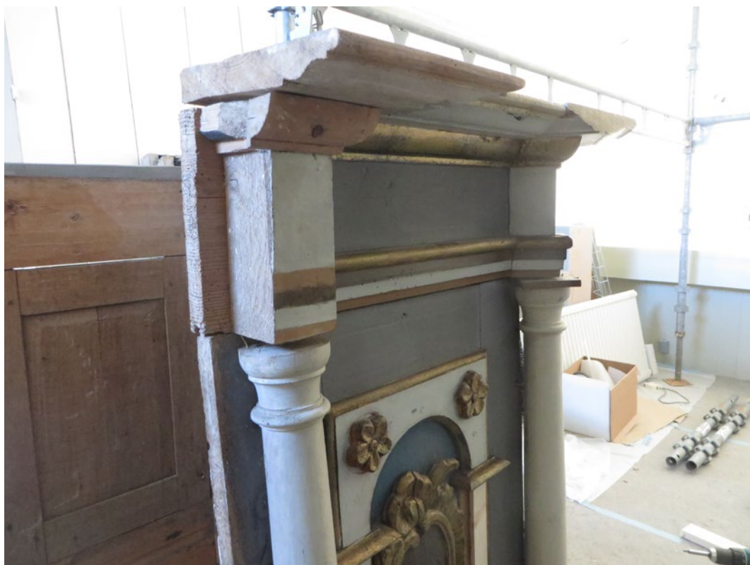
Den gamla predikstolen från 1702 hade skador som troligen uppkommit i samband med någon flyttning. Avståndet över kolonnen närmast i bild fylldes med en träbricka, på samma sätt som vid de övriga kolonnerna.
