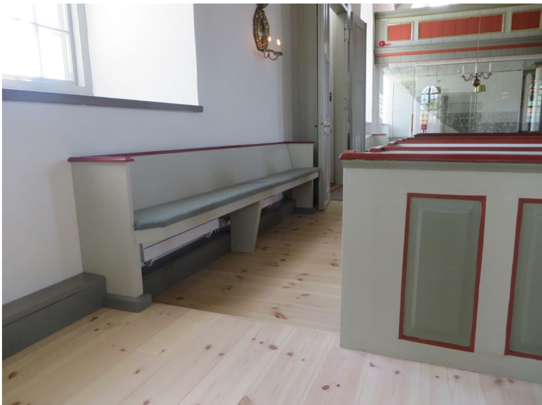
Sidobänkens längd har anpassats så att bänkgaveln ligger i liv med bjäklagskanten och bänkkvarterets front.
