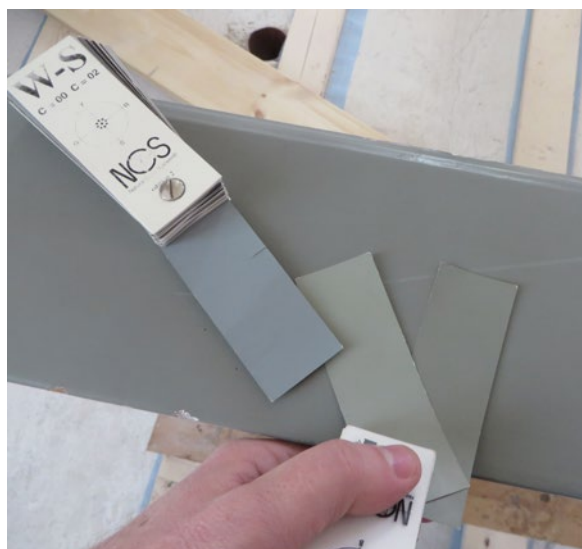
Kontroll av kulör på altarringens överliggare. Provet till höger stämde bäst. Överliggaren målades i kulören NCS S 5005-G80Y (mörkt grågrön). De svarvade stolparna målades i brutet vitt, NCS S 0505-Y20R, och övriga delar av ramverket ljusst gråbeige, NCS S 2005-G80Y.
