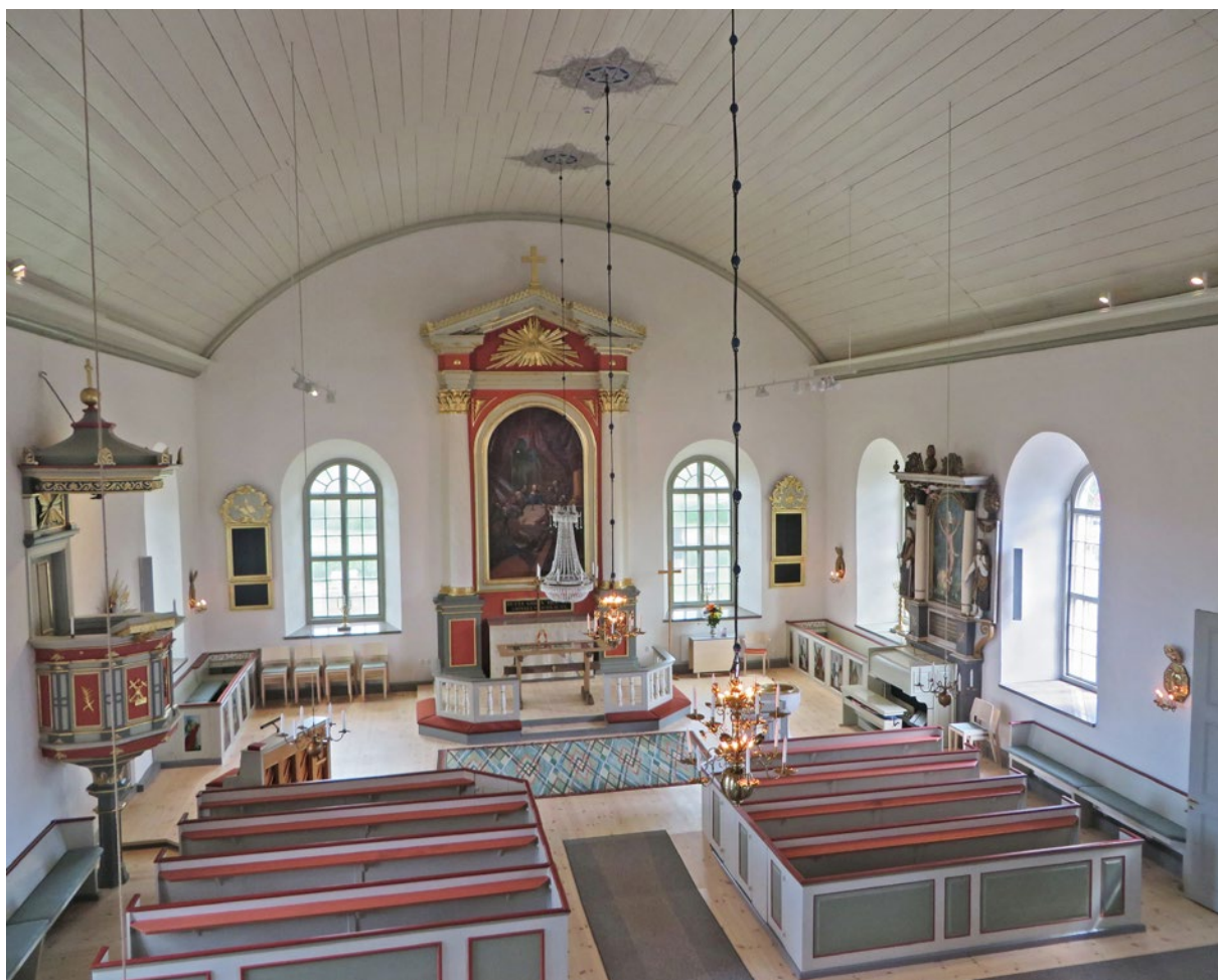
Kyrkorummets östra del efter avslutade arbeten.
