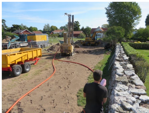
Pågående borrning för bergvärme norr om kyrkogården.
