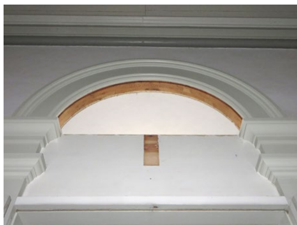
Vindfångets övre del efter borttagning av träskiva och kors. Jämför med fotografi på sidan 25.
