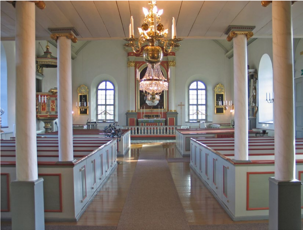
Gårdby kyrkas kyrkorum sett från väster innan arbetena påbörjades. De bakre bänkkvarteren anslöt mot pelarna under läktaren.
