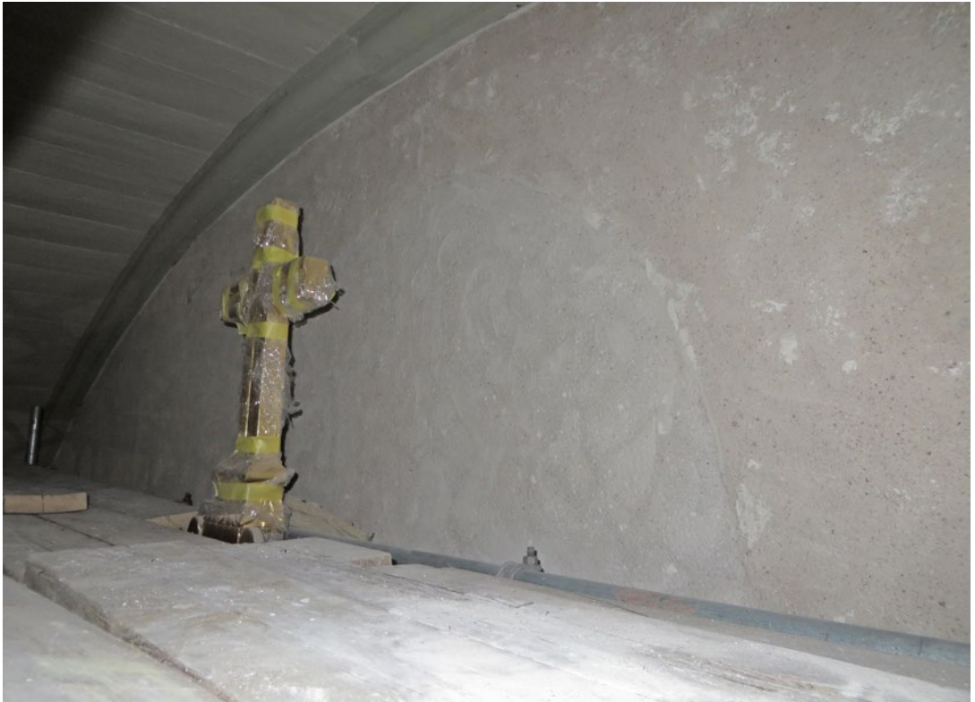
När skikten av kalkfärg slipats bort framträdde spåren efter det lunettfönster som suttit över altaret på den östra gavelväggen.
