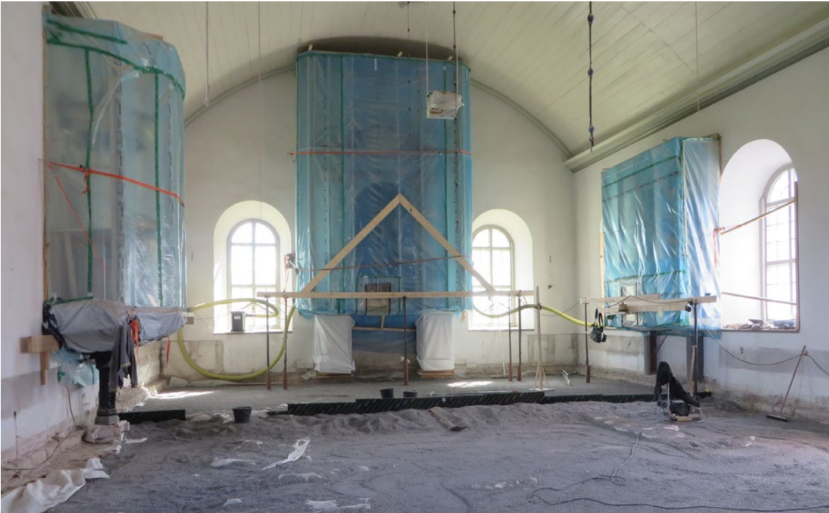
Predikstolen och de båda altaruppsatserna kunde gasbehandlas inom de befintliga inkädnaderna.
