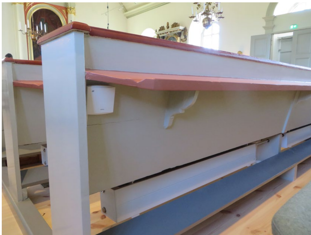
Exempel på placering av trådlös givare i kyrkorummet.
