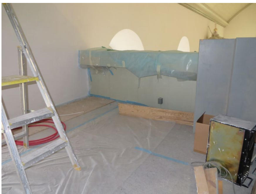
Norra delen av läktaren under pågående bygge, före montering av skåp bakom läktarbarriären.
