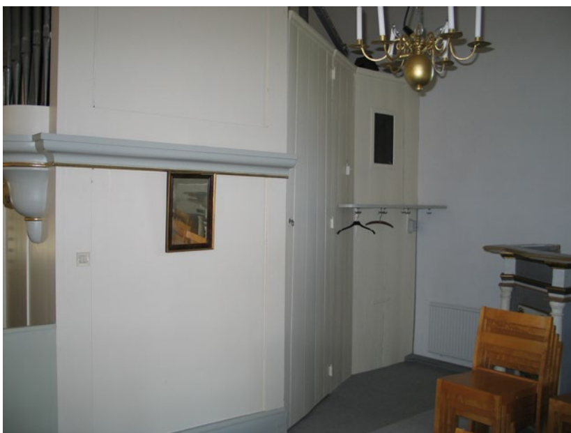
Orgelhusets möte med västra gaveln innan kyrkans renovering påbörjades.
