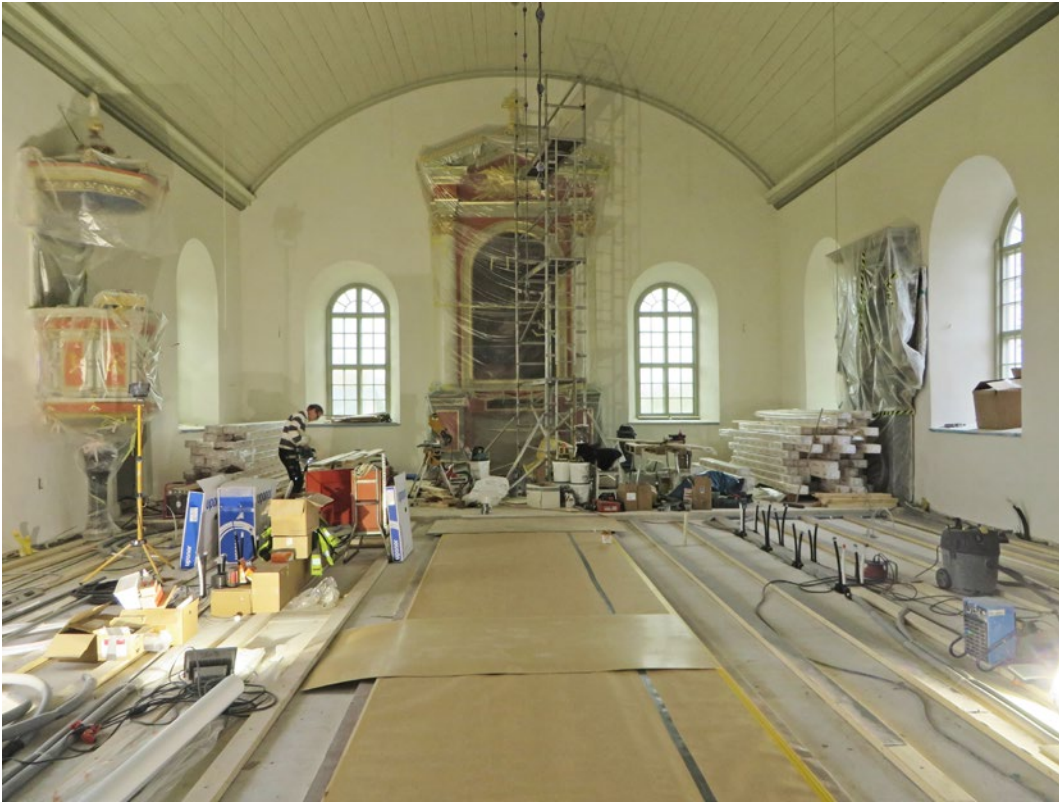
Kyrkorummet under pågående framdragnig av värmeledningar (grå). Ledningarna förlades till utrymmet mellan brädgolvet och kalkgjutningen.
