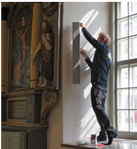
Montering och justering av högtalare i fönster-nischen intill den gamla altaruppsatsen i söder.
