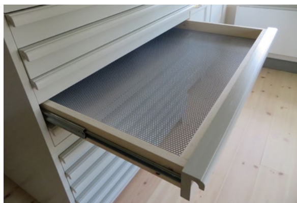
Lådbottnar har utförts av perforerad pulverlackerad stålplåt.
