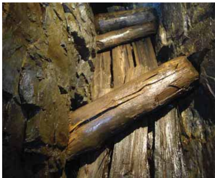
Fig 163. Detalj av timmerbotten 34 m ned i Svenskgruvan. Foto: B & S Gunnvall, 2009.
