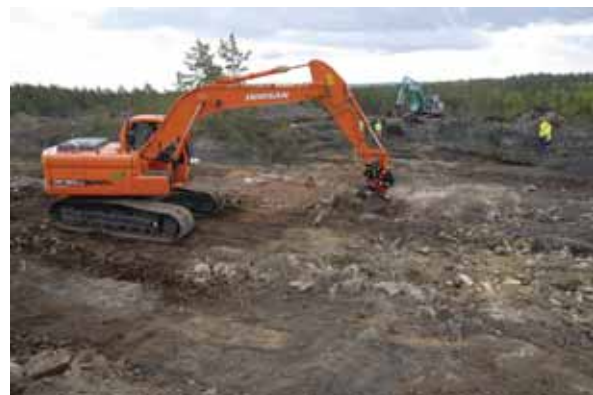
Fig 194. Undersökning av smältverksgrunden Ho29, från N. Foto: F Sandberg, DM.
