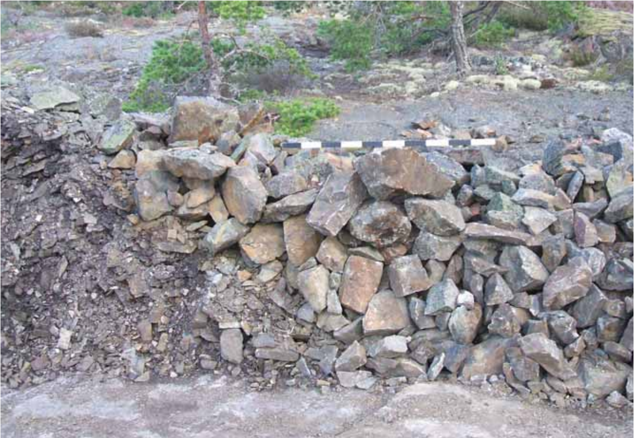
Fig 180. Senare tiders sprängda varp är stor och klumpig mot den äldre tidens småskiviga tillmakade varp. Foto: N Nilsson, KLM.
