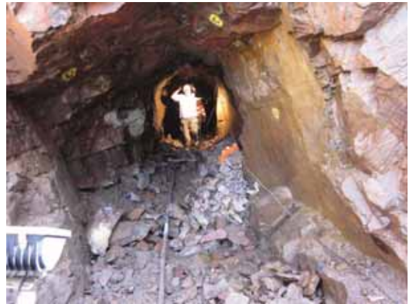
Fig 18. Under våren 2011 påbörjades förberedelser för att gjuta igen stollgångens mynning. Genom s.k. skrotning vidgades mynningen och löst berg borttogs. Foto: U Palmér, Empirikon.
