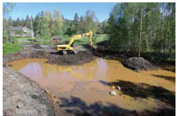
Fig 20. Sanering av slaggvarpen vid Hyttan försommaren 2011. Foto: U Palmér, Empirikon.
