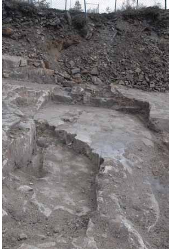
Fig 101. Dagbrott Ho159 väst om Tyskgruvans schakt Ho42, sett från VNV. Foto: F Sandberg, DM.
