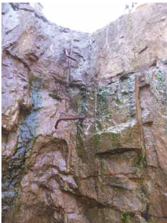
Fig 175. Borrspar efter maskinborr i samband med vidgning av dagschaktet vid Bondegruvan. Foto: V Palm, KLM/VM.
