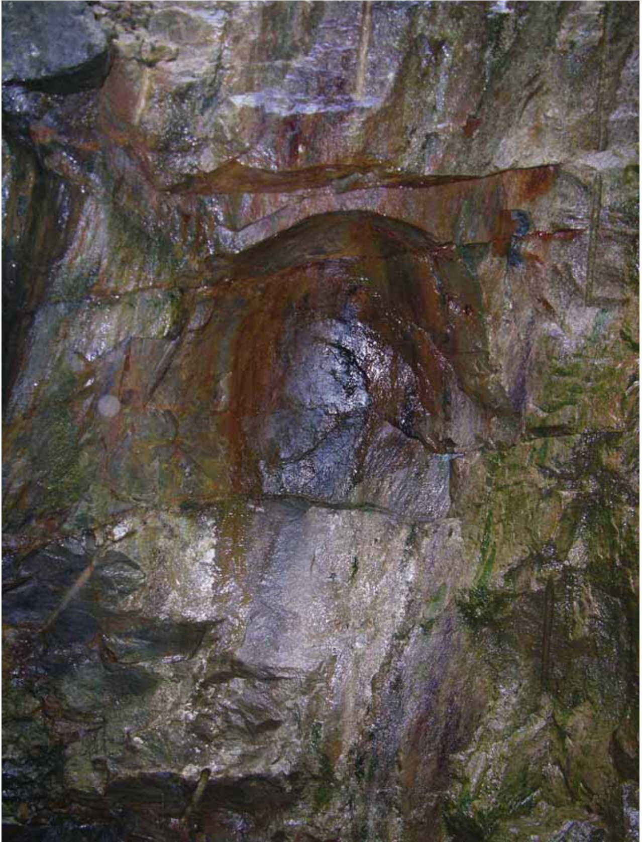
Fig 170. En rund fördjupning efter tillmakning i Knuts schakt som blivit kvar även fast man senare borrar och sprängt i schaktväggen. Foto: V Palm, KLM/VM.
