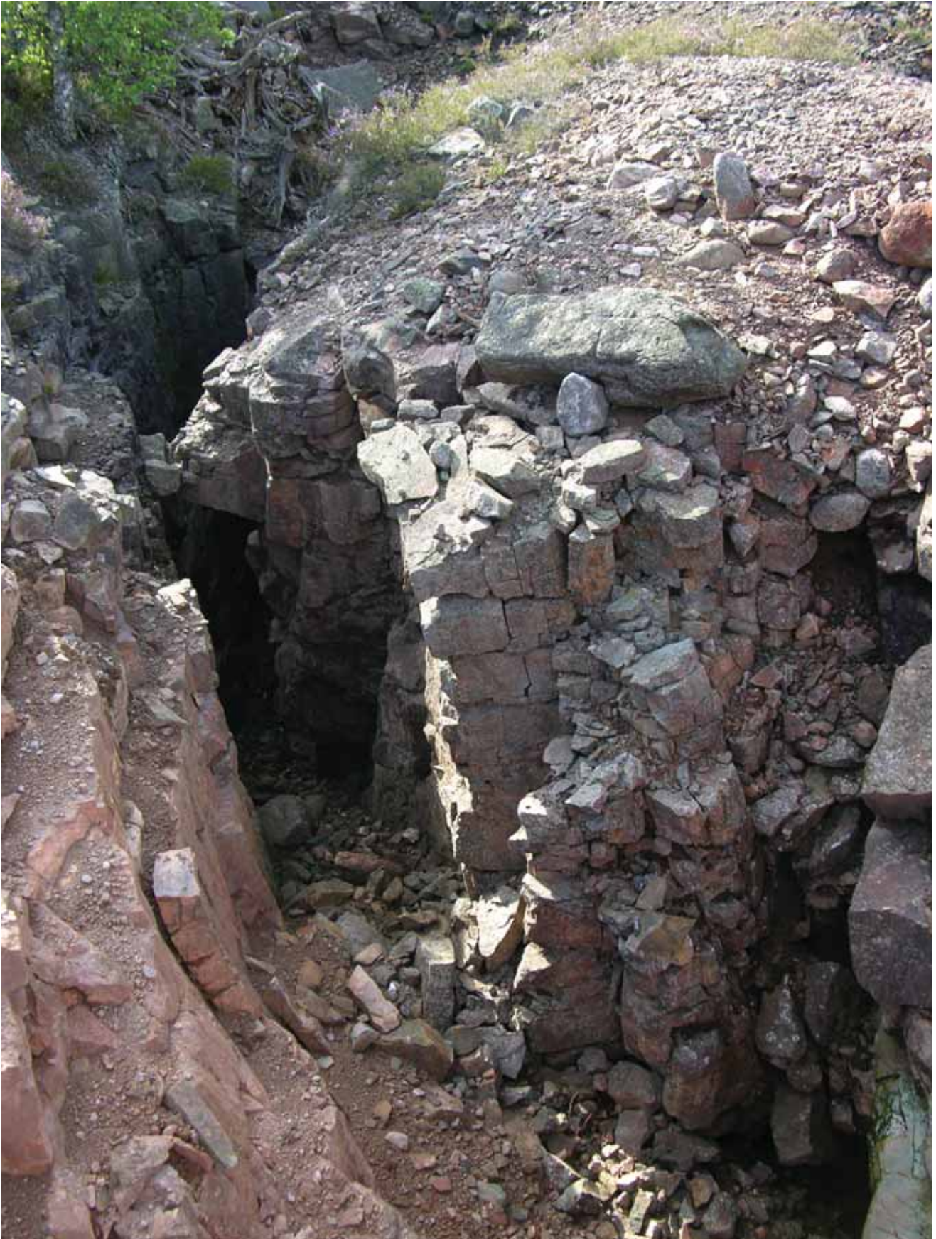
Fig 95. I Holländaregruvans övre del syns det spruckna och bitvis lättbrutna berget. Foto: V Palm, KLM/VM.
