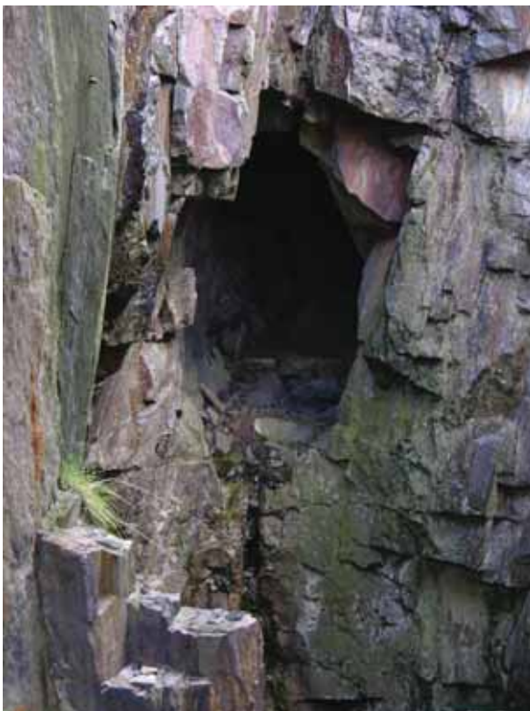
Fig 177. Tillmakad ort i Gamla gruvan. Utanför finns borrarspår och flikiga vassa partier efter sprängning. Foto: F Sandberg, KLM/VM.
