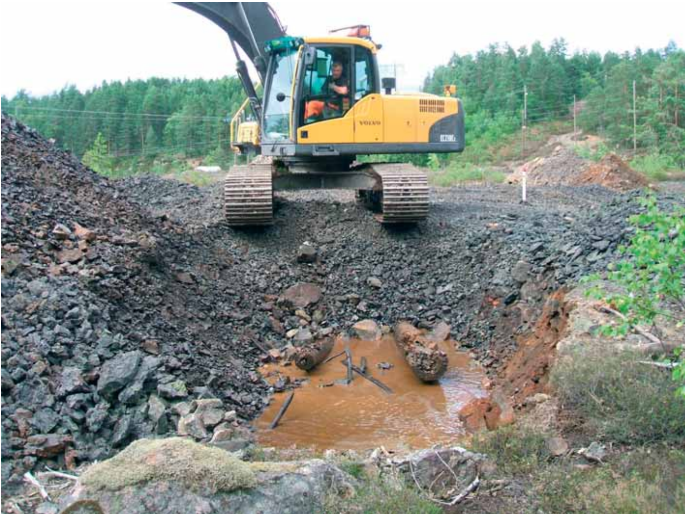
Schakt 17. Inge Bäck, Västerviks grävmaskiner, schaktar fram två pipstockar i norra delen av schaktet. Foto: E Carlsson.
