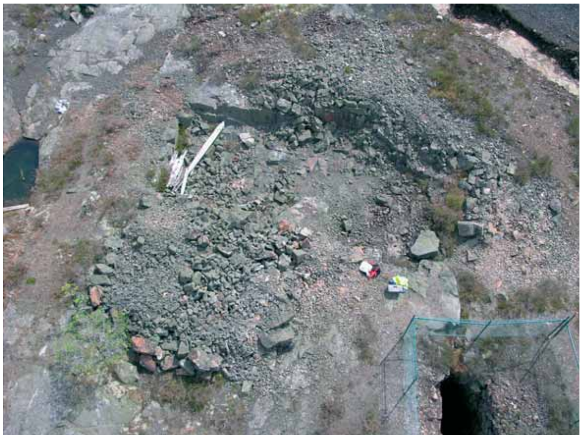
Den stora skärpningen Ho40 med sitt intilliggande fundament sett från skylift. Foto: V Palm.
