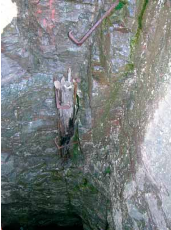
Rester av timmerskoning i Knuts schakt, troligen från den senaste provbrytningen på 1950-talet. Foto:V Palm.
