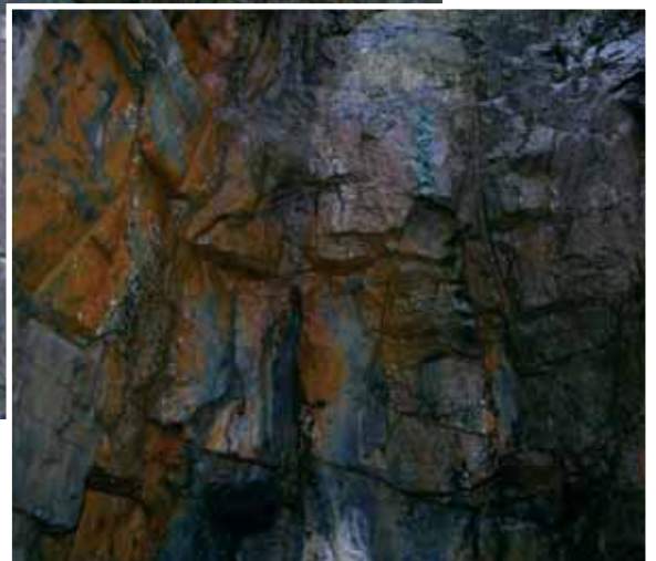
Borrspår i schaktväggen till Odelmarksgruvan. Foto:V Palm.
