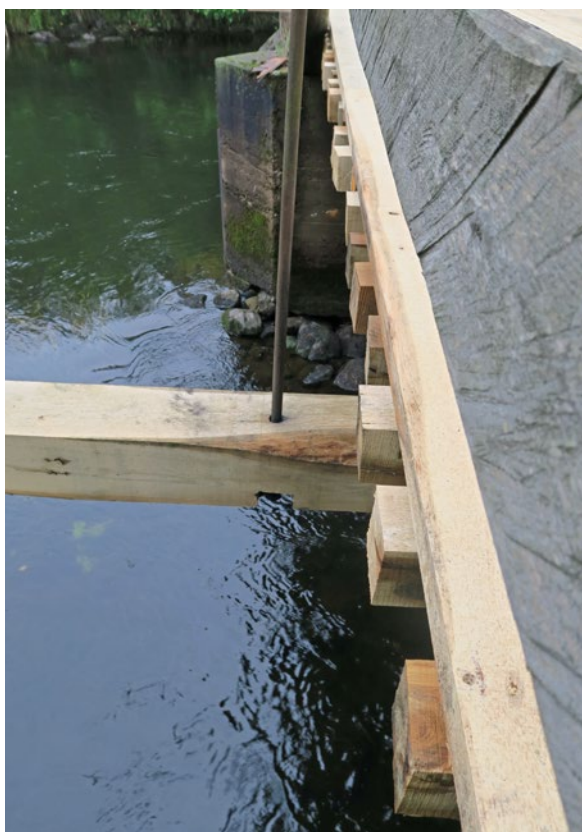
Eksyillarna efter renovering. Dess varierande längd gör att de sticker ut olika mycket vid sidan av bron, precis som tidigare. Foto: Ellen Olsson.
