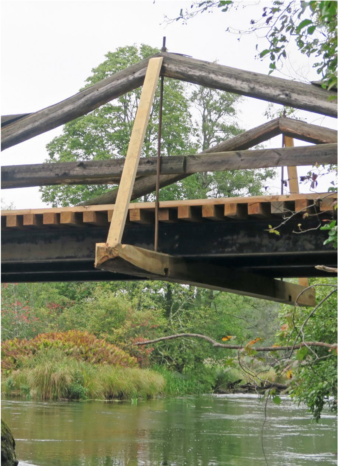
Bärlina och snedsträva efter renovering. Foto: Ellen Olsson.
