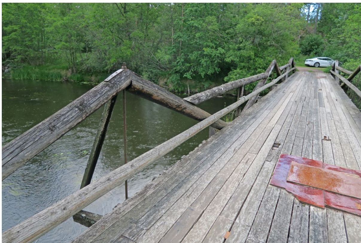
Bärlina och snedsträva före reovering. Notera gängstången som går upp genom broräcket samt järnplattan och muttern som håller den på plats.
