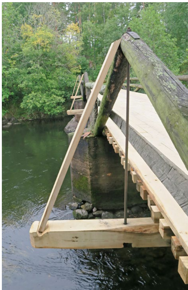
Bärlinor och snedsträvor efter renovering. Foto: Ellen Olsson.
