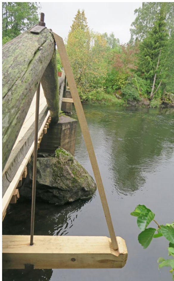
Bärlina och snedsträva efter renovering. Den gamla gängstången, järnplattorna och muttrarna har återanvänts. Foto: Ellen Olsson.
