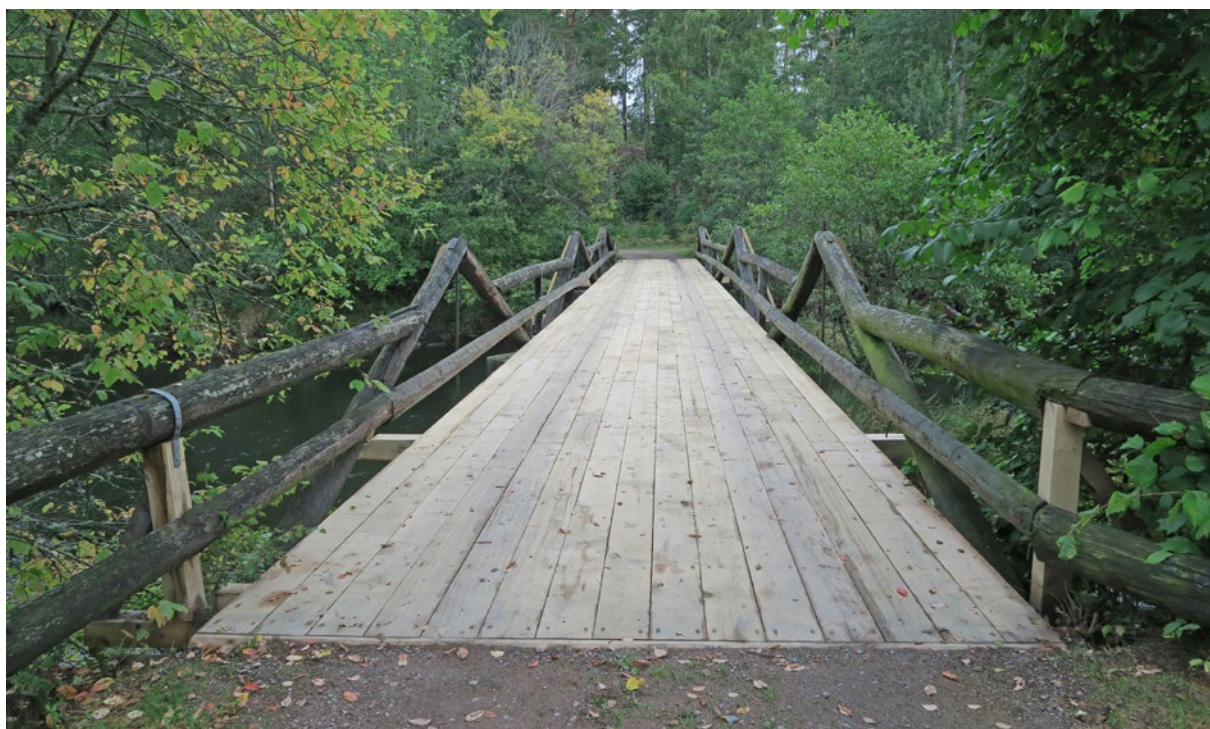
Körbanan efter renovering. Foto: Ellen Olsson.
