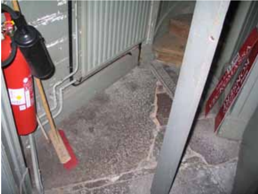
Gravhäll 43 från insidan av läktarunderbyggnaden och orgeltrappan.
