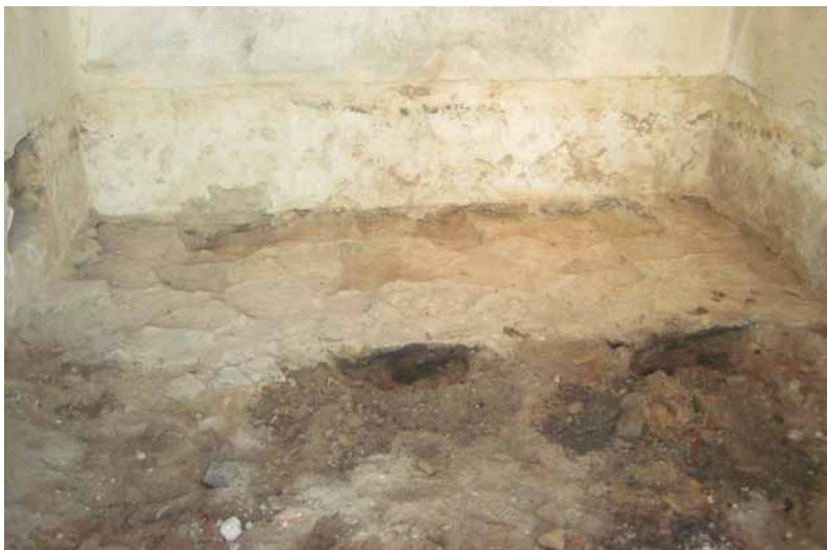
Fig 3. Kalkbruksläggningen, troligen från renoveringen på 1920-30-talet.
