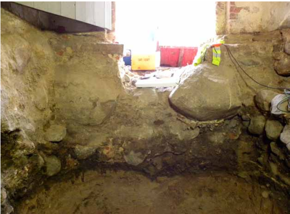
Fig 9. Under dörröppningen ut mot Borggården syntes samma rivningslager som fanns i resten av rummet.
