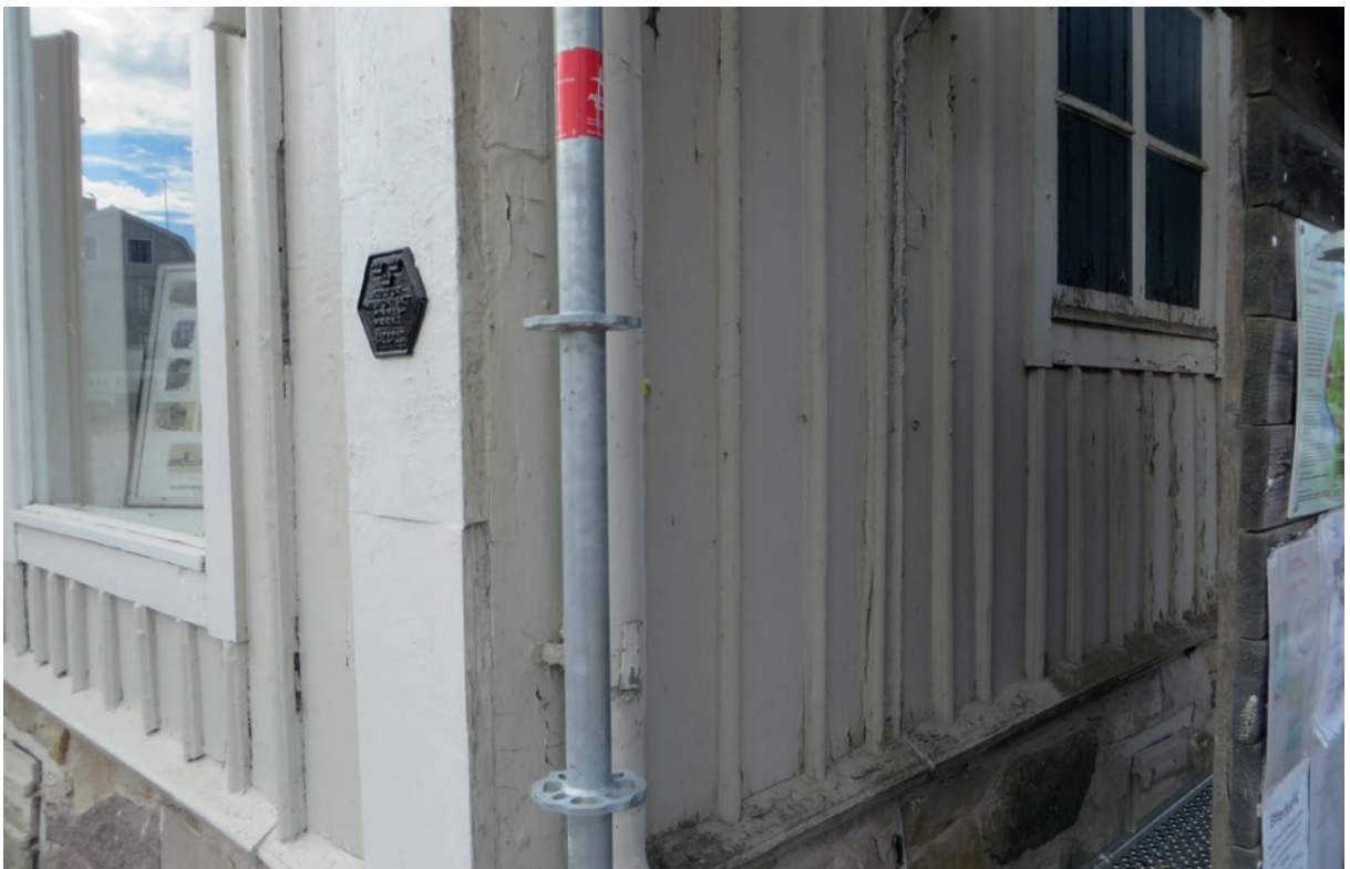
Referensyta sparades vänster om det sydligaste fönstret på andra våningen och vid norra knutbrädan.
