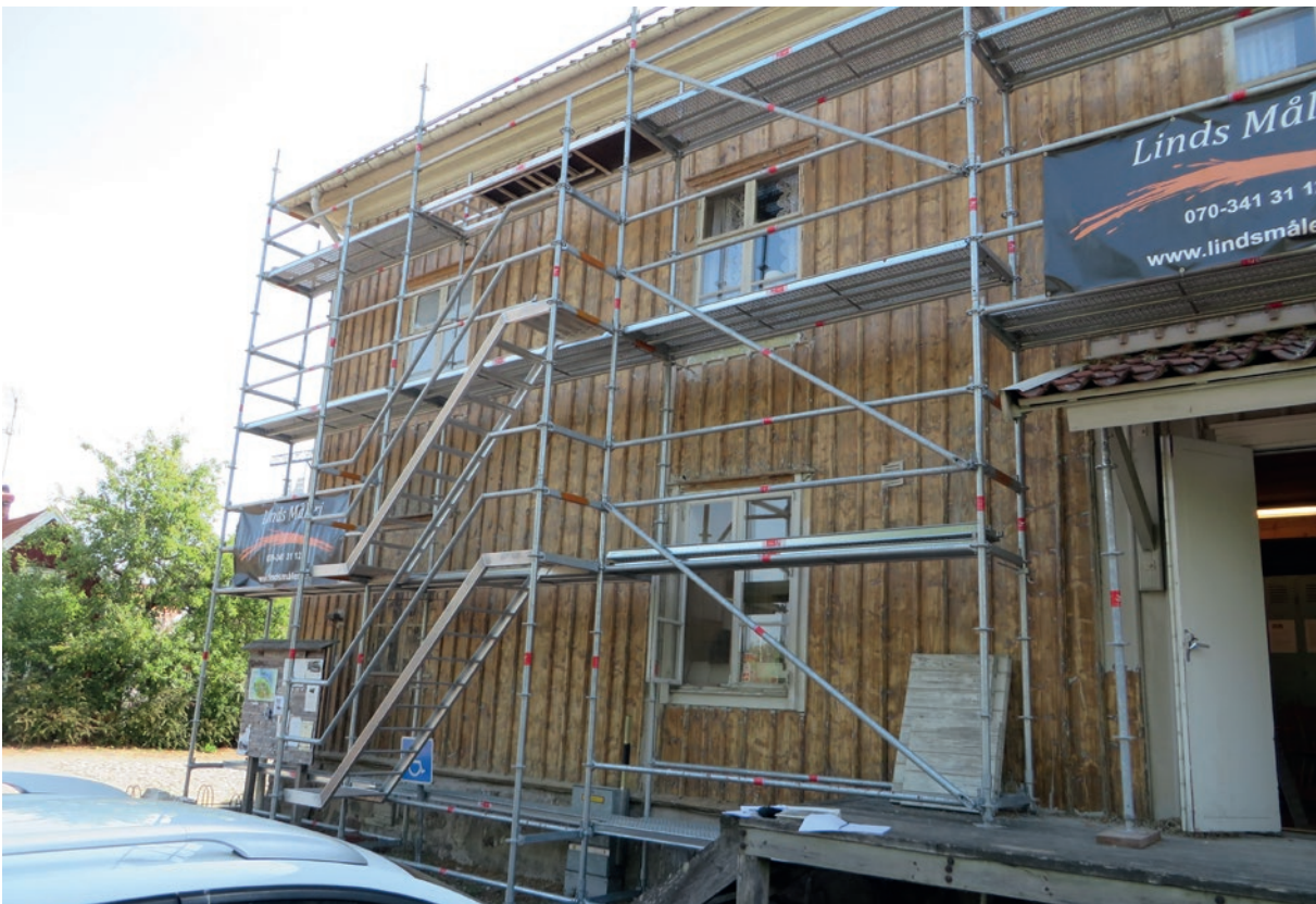
Renskrapning av fasader, utom takfot.
