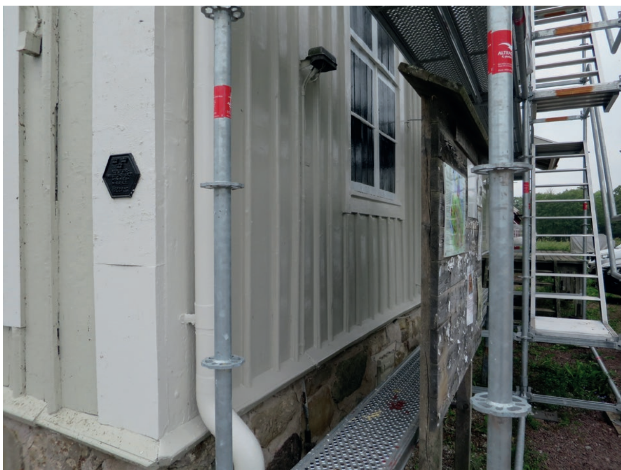
Referensytan som sparades vänster om det sydligaste fönstret på andra våningen och vid norra knutbrädan. Här övermålade med linoljefärg efter utfört arbete.
