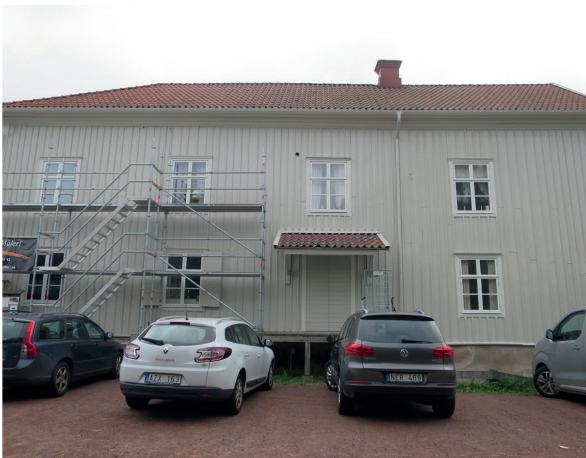
Västra fasaden efter ommålning.
