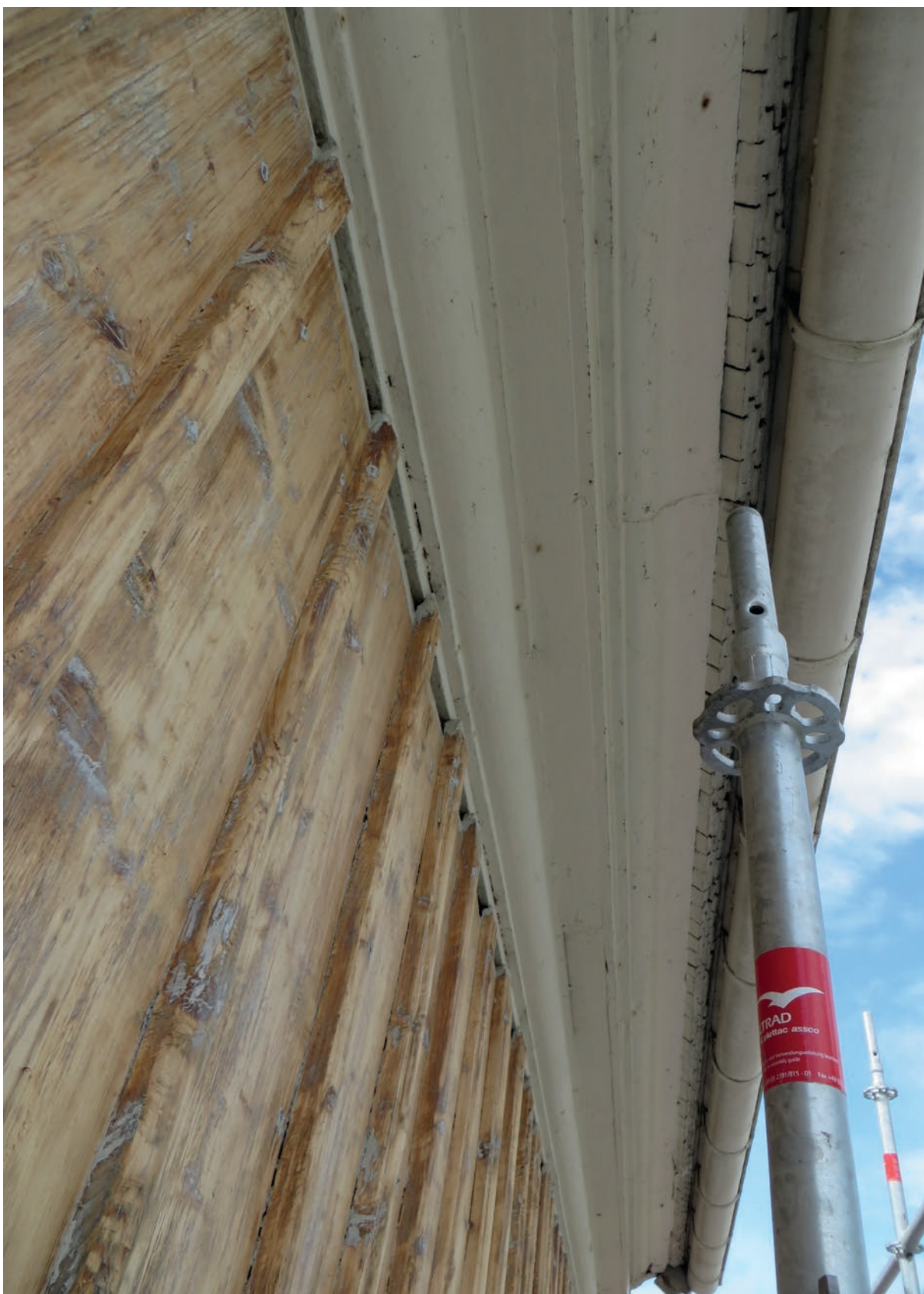
Renskrapning av fasader, utom takfot.
