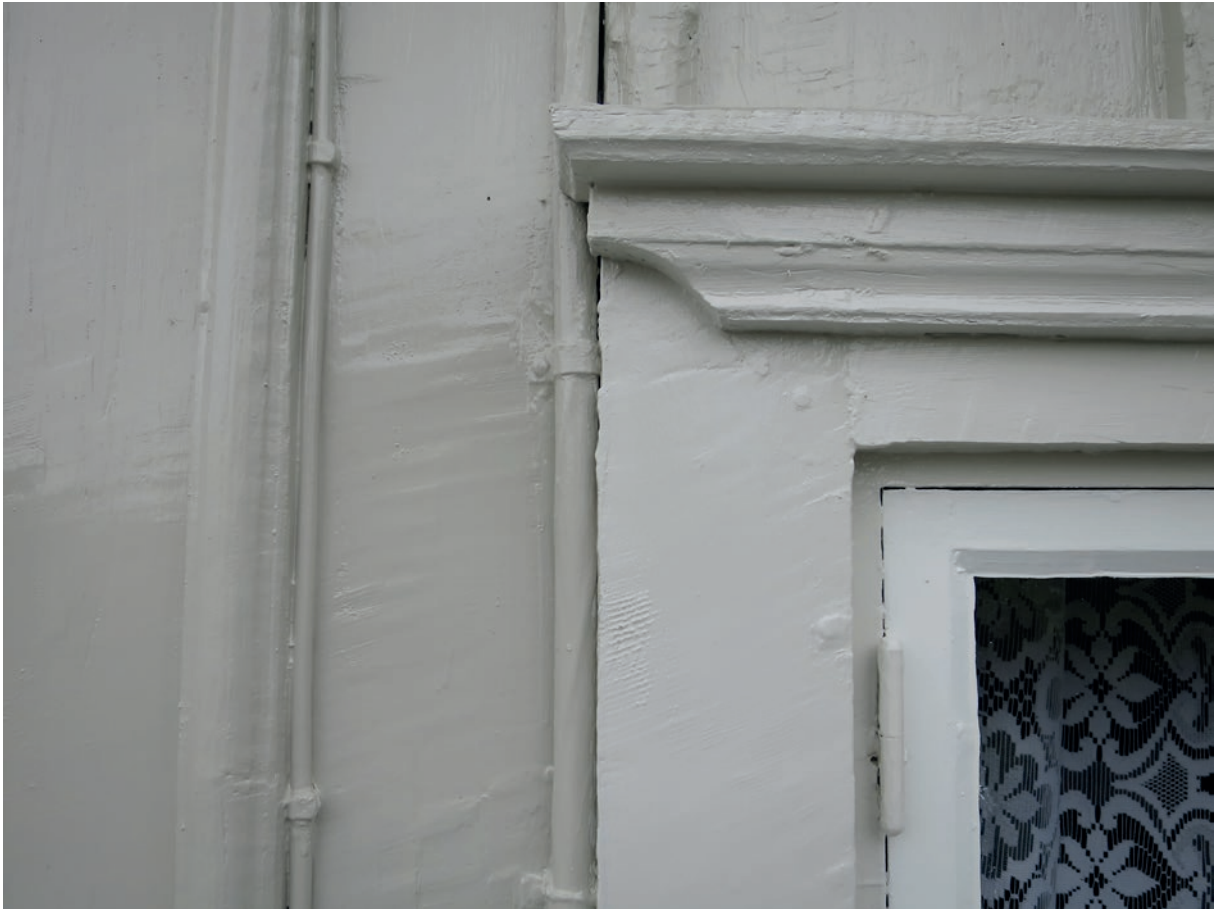
Detaljbild på fönsterbåge, fönsterkarm, fönsterfoder och fasad efter ommålning.
