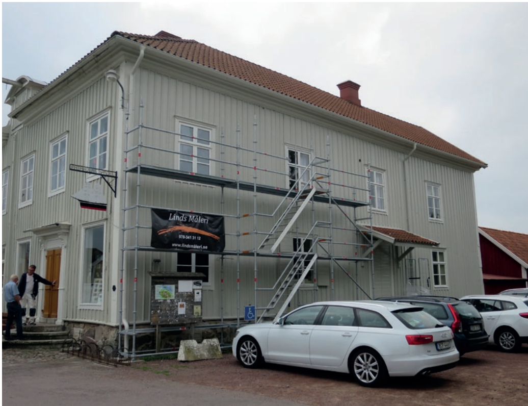
Västra fasaden efter ommålning.
