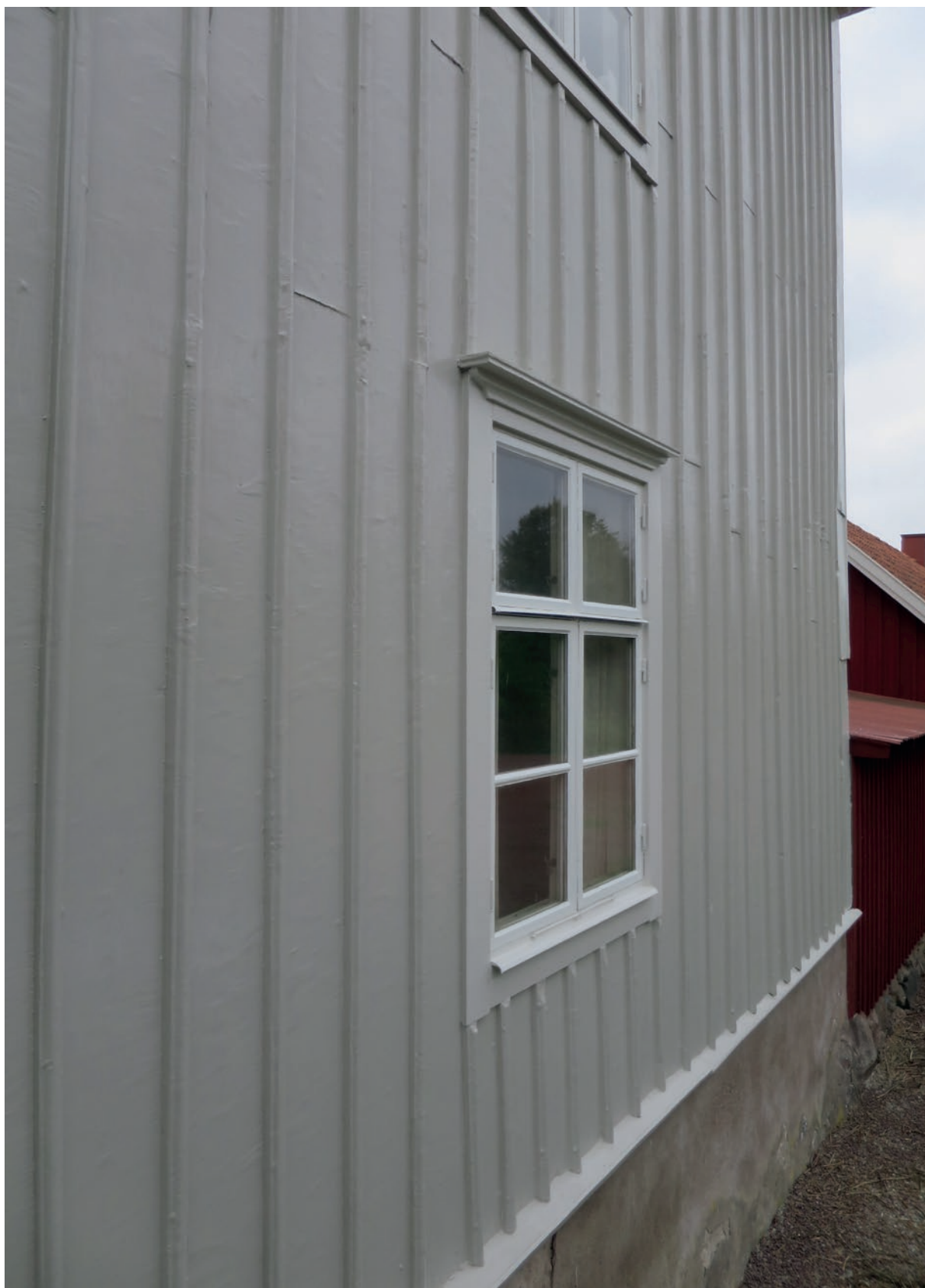
Västra fasaden efter ommålning.
