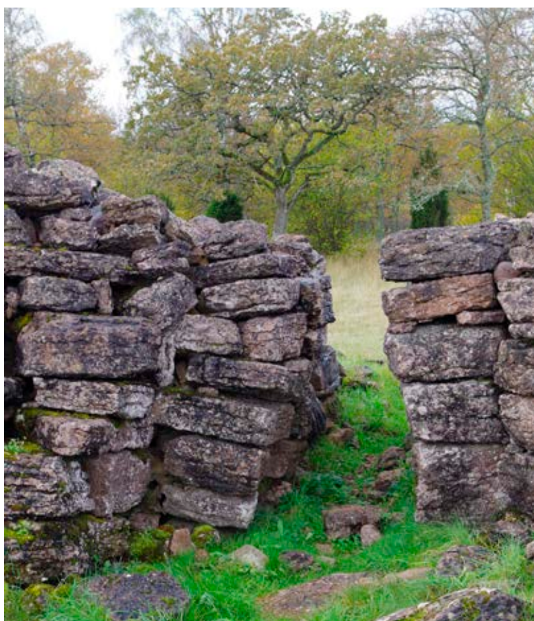
Figur 4. Bilden visar att den största sättningen hade skett i den del av ingången som vette inåt borgen.
