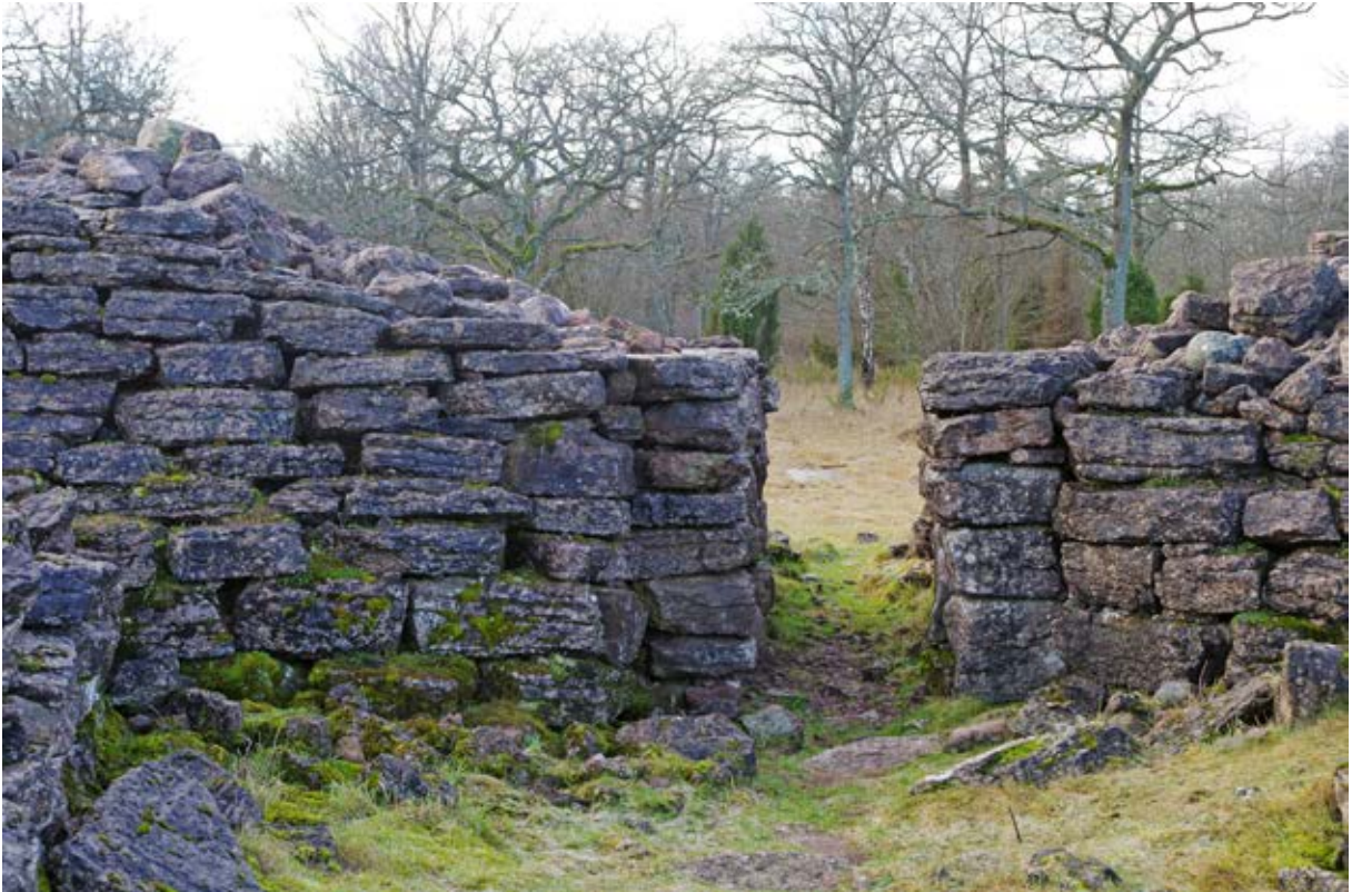
Figur 5. Den färdiga porten efter restaurering.
