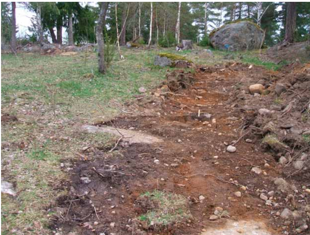
Fig. 21. Schakt 8 sett från syd. I schaktet syns även A1. Foto: JTherus, KLM.
