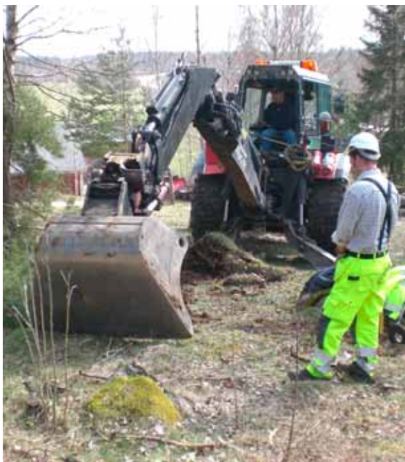
Fig. 20. Jhonny Therus övervakar sökschaktningen i sydslutningen. Foto: V Palm, KLM/VM.
