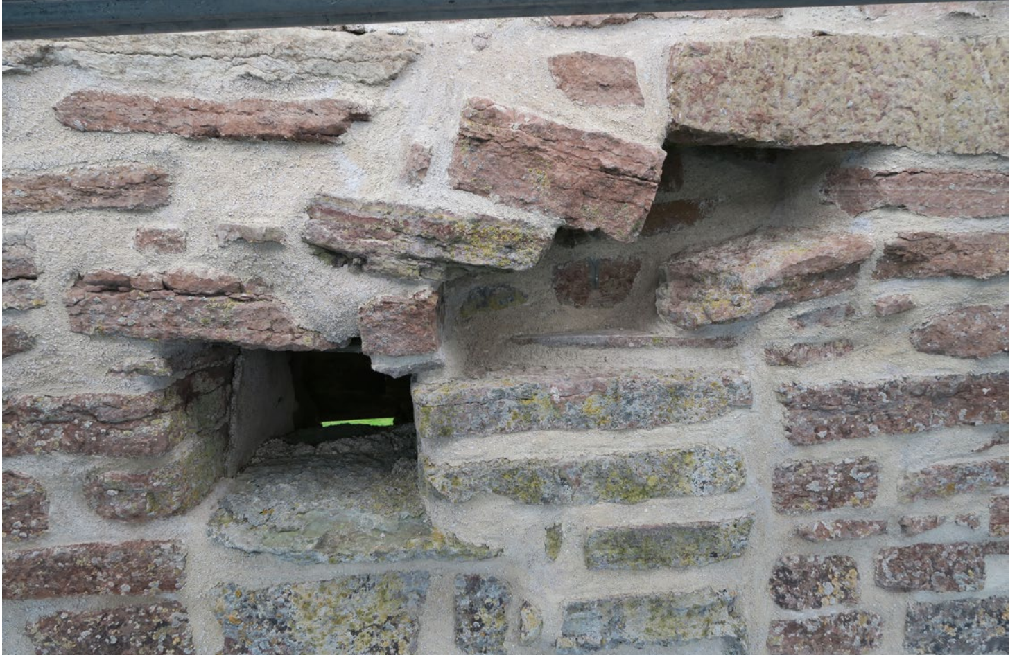
Nya kungshuset, fasad mot väster samma murparti som ovan men efter genomförd renovering.
