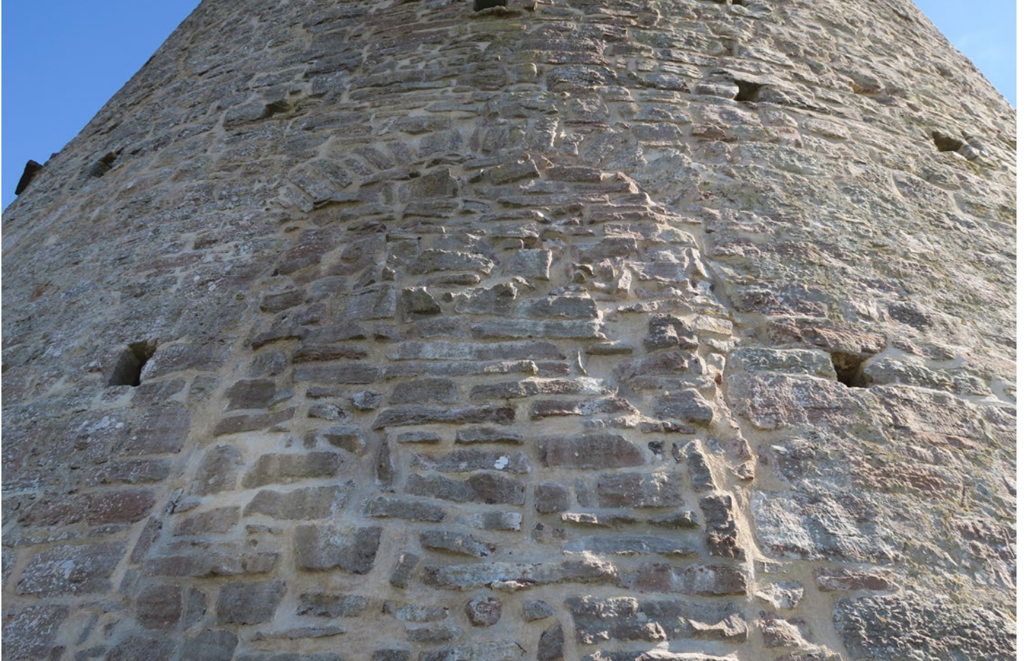
Jungfrutornet före renovering, fasad åt väster. Igensatt fönsteröppning 131 f2x, sektion III.
