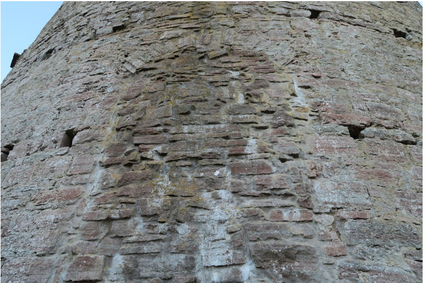
Jungfrutornet före renovering, fasad åt väster. Igensatt fönsteröppning 131 f2x, sektion III.
