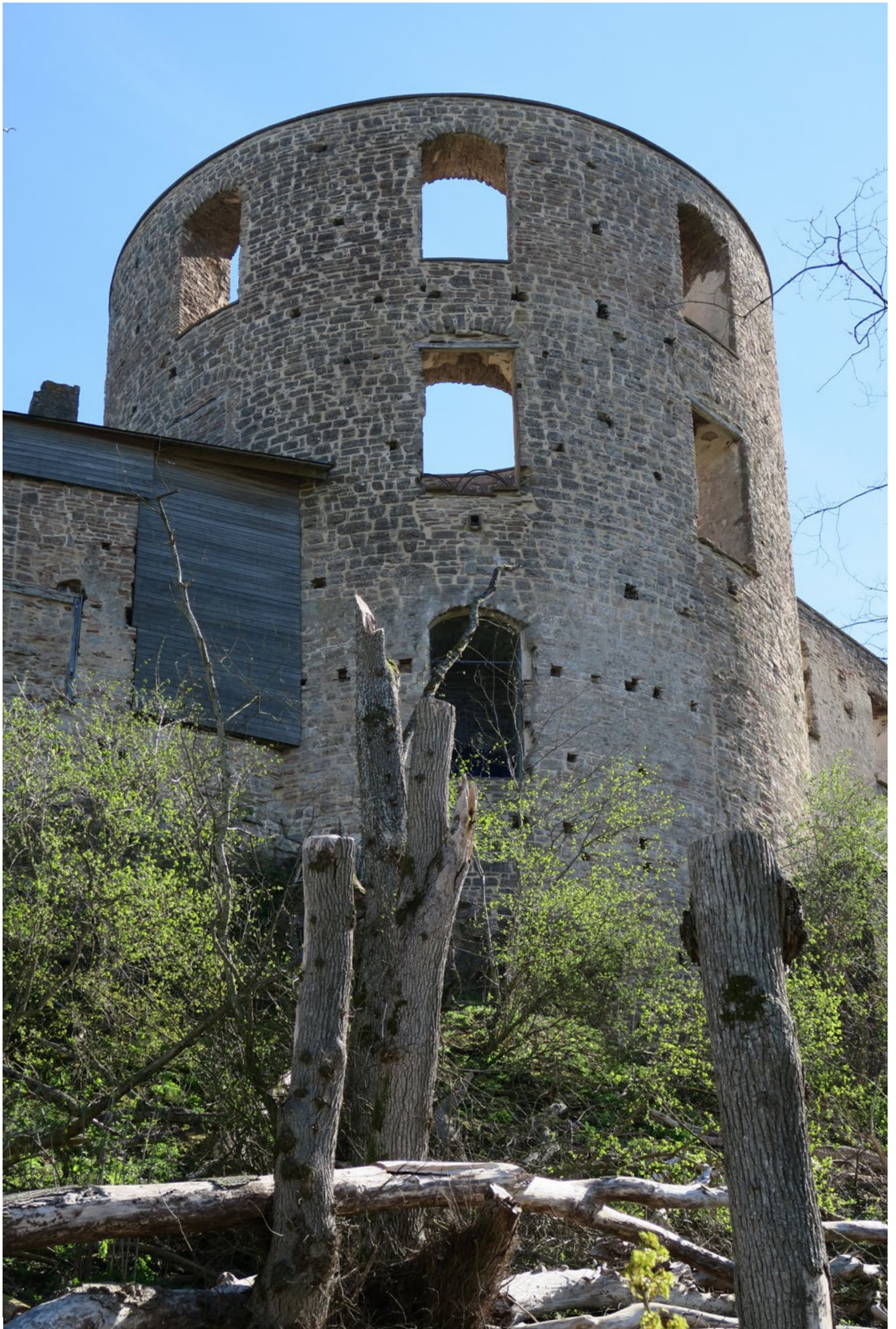
Jungfrutornet efter genomförd renovering, fasad åt väster.
