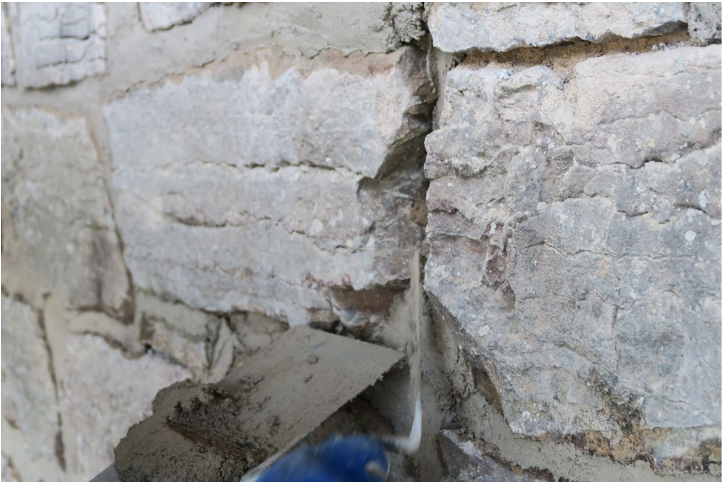
Det hydrauliska kalkbruket används till fogning.
