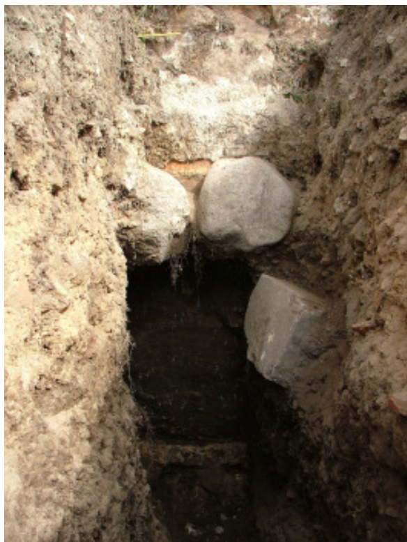
Fig 6. Profil i linje med kyrkans grundmur. Stenarna som stack ut cirka 0,4 m djupt.
