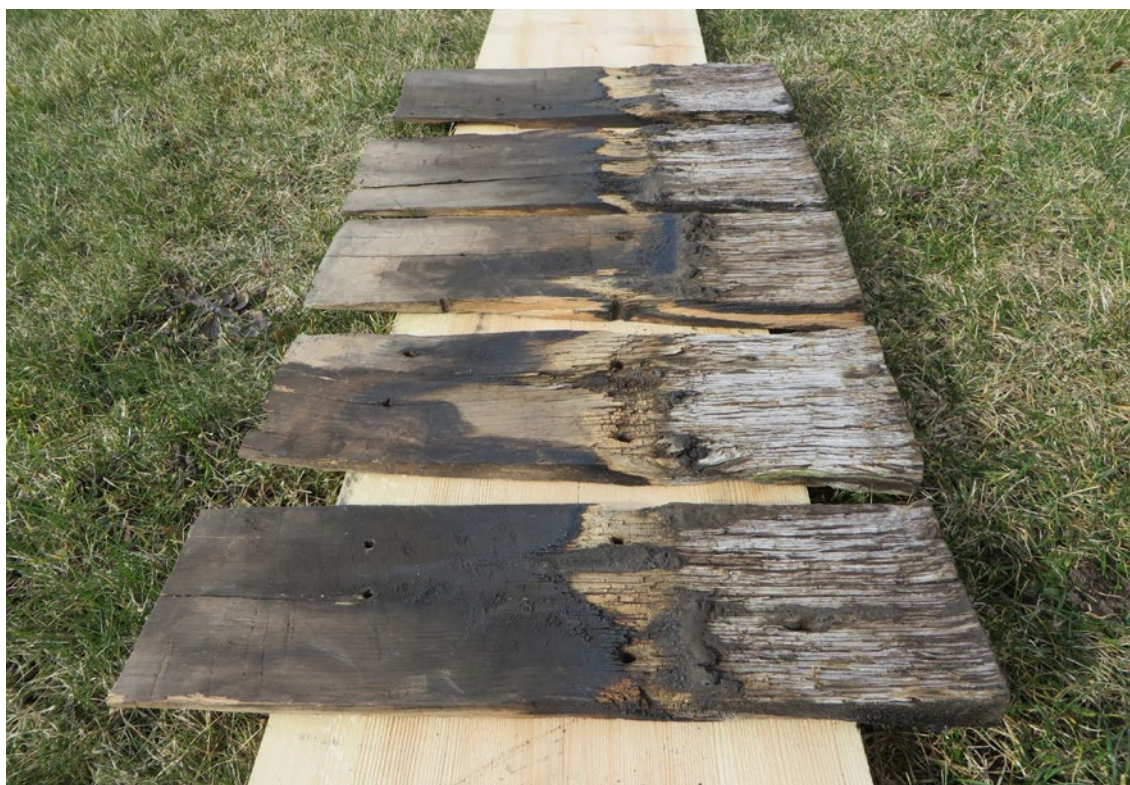
Detaljbild av ovansidan på spån som tillvaratagits från absidkoret. På de båda spånen närmast i bild syns två rader spikhål.
