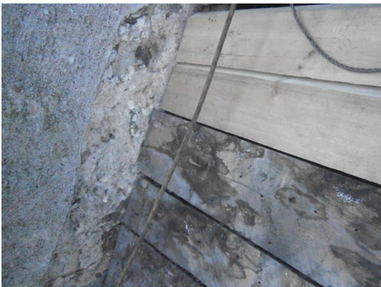
Skadade delar av sakristians svall har bytts ut. Foto: Hälsinge takspån.
