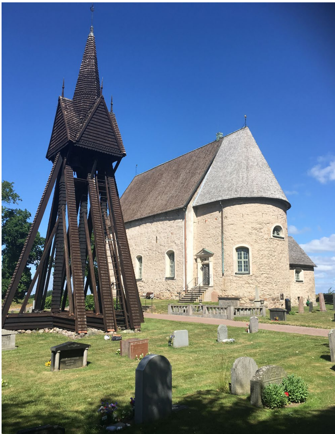
Kläckeberga kyrka efter spåntaksrenovering. Foto: Ellen Olsson.
