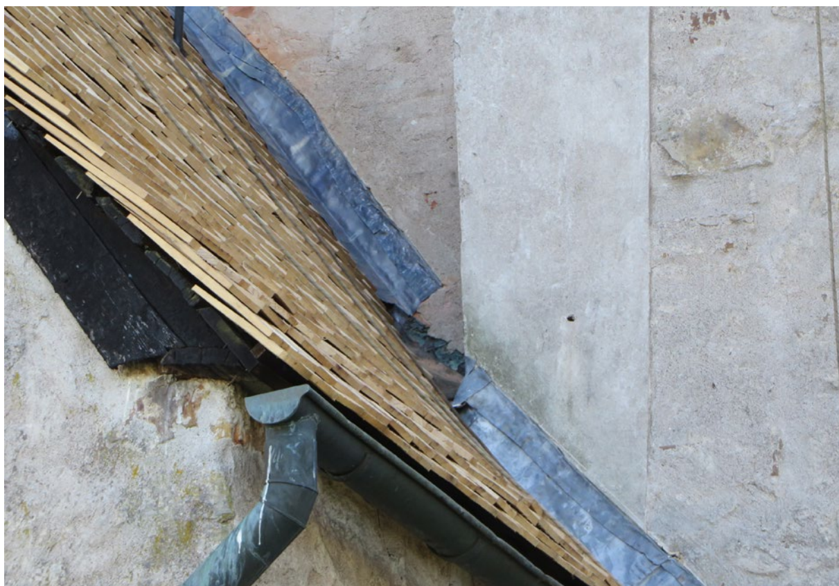
De nya blyplåtarna i mötet mellan sakristians tak och korets samt långhusets fasad.
