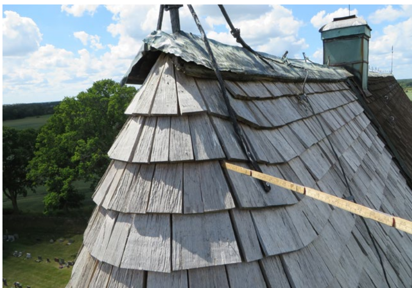
Korets topp fotograferad från lift vid besiktning 2017-06-27. Toppen saknade skyddande plåt mot öster. Tumstocken markerar spån med olämplig placering av skarvarna, rakt ovanför varandra.
