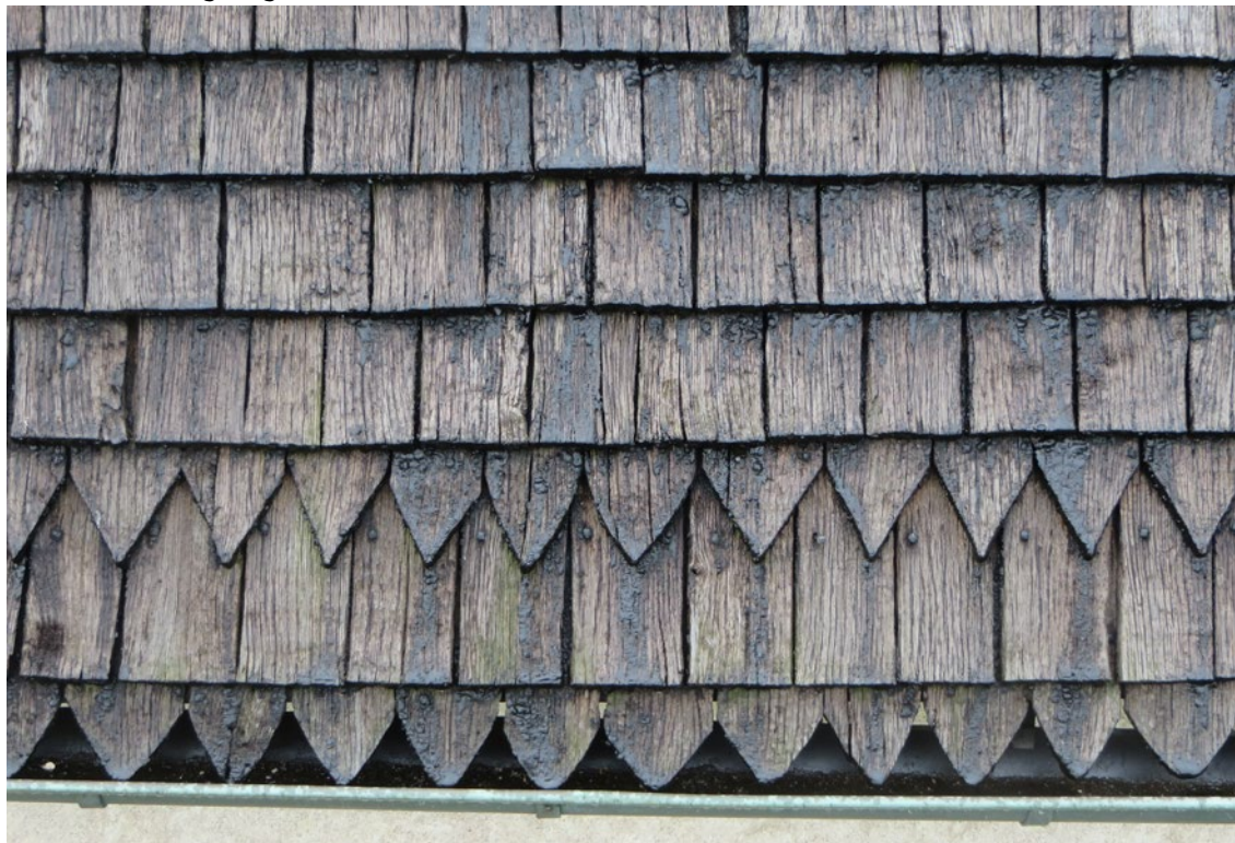
De nedre spånskiften på kortakets södra sida före renovering. Notera de synliga smidda spikarna vid sidan av det tredje skiftets spetsiga spån.
