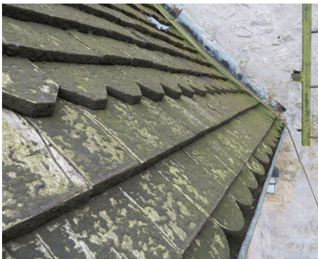
Sakristians västra takfall före renovering.
