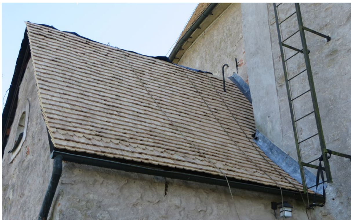
Det nylagda spåntaket på sakristians västra takfall.
