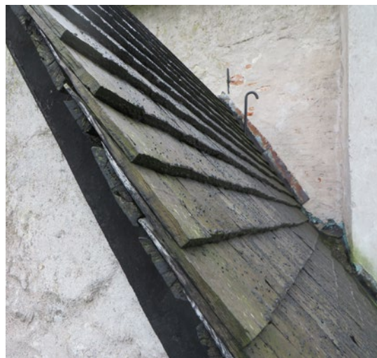
Sakristians kilformade takspån före renovering.
