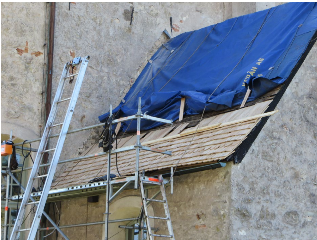
Pågående omläggning av sakristians östra takfall.
