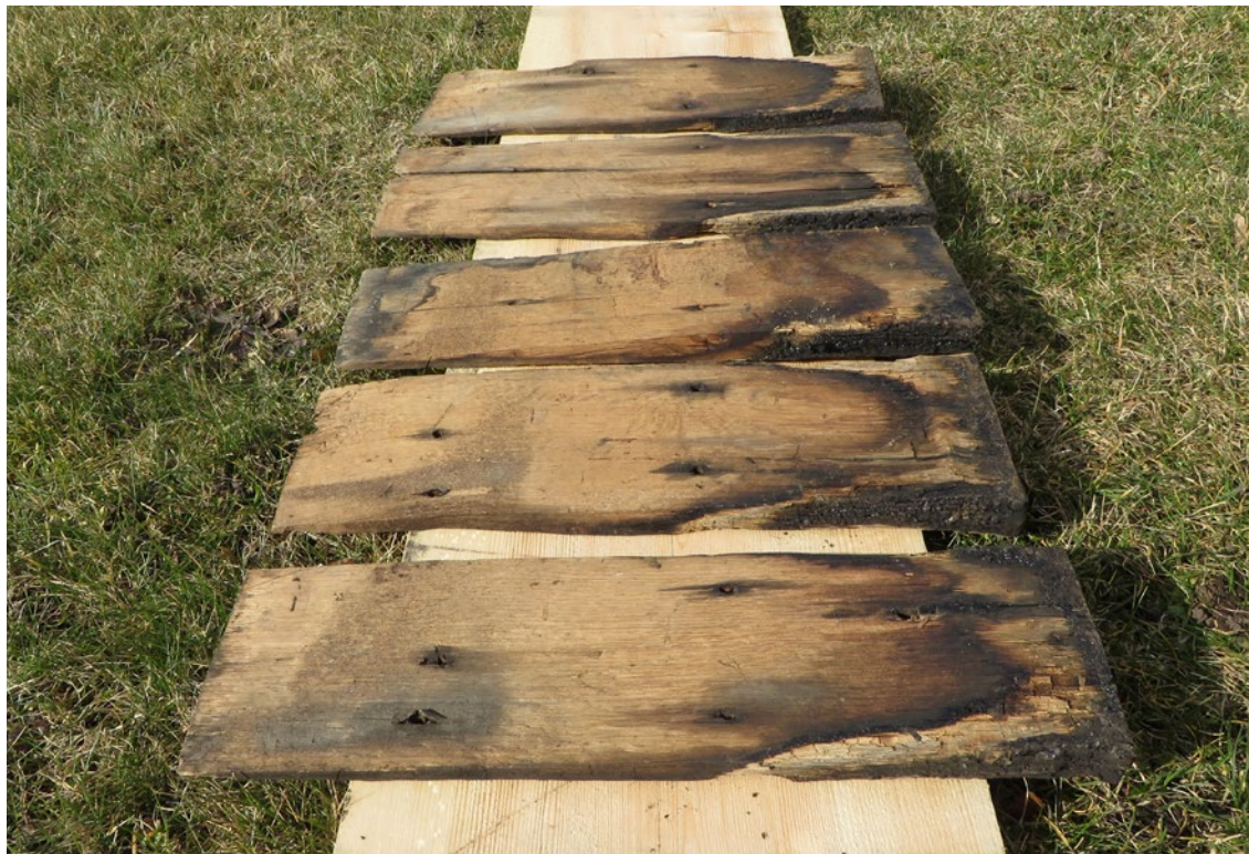
Detaljbild av undersidan på spån som tillvaratagits från absidkoret. Lägga märke till den släta ytan, tilljämnd med bilyxa efter klyvning.
