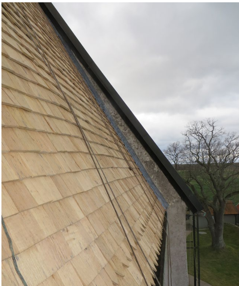
Korets topp fotograferad från lift vid besiktning 2017-06-27. Toppen saknade skyddande plåt mot öster. Tumstocken markerar spån med olämplig placering av skarvarna, rakt ovanför varandra.
