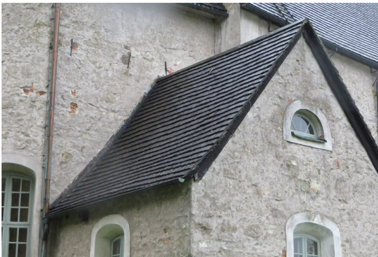
Sakristians östra takfall före renovering.
