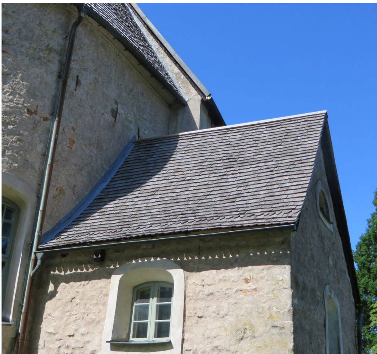
Sakristians östra takfall efter renovering.
