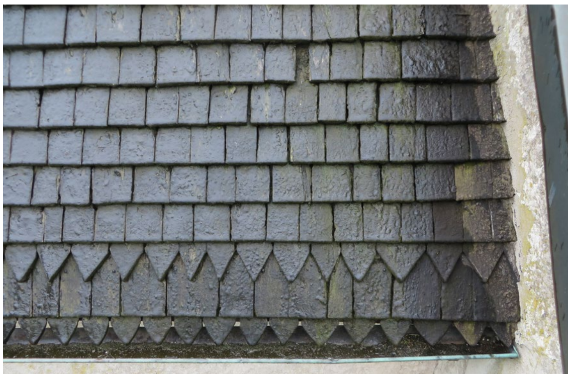
Norra sidan av kortakets spåntäckning före renovering. Till höger i bild syns långhusets östra gavel. Notera första och tredje skiftets profilerade ekspån, samt att det saknas en plåt vid anslutningen mellan kortaket och långhusgaveln.
