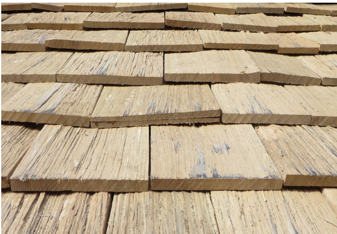
Spånets i bildens centrum har en horisontell spricka. Efter påpekande från antikvarisk expert byttes alla spån med denna typ av defekt ut.
