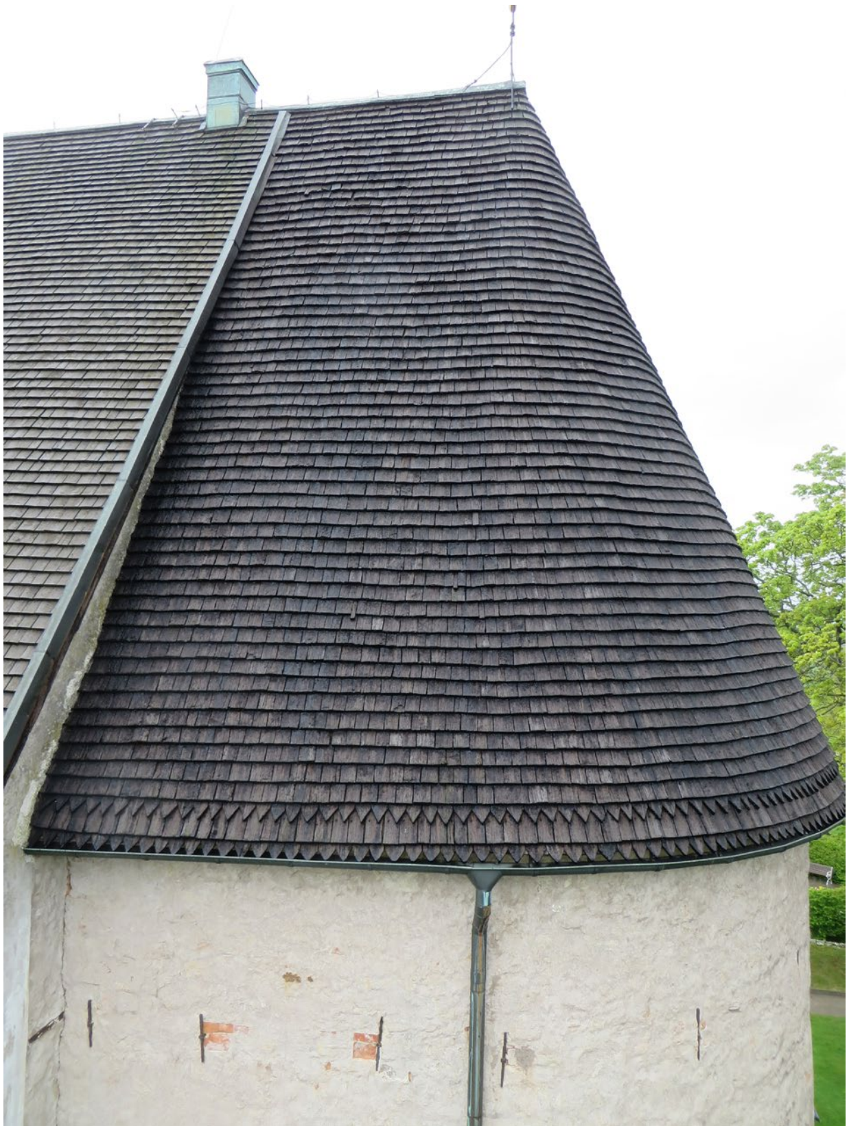
Kortakets södra sida före renovering.
