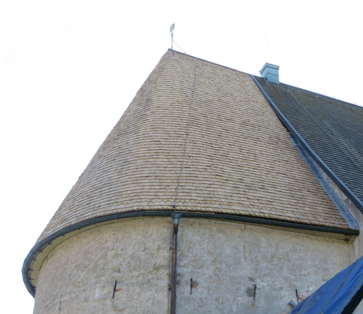
Kortaket efter renovering.
