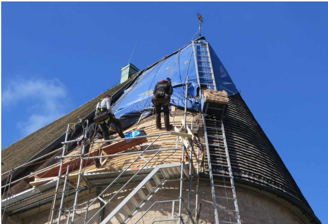
Pågående omläggning av korets spåntak mot söder.
