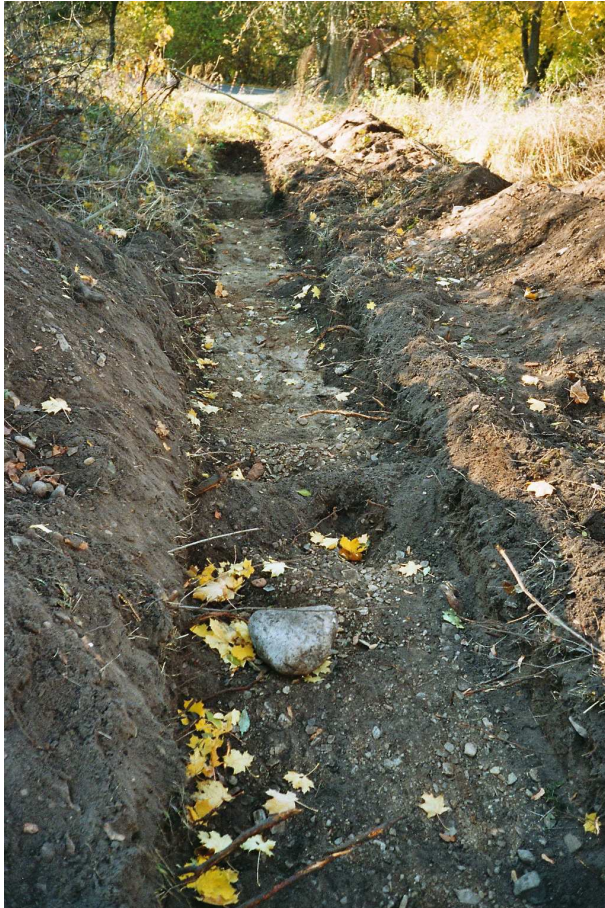
Schakt E för VA m m, nergrävt i botten, sett mot vägen. Mellan vägen och bortre schaktänden ligger kommunens VA-schakt. I schaktet ses mylla och omplöjt kulturlager, i bortre änden ett djupare skoptag. Fr ONO.
