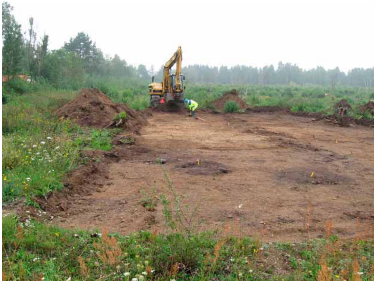
Totalavbaning av området med grävmaskin.
