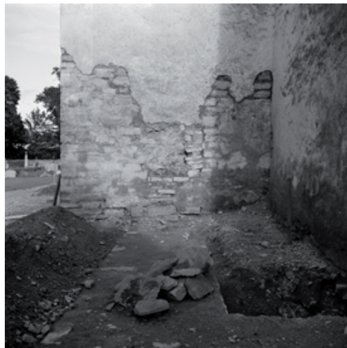
Fig 2. En bild från Boströms provundersökning i november 1952 av den medeltida torngrunden. I fonden ses den putsade väggen av 1805 års kyrka som då ännu inte rivits utan stod kvar på norra långhusväggen av medeltidskyrkan (den vänstra oputsade delen). Foto från V, R Boström, ATA.
