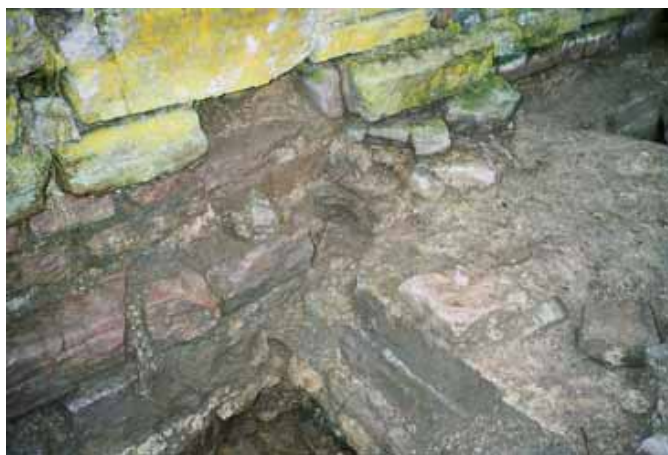
Fig 14. Vinkeln långhus – torngrund (t h), den yttre, sedan åskledaren tagits bort. Utstickande stenar från långhusmuren som går i förband i den övre delen men inte i den nedre. Från NV, H Schulze.
