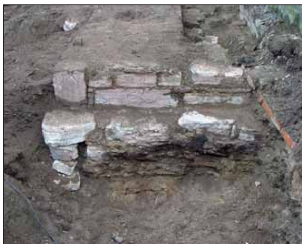
Fig 5. Den medeltida tornmurens västsida. Hörnstenen i sulan (t v) stöds av småsten då underliggande stenar rubbats på 1950-talet av VA-ledningen. På sula och grund syns svarta rester av det förhistoriska kulturlagret och till höger syns genombrytningen för elkabeln. Foto: V. Palm.
