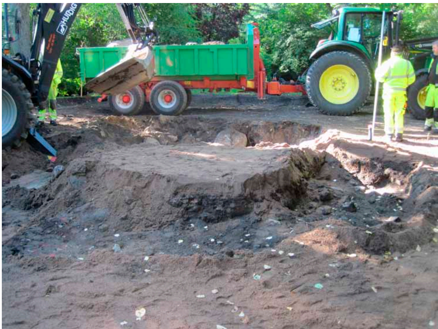
Fig 5. De två L-formade schakten inom schaktområde I. Foto från norr. Foto: N. Nilsson, KLM.
