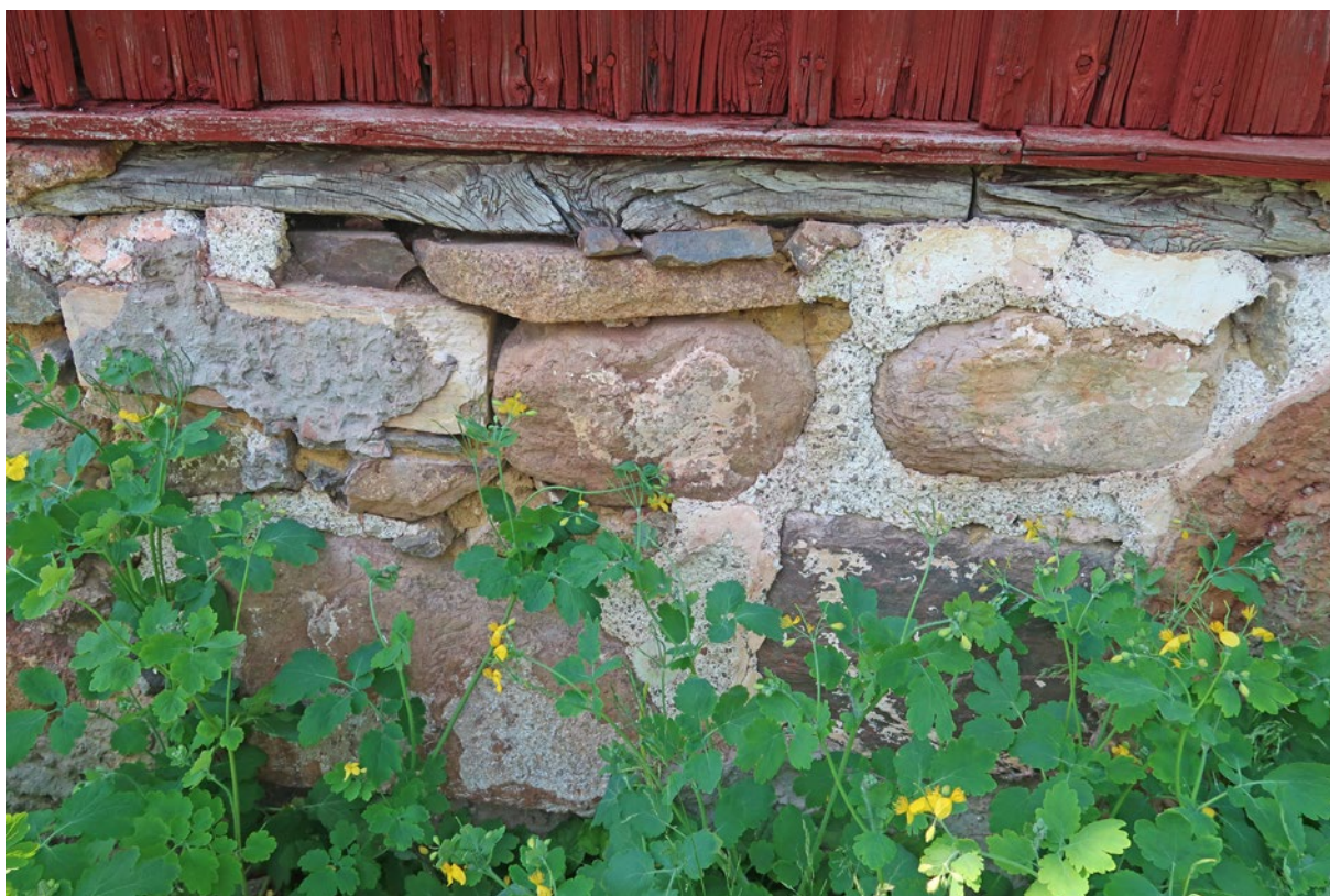
Detalj av grundsockel, som visar hur olika typer av stenar som använts. Det är tydligt att den redan från början var avsedd att vara putsad. Puts- och färgrester finns också på stenen.
