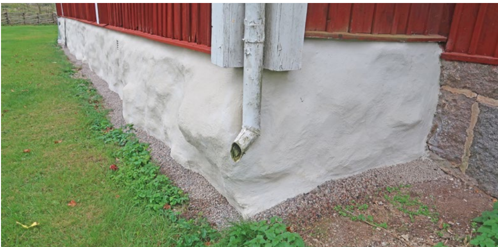
Före, under och efter. Detalj ur hörna mot nordost.
