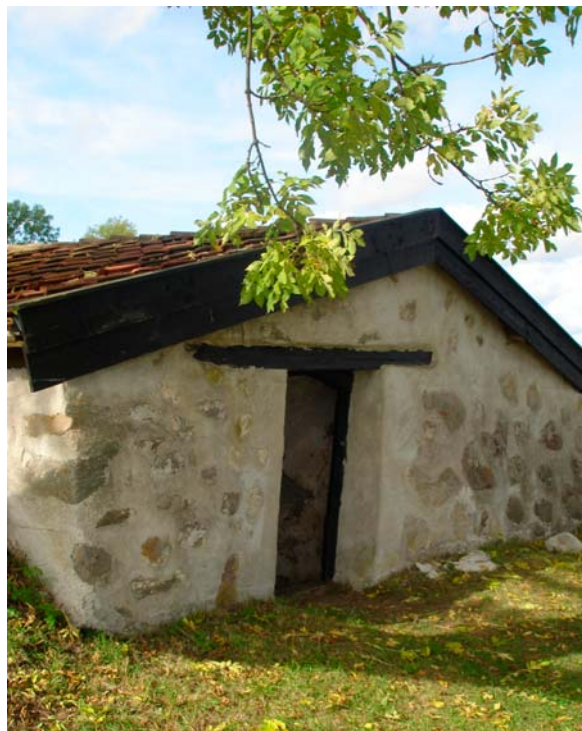
Fig 6. Källaren som antas vara uppförd före 1630.
