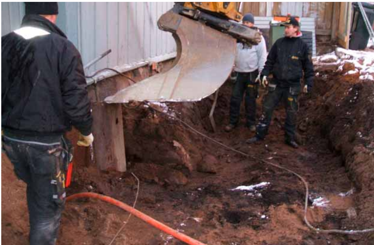
Fig 4. Stämpling mot husgrunden för att förhindra ras. Yta 2 efter undersökningen. Foto från syd. Foto: V. Palm 2008.
